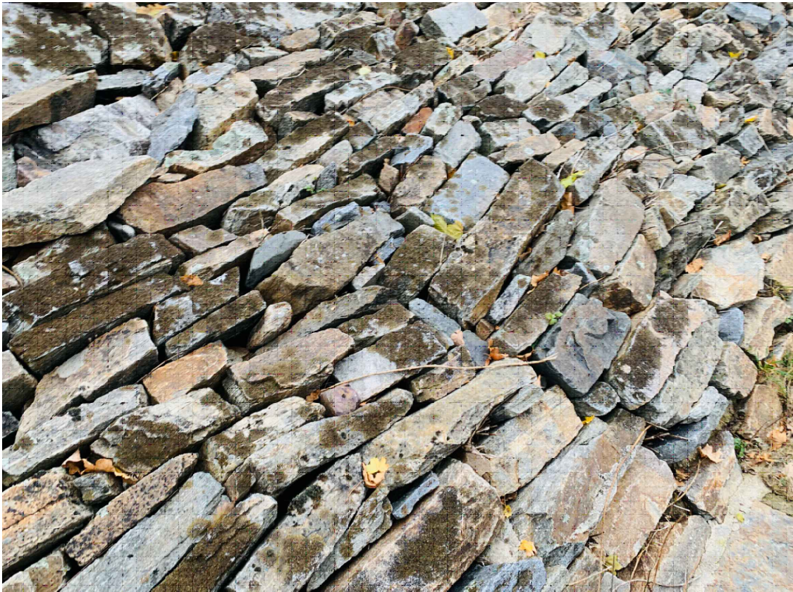
Obr. Stávající uložení kamenné dlažby na štět, způsob ložení kamene bude zachován. Použitý kámen bude mít barvu jako původní zdivo. Je důležité zajistit, aby odstín a textura byly co nejvíce shodné. Materiál bude před stavbou odsouhlasen investorem.
