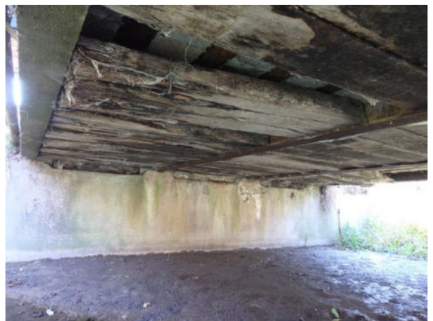
foto 4 první opěra, podhled nosné konstrukce
