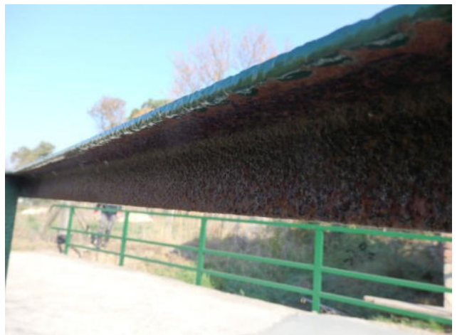
foto 8 nosná konstrukce, koroze
