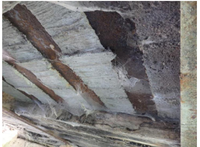
foto 8 nosná konstrukce, koroze
