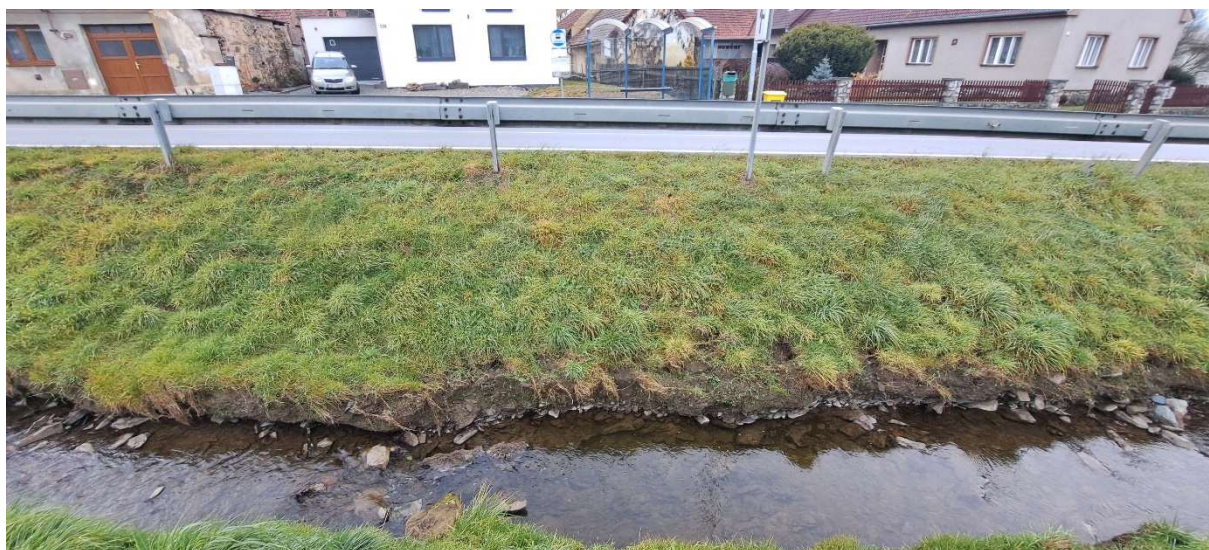
7. U4 - Průběh úseku s patrnými nánosy a porušenými patami
