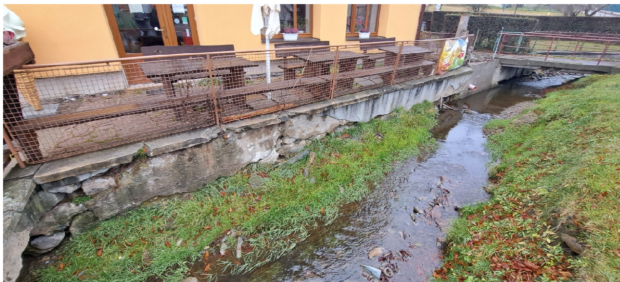
4. U2 - Pohled na příčný profil koryta toku – sediment ve dně koryta
