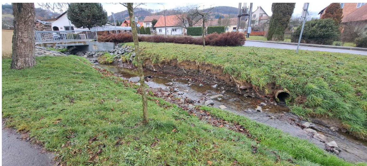
8. U4 - Průběh úseku s patrnými nánosy a porušenými patami
