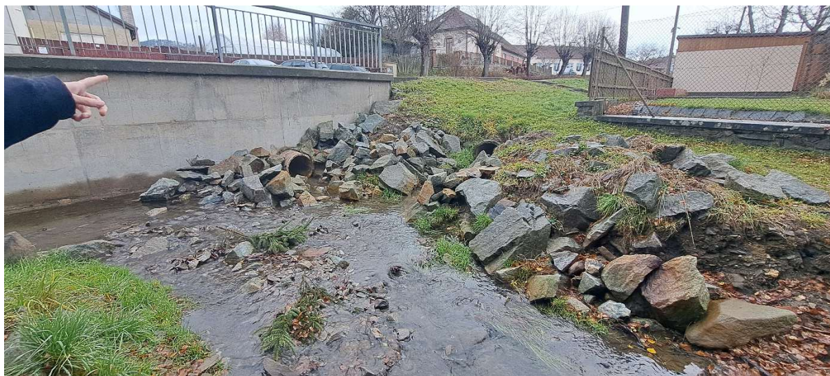
3. U2 - Konec úseku s patrným porušeným opevněním v místě vyústění dešťové kanalizace
