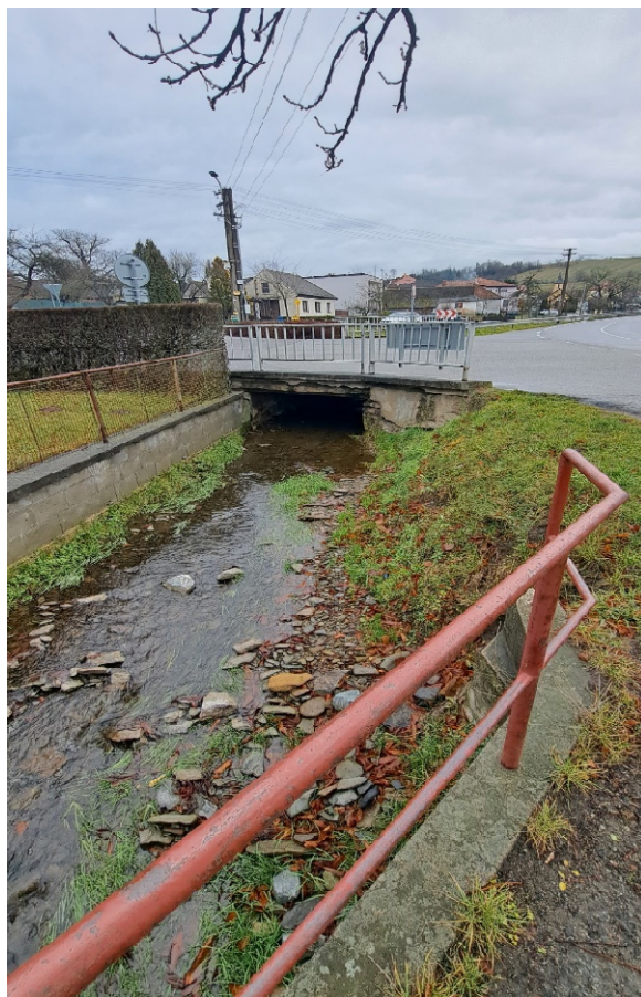
6. U3 - Pohled na příčný profil koryta toku – sediment ve dně koryta
