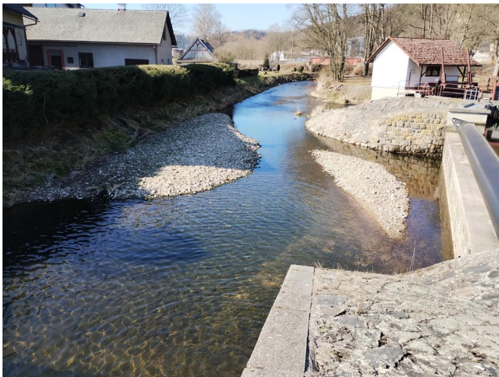
Obr. Nános pod stávající vakovým jezem v Letohradě (3/2025)
