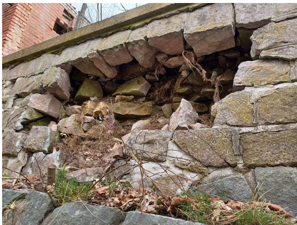
Obrázek 2: Detail poškození LB zdi (Foto: březen 2025)
