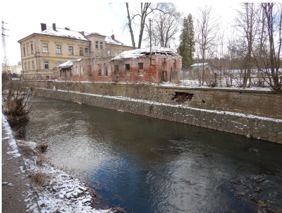
Obrázek 1: Pohled proti vodě na poškozenou levobřežní zed, která sestává z původní kamenné zdi a přízdívky obložené žulovým kamenem; v líci zdi jsou poruchy ve formě vypadlých kamenů a je rovněž poškozené spárování. (Foto: březen 2025)
