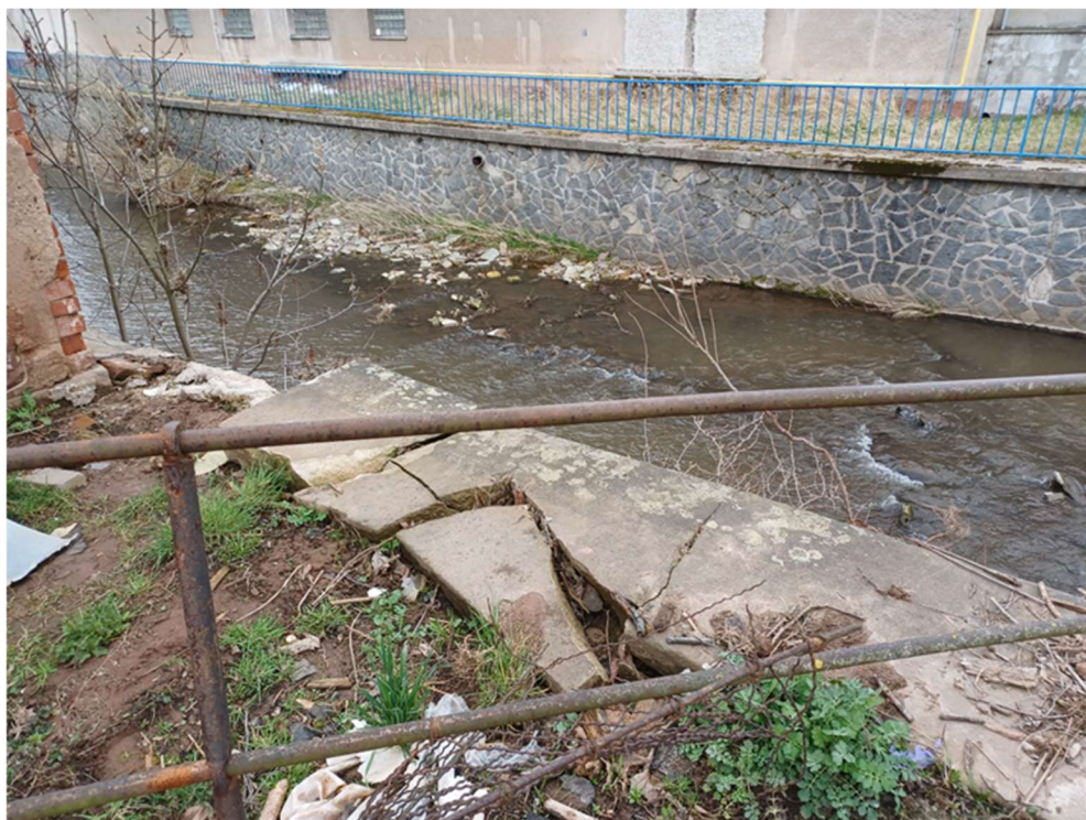
Obrázek 3: Pohled na poškozenou pískovcovou řimsu u č.p.92 (Foto: březen 2025)
