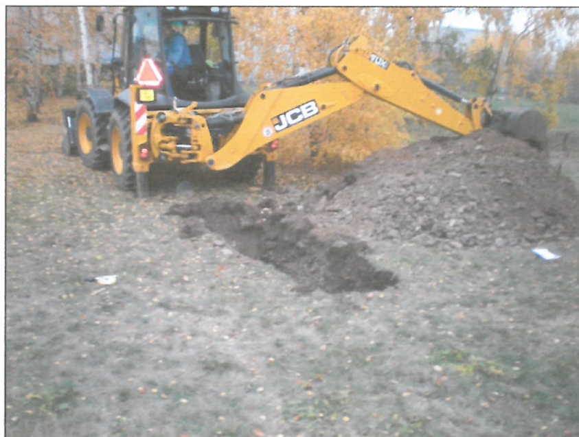
Průzkumná kopaná sonda na pozemku v místech retenční nádrže
