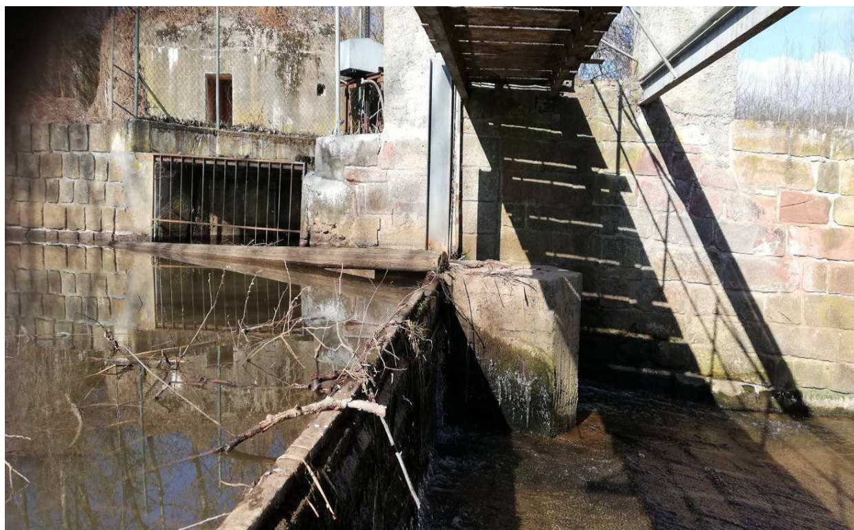
Celkový pohled na levobřežní opěrnou zed' – patrný nátok na MVE .
