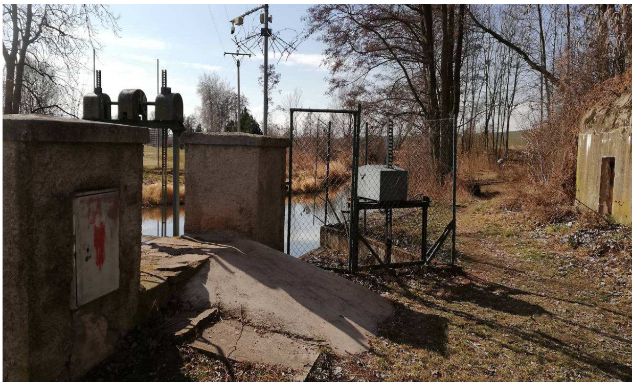
Pohled na levý břeh – nástup na lávku. V levém pilířku v rozvodné skříní, se nachází sesvorkované vedení k MVE.
