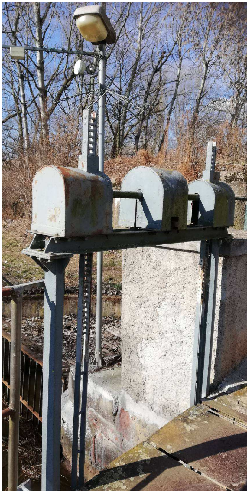
Ovládací mechanismus šterkové propusti. V pozadí el. zařízení od MVE.
