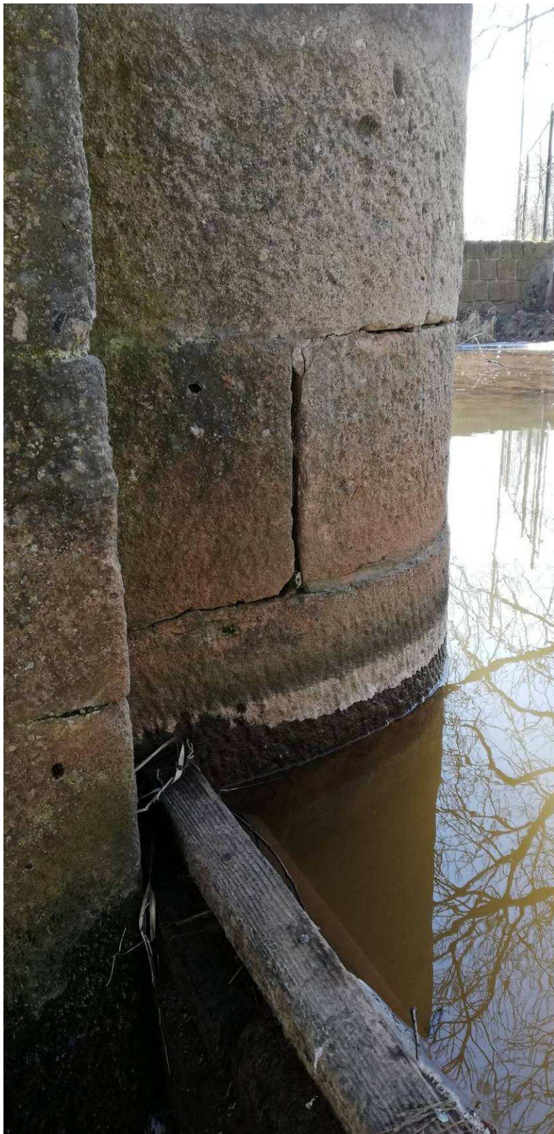
Detail celoovodové trhliny na středovém pilíři.
