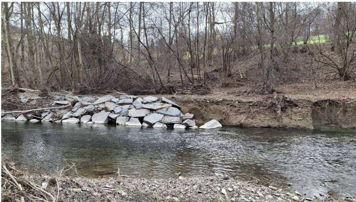
Obr. 7 Úsek 2, pravý břeh, rozebrané opevnění a nátrž směrem proti proudu [04].
