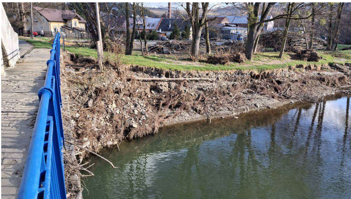
Obr. 23 Úsek 5, levý břeh, břehová nátrž, pohled z mostu směrem po proudu [04].
