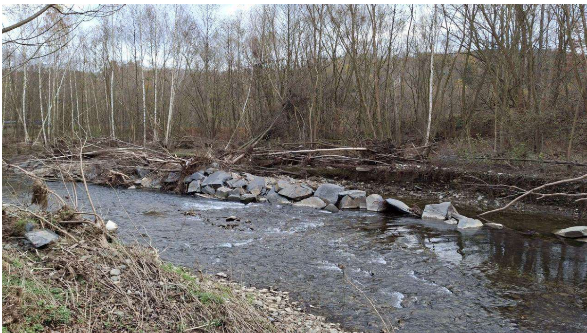
Obr. 6 Úsek 2, pravý břeh, rozebrané opevnění a nátrž [04].
