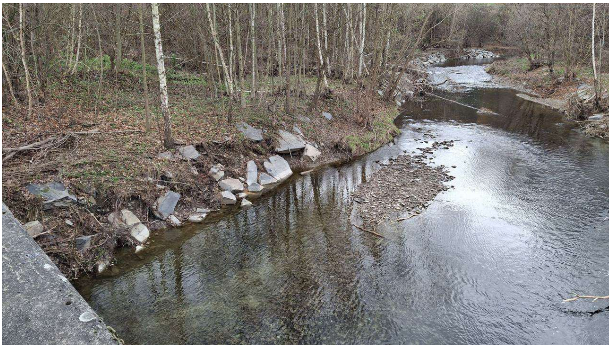
Obr. 5 Úsek 2, pravý břeh, pohled na rozebrané opevnění svahu, pohled z mostu [04].
