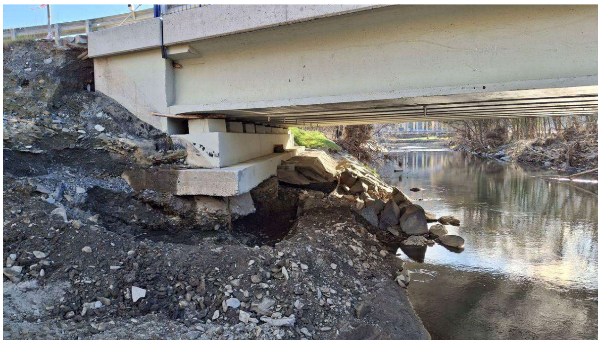
Obr. 32 Úsek 8, levý břeh, břehová nátrž a odhalené základy mostu, pohled směrem po proudu [04].
