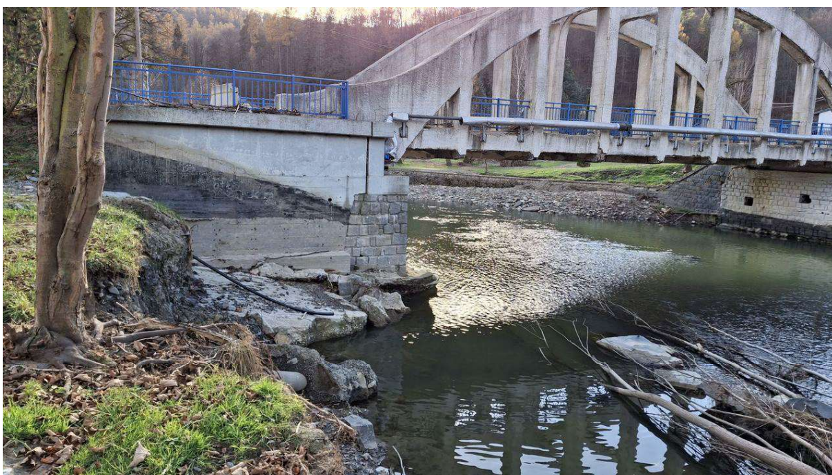
Obr. 28 Úsek 6, levý břeh, břehová nátrž a poškození opevnění pod mostem, pohled po proudu [04].
