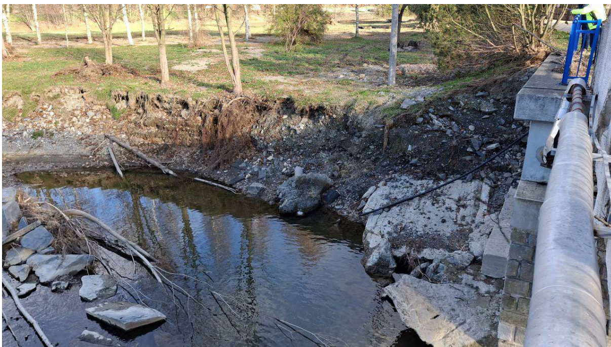
Obr. 27 Úsek 6, levý břeh, břehová nátrž a poškození opevnění pod mostem, pohled z mostu [04].
