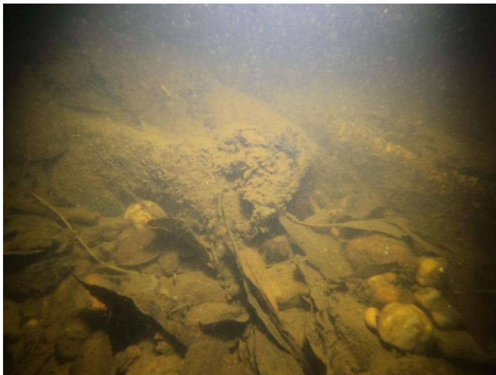
Foto: VD Brandýs n.L. – naplaveniny na hradícím prahu středního jez.pole
