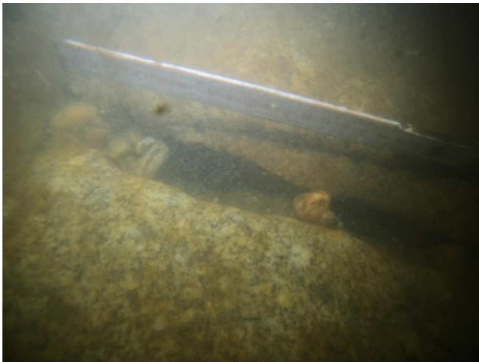
Foto: VD Brandýs n.L. – poškozené spárování ve dně vývaru č.1
