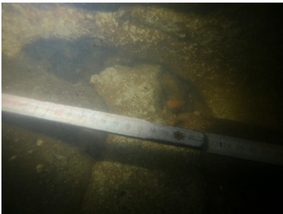
Foto: VD Brandýs n.L. – poškozené spárování ve dně vývaru č.14
