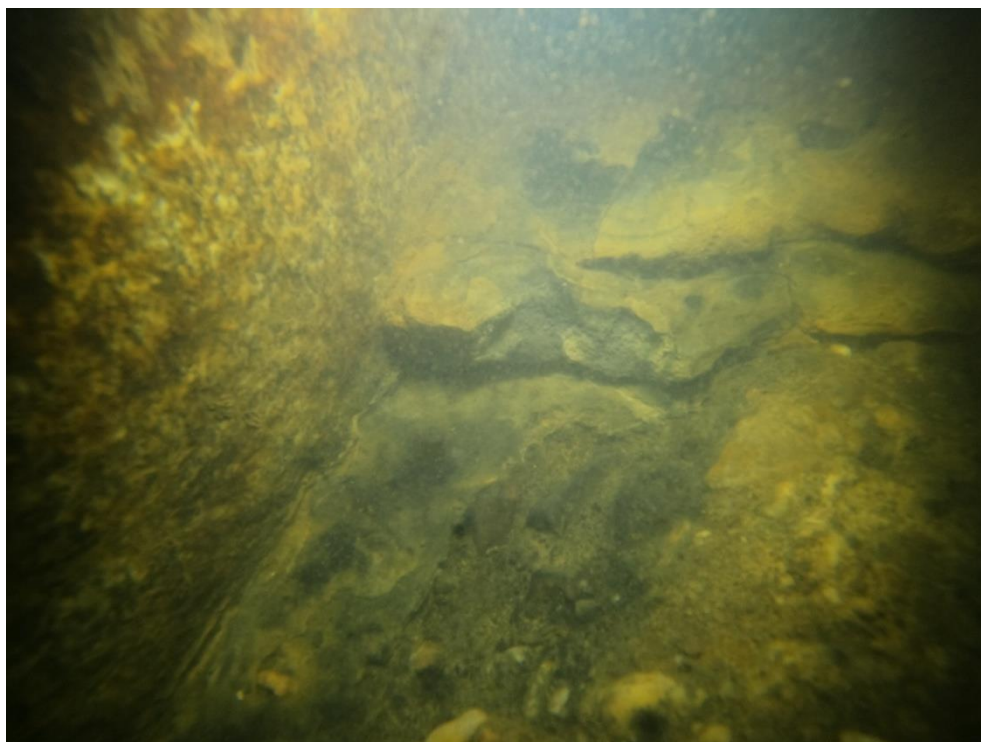
Foto: VD Brandýs n.L. – kaverna ve dně prahu č.11
