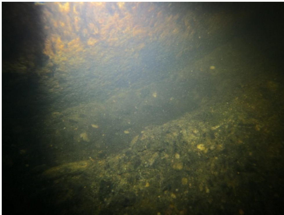
Foto: VD Brandýs n.L. – kaverna ve dně prahu č.5
