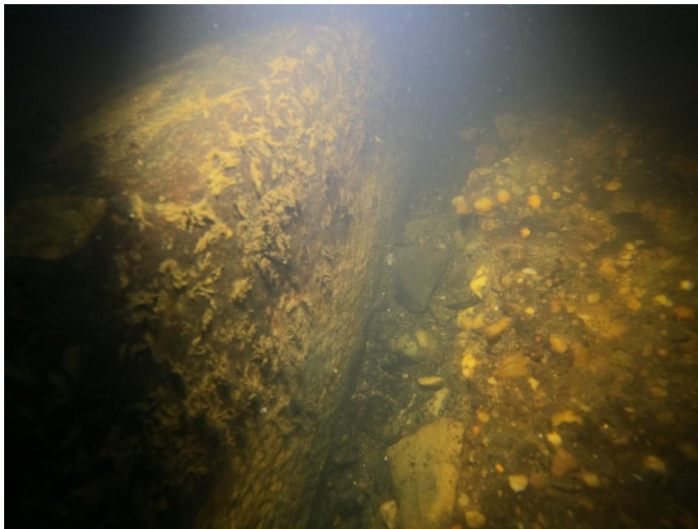
Foto: VD Brandýs n.L. – kaverna ve dně prahu č.7
