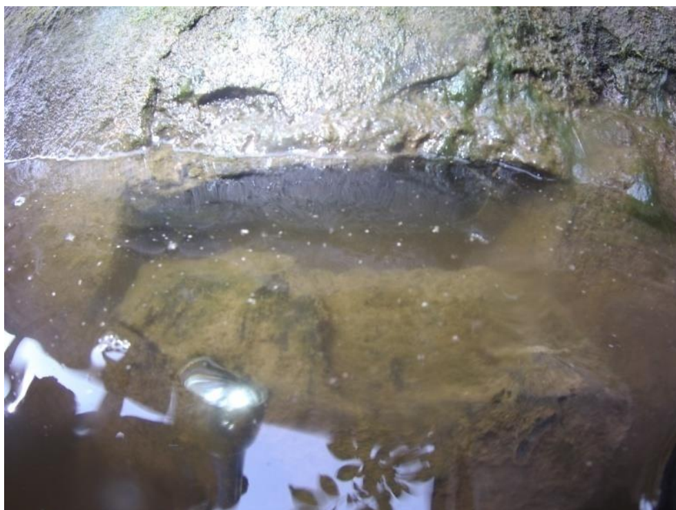
Obr. PS, a.s. MPK dolní ohlaví, vypadané kameny
