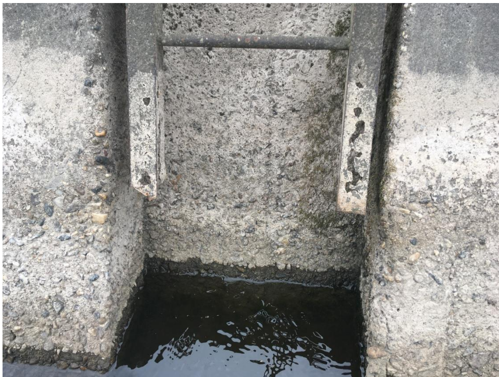
Obr. PS, a.s. poškozené sestupové žebříky na pilířích ze spodní vody
