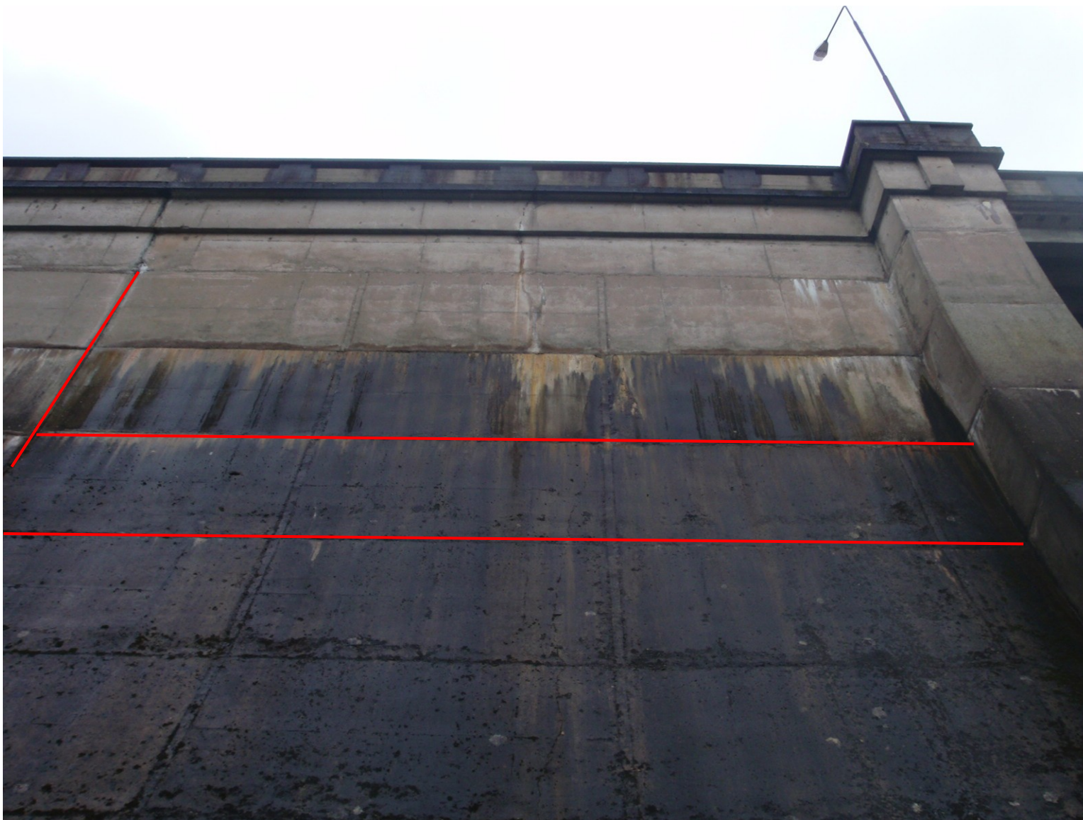
Foto ze vzdušné strany, viz průsaky a vápenné výluhy – průzkum bude proveden z návodní strany hráze
