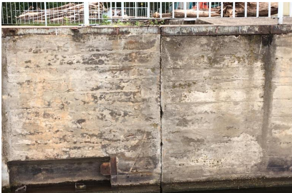
Obr. PS, a.s. svislá dilatační spára v levém nadjezí
