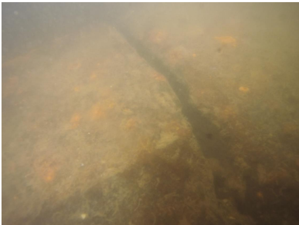
Obr. PS, a.s. poškozená dilatační spára na pravé straně pravého jezového pole
