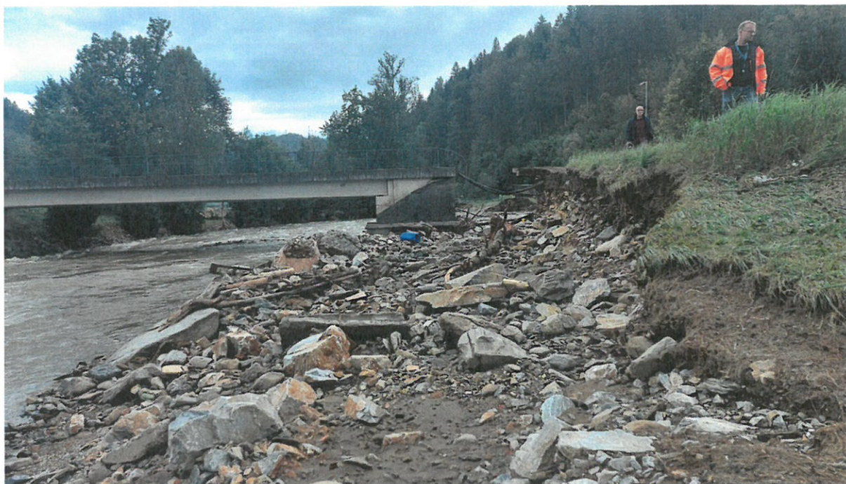
FOTO 4 – Hanušovice, poškození opevnění LB břehu
