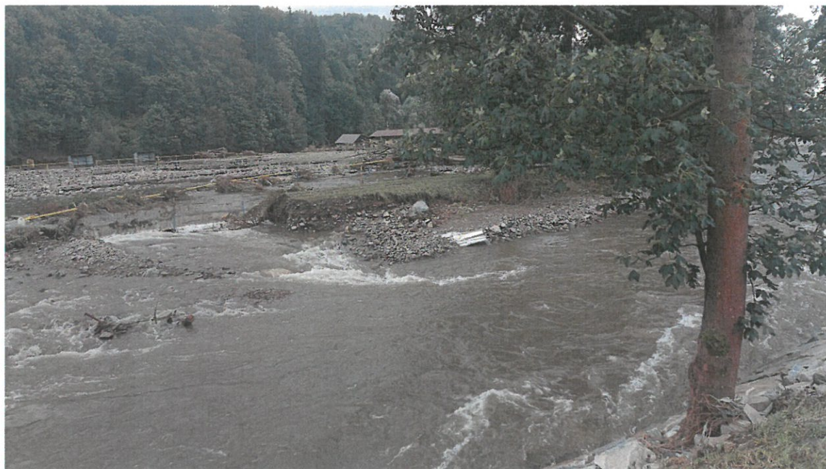
FOTO 1 - Hanušovice, poškozené opevnění nad fotbalovým hřištěm
