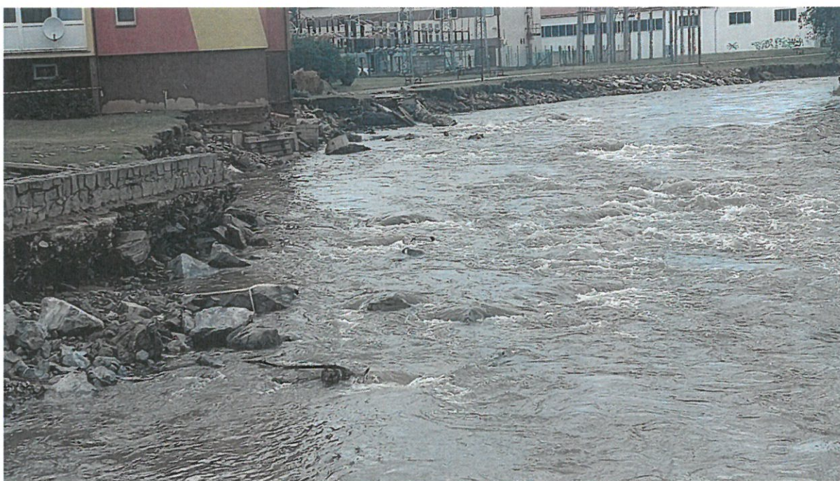
FOTO 3 – poškozená ochranná hráz, opevnění Hanušovice, sídliště
