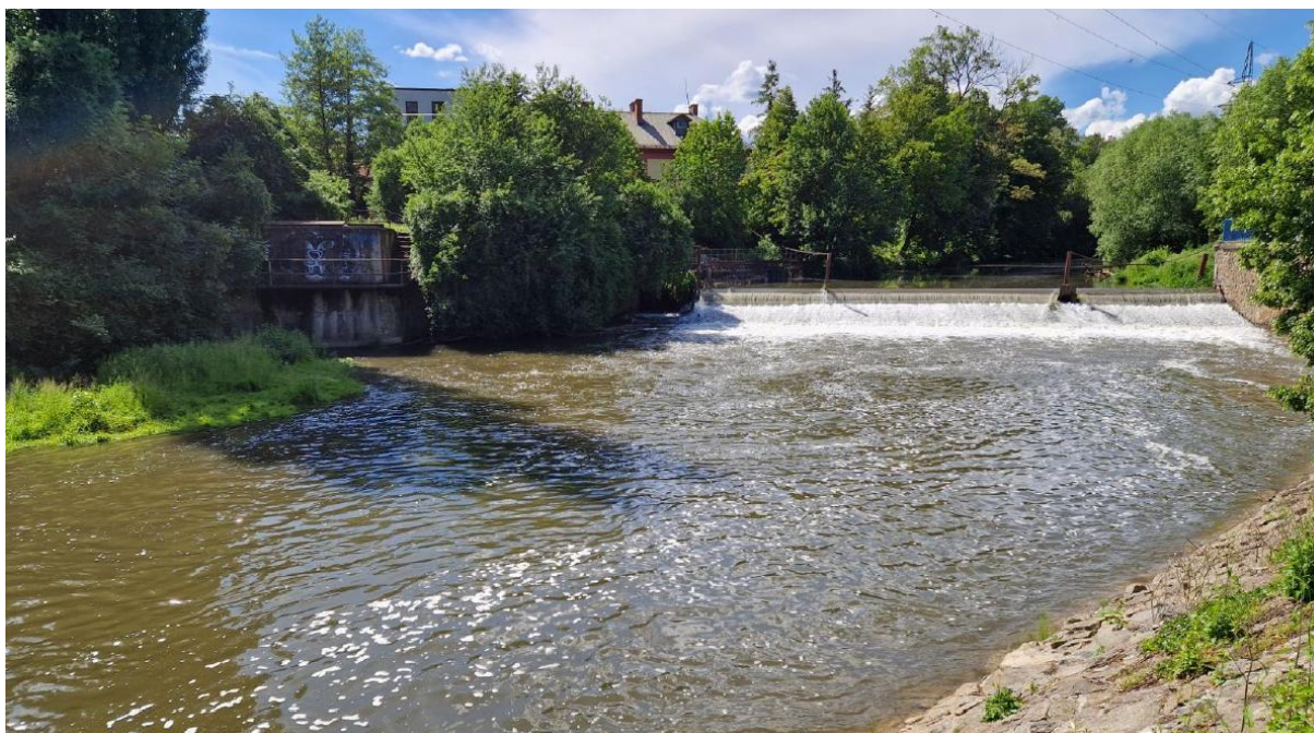
Obr. 1 - Stávající stav jezové konstrukce
