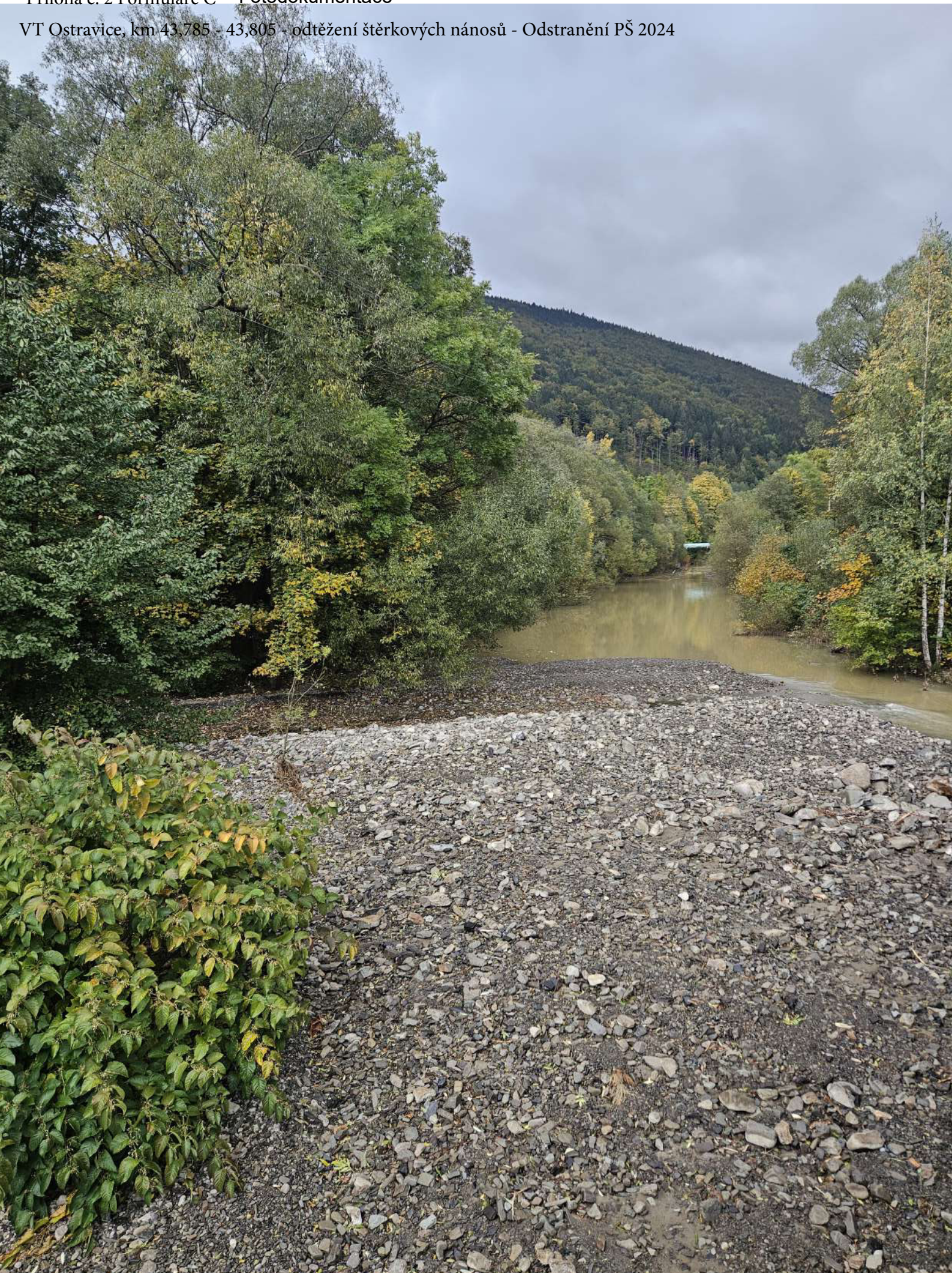
Štěrkové nánosy nad silničním mostem
