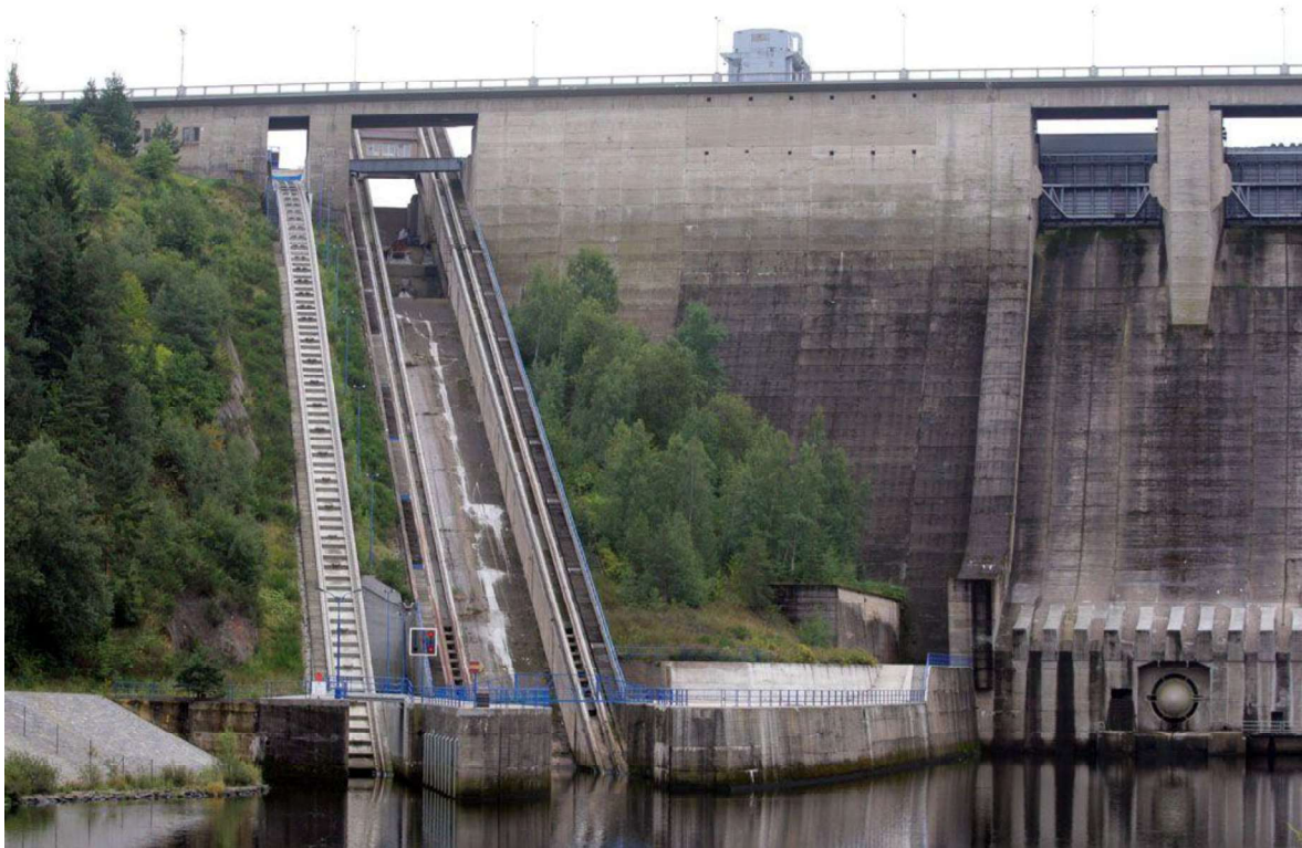
Detail dolní stanice
