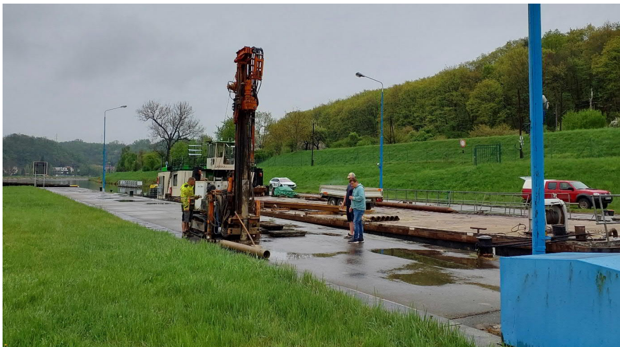
Foto 3 Hloubení sondy RJ-2
