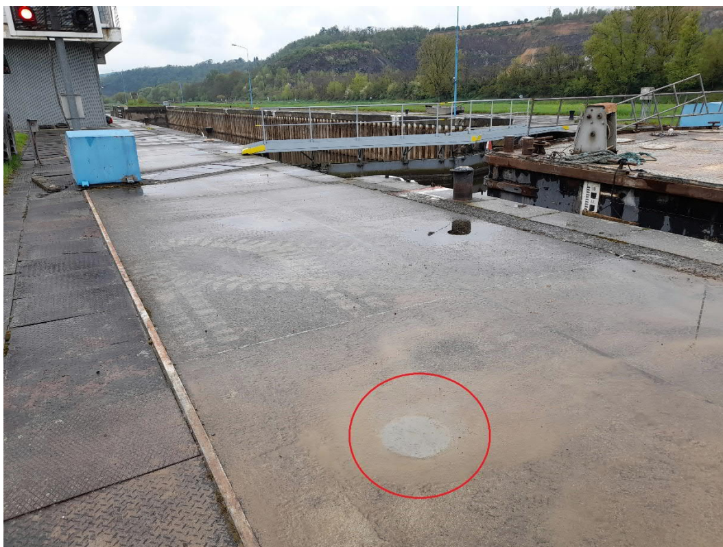
Foto 5 Zapravení vrtu RJ-1 betonovou směsí
