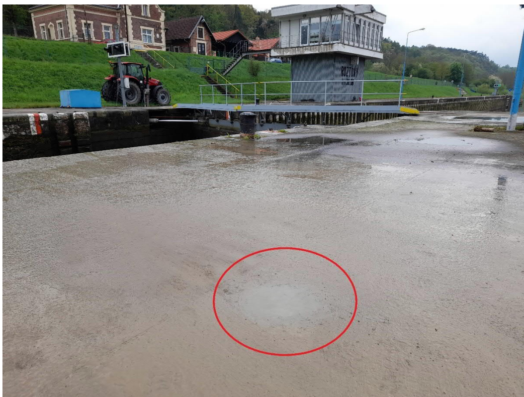
Foto 6 Zapravení vrtu RJ-2 betonovou směsí
