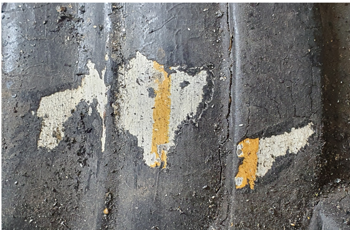
Obrázek 10- Detail původního barevného provedení nábojů kol
