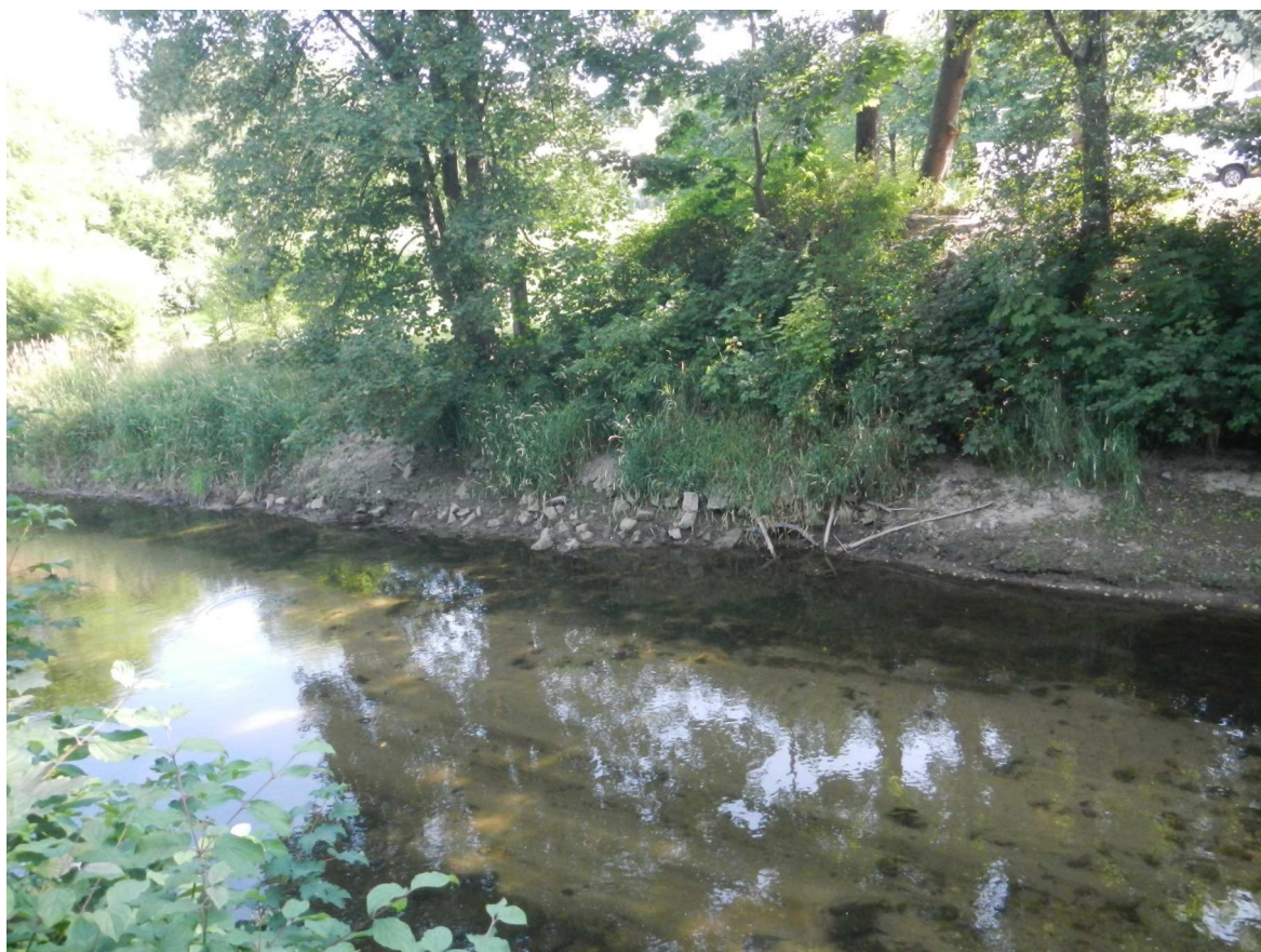
Nánosy, náletové dřeviny a poškozené opevnění levého břehu
