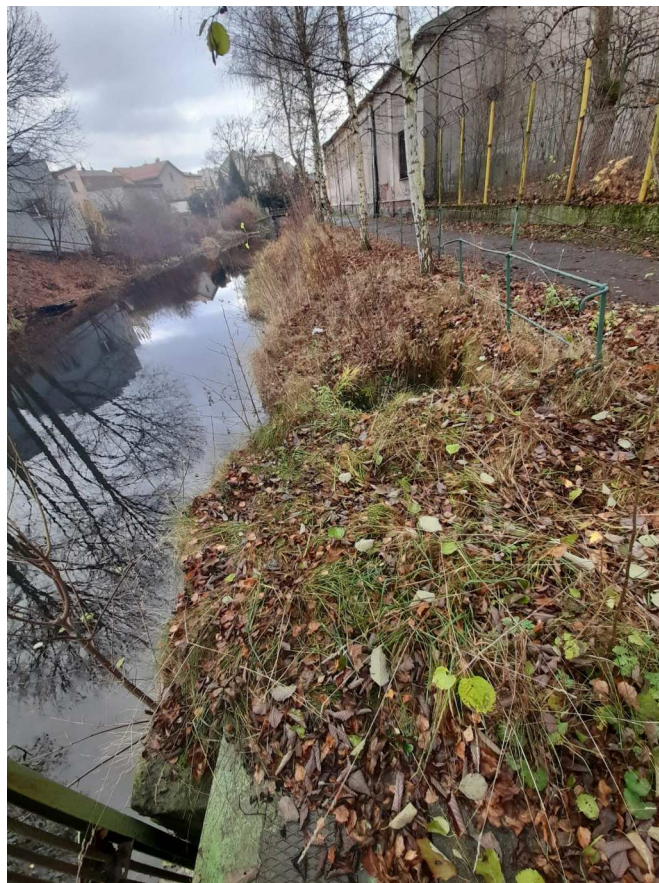
Nánosy na opevnění pravého břehu
