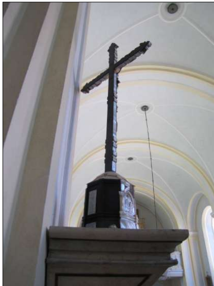
Inv. č. KO-55 – pohled na zadní stranu kříže, značné množství chybějících perleťových prvků (cca 55 ks), uvolněné perleťové části, absence dřevěných profilovaných lišt z ebenového dřeva stávající stav
