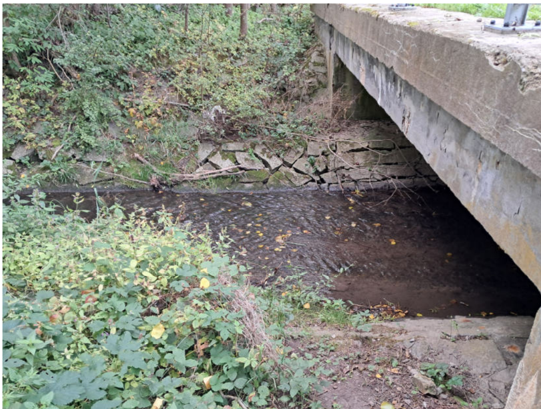
Obrázek 15: Most ke mlýnu Cerhov- ř. km 6,540
