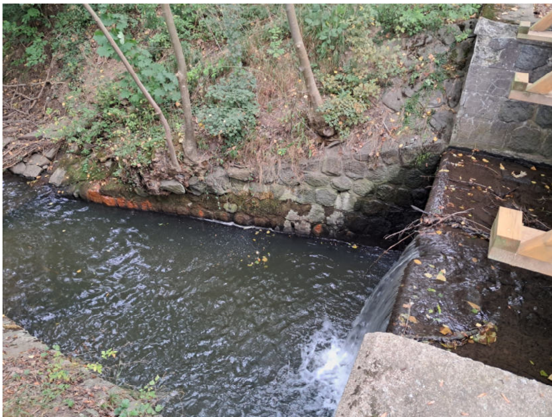
Obrázek 11: Betonový stupeň- ř. km 7,257
