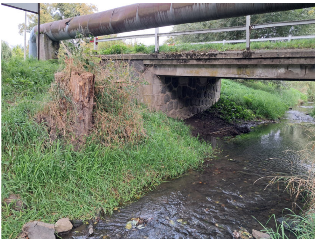
Obrázek 4: ř. km 7,775 - pohled po proudu (most Jezbořice ř. km 7,770)
