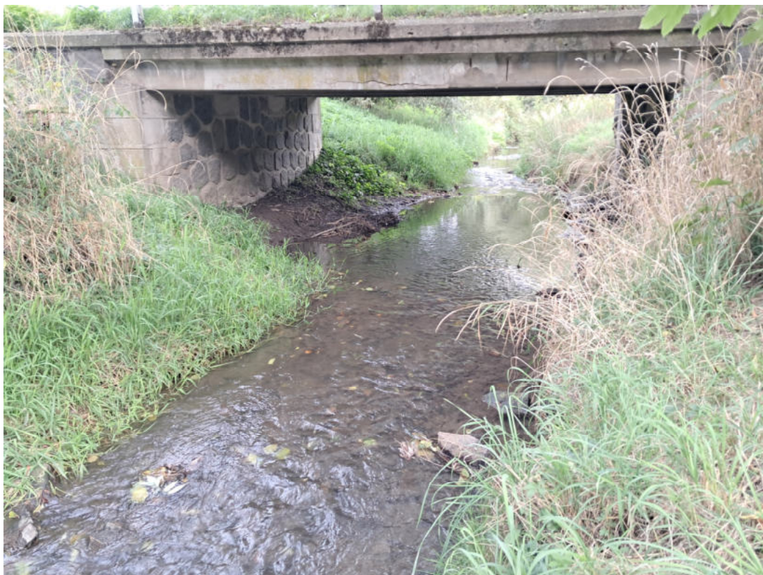
Obrázek 5: most Jezbořice ř. km 7,770
