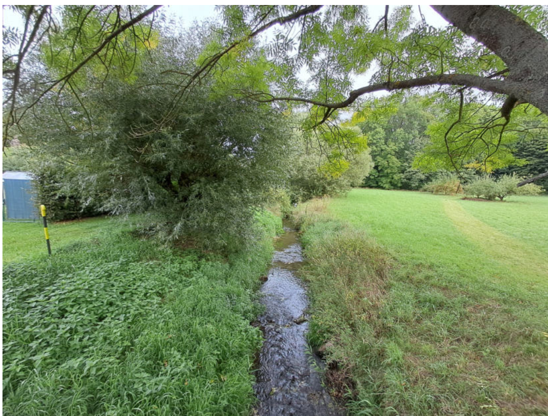
Obrázek 6: Pohled po proudu z mostu Jezbořice ř. km 7,770
