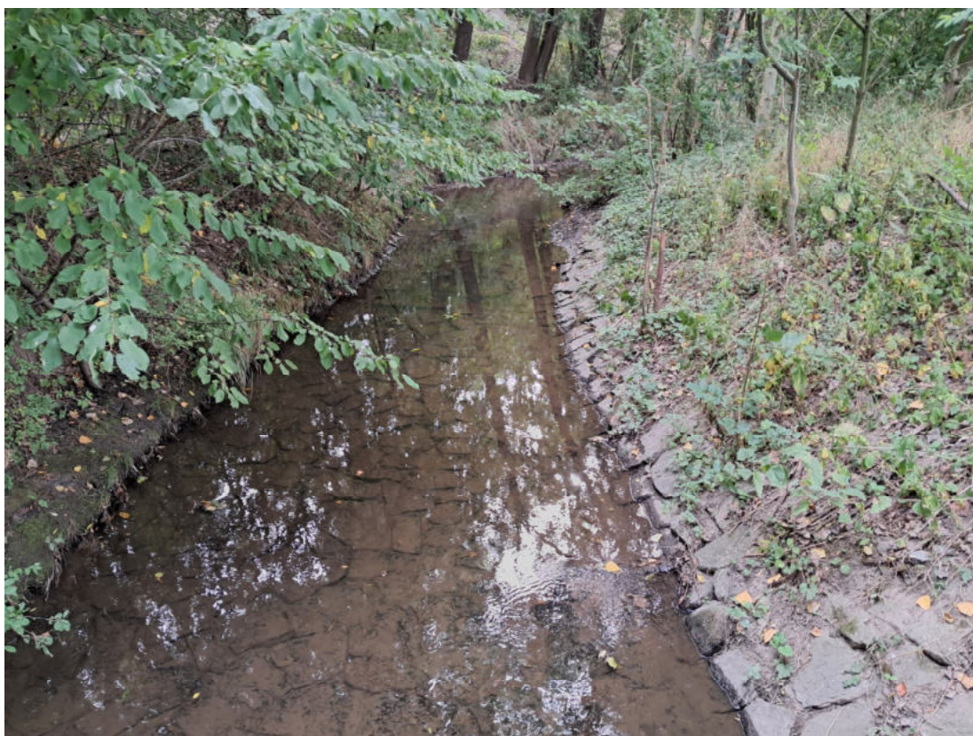
Obrázek 10: Pohled proti proudu ř. km 7,261
