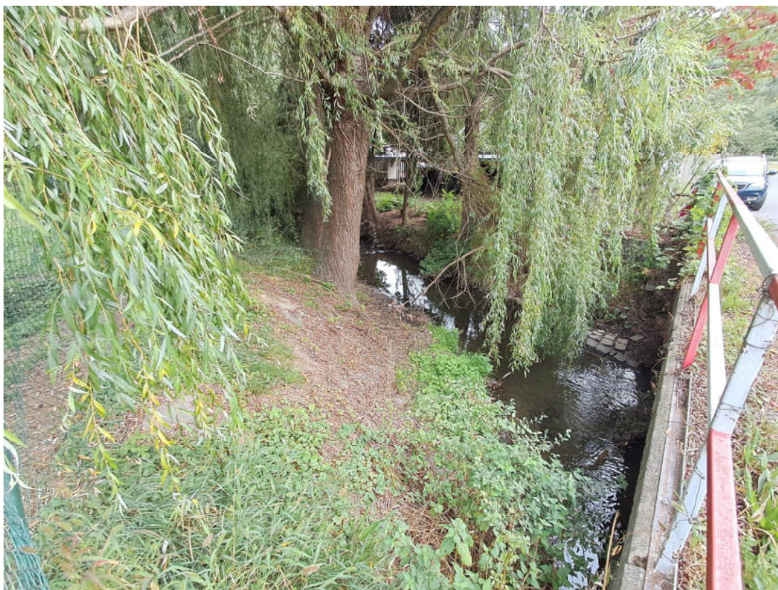
Obrázek 2: Most Jezbořice III - ř. km 7,860 - pohled po proudu
