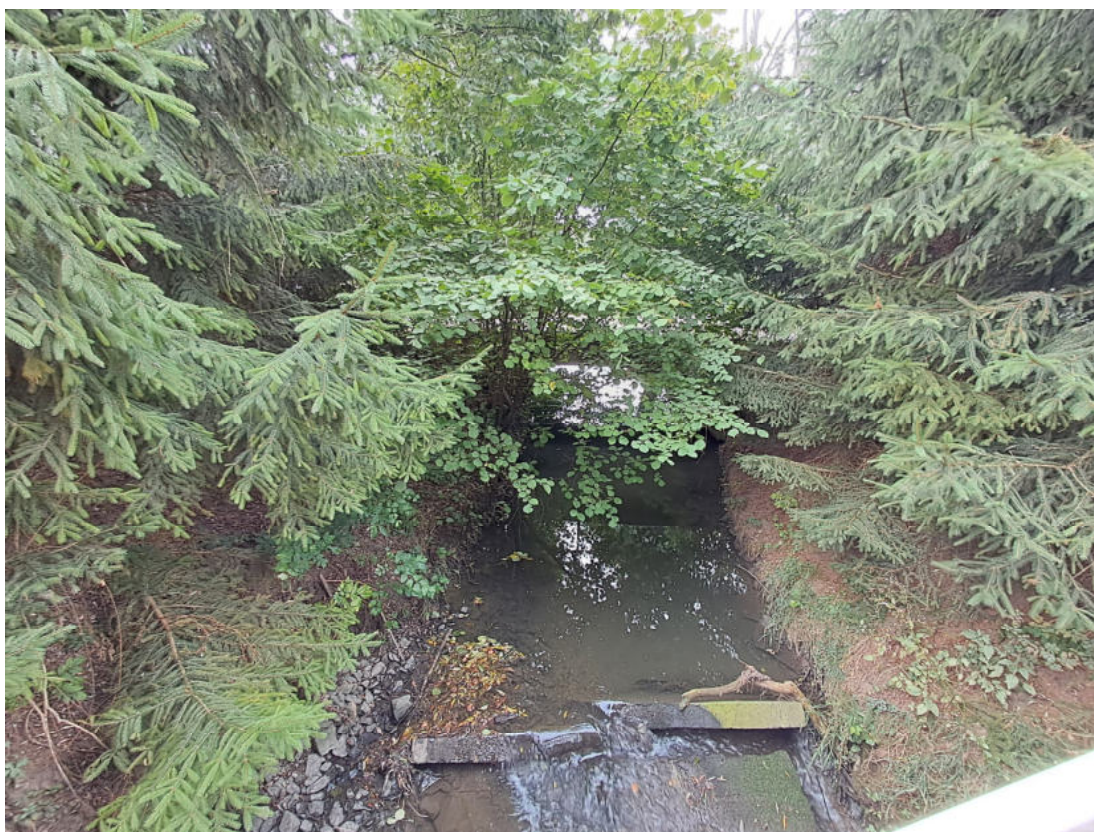
Obrázek 1: Most Jezbořice III - ř. km 7,860 - pohled proti proudu
