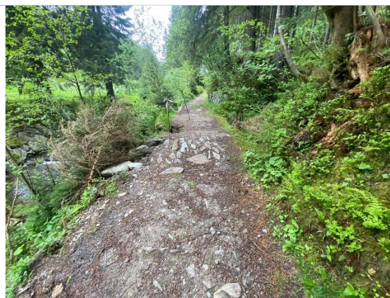
Obr. 27: Zborcený propustek mezi horní přehrážkou a soutokem Malá Úpa – Černá voda (10.6.2025)
