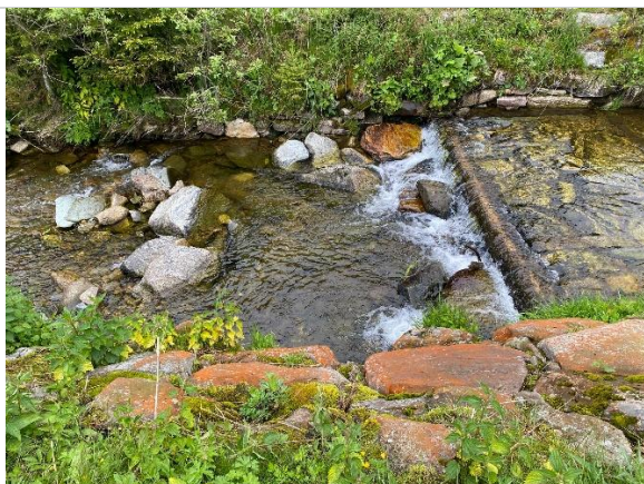
Obr. 24: Práh v ř. km 8,891 - výmol v dopadišti (10.6.2025)
