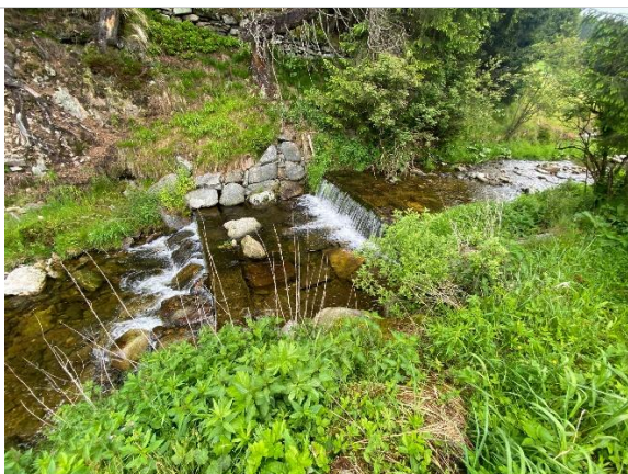
Obr. 22: Stupeň v ř. km 8,832 – výmol v dopadišti, za dopadištěm a v levobřežním opevnění (10.6.2025)
