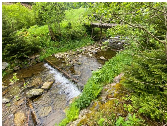
Obr. 19: Práh v ř. km 8,541 – výmol nad prahem v levobřežní části (10.6.2025)
