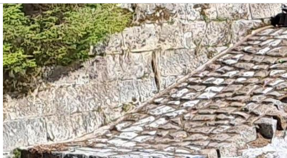
Obr. 29 Tvar přelivné plochy – „protáhlá sinusoida dle MŘ
