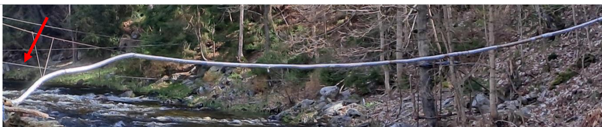
Obr. 24 Nadzemní vedení s nízkou podjezdovou výškou
