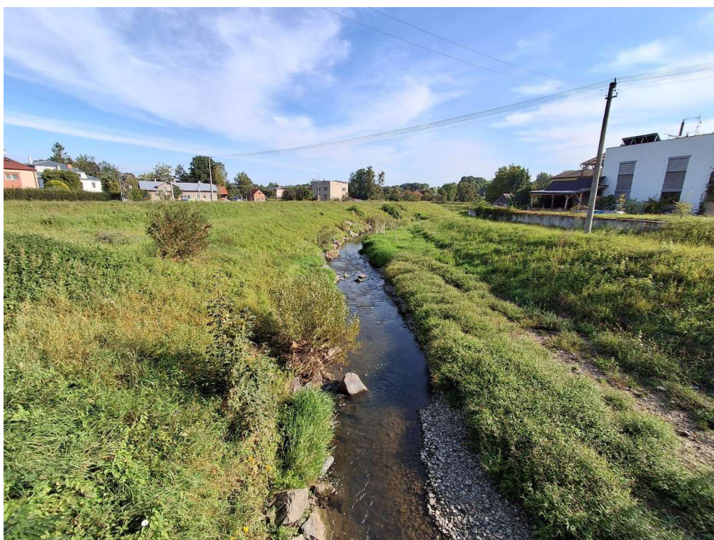
Obrázek č. 4 – štěrková lavice, ul. U Jezu, ř. km 6,150
