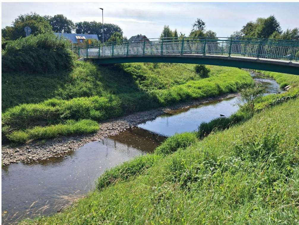
Obrázek č. 3 – štěrková lavice, ul. Ve Vrbí, ř. km 5,500
