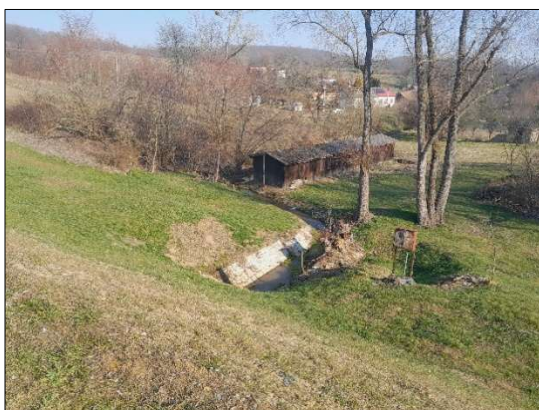
Pohled z čelní hráze nádrže do podhrází
