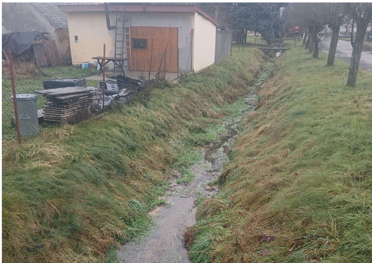
Mutenský p., ř. km 0,164 – 0,493, Mutná, oprava koryta
