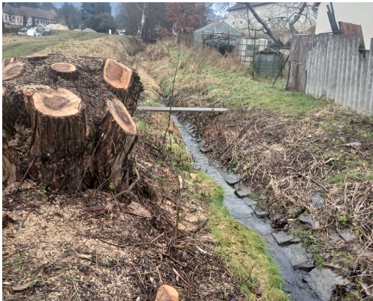
Mutenský p., ř. km 0,164 – 0,493, Mutná, oprava koryta
