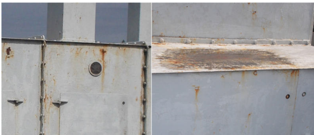
Detaily stavu zakrytí.
