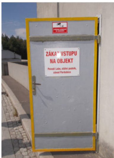
Stávající vstupní dveře
