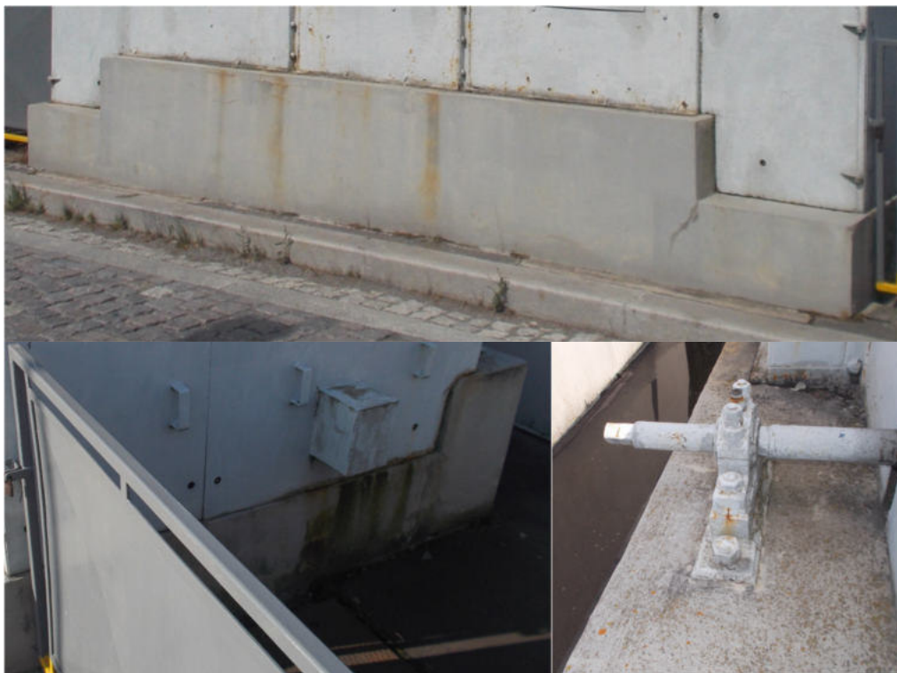
Betonový sokl zdvihadel
