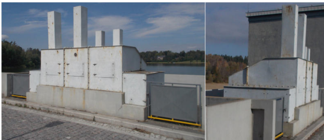
Konstrukce zakrytí strojoven
