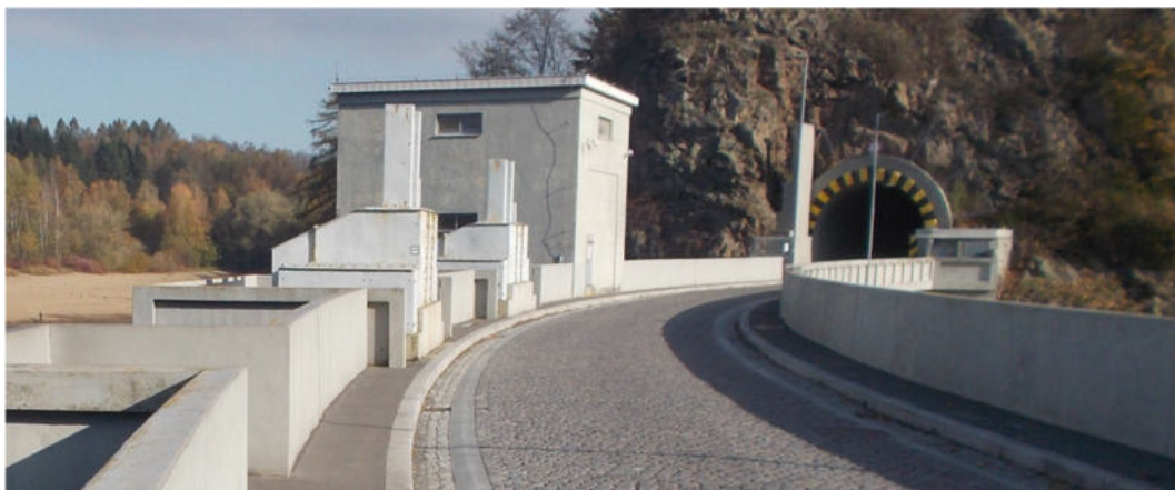
Koruna hráze VD Seč se strojovny SV i MVE
