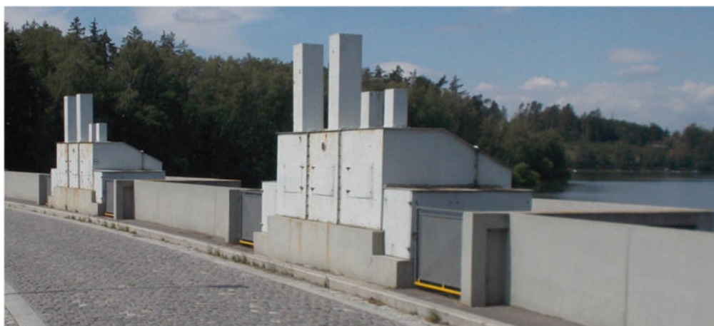
Konstrukce strojoven ve výklenku na koruně hráze
