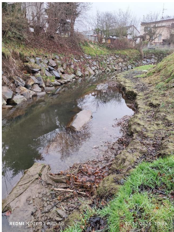
obrázek č. 1 – Výtrž na pravém a levém břehu VT Porubka, k.ú. Svinov
