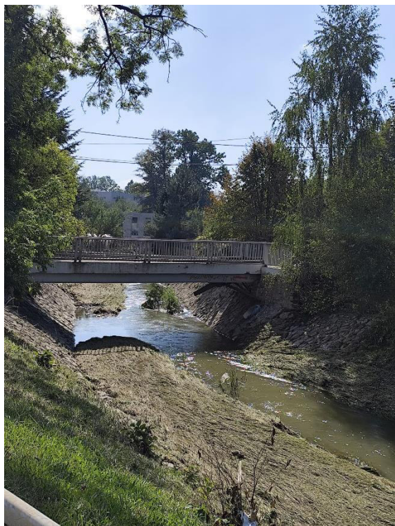
obrázek č. 2 – nánosy sedimentu a výtrž na manipulačním páse VT Porubka, k.ú. Svinov
