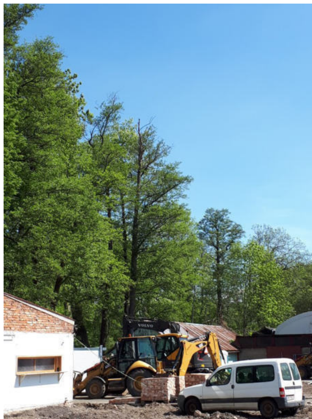
Prosychající olše v dopadové vzdálenosti rekonstruovaného areálu školy
