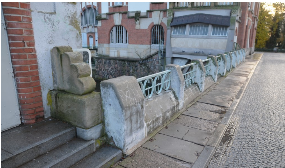
Obr.G86-35 Pravostranné mostní zábradlí druhého pole. Pohled zleva doprava (proti vodě) a proti směru staničení,
