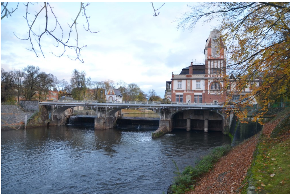
Obr.G86-03 Levá (povodní) strana mostu. Pohled z levého břehu řeky. Pohled ve směru staničení a zleva doprava (proti vodě),
