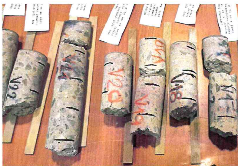
Obr. 4: Pohled na jádrové vývrtky V17 až V22. Vývrtky byly odebrány ze zábradelních sloupků. Beton je kompaktní, rozložení kameniva je rovnoměrné.
