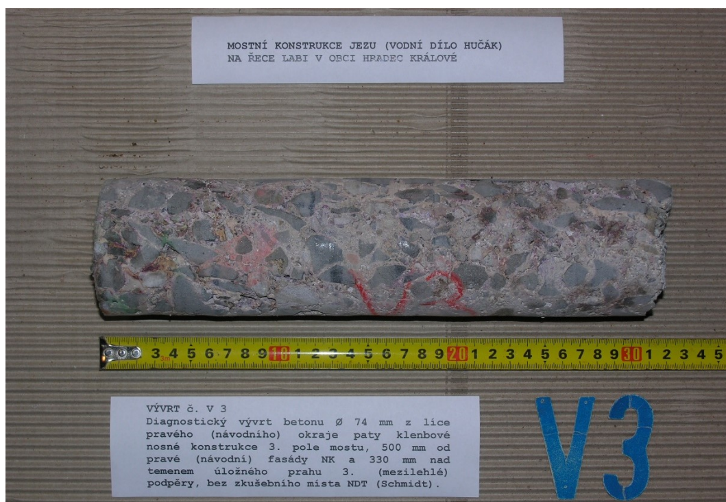
Obr. G86-103 VÝVRT č. V3. Diagnostický vývrt betonu Ø 74 mm z líce pravého (návodního) okraje paty klenbové nosné konstrukce 3. pole mostu, 500 mm od pravé (návodní) fasády NK a 330 mm nad temenem úložného prahu 3. (mezilehlé) podpěry, bez zkušebního místa NDT (Schmidt).
