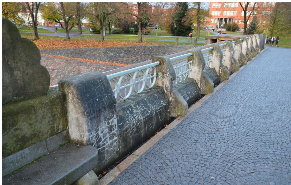
Obr.G86-29 Levostranné mostní zábradlí třetího pole. Pohled zprava doleva (po vodě) a ve směru staničení,
