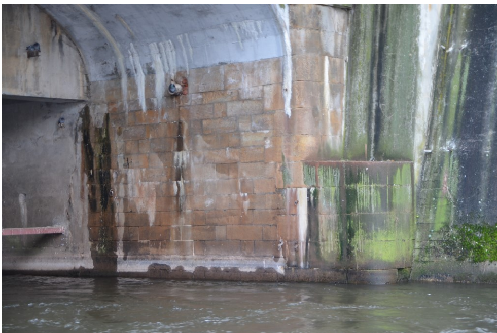
Obr.G86-05 První (koncová) podpěra, levobřežní opěra. Pohled na její líc a levé čelo, zleva doprava (proti vodě) a proti směru staničení,
