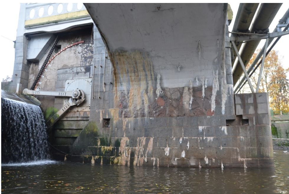
Obr.G86-10 Třetí (mezilehlá) podpěra. Pohled na její zadní líc. Pohled zleva doprava (proti vodě) a proti směru staničení,
