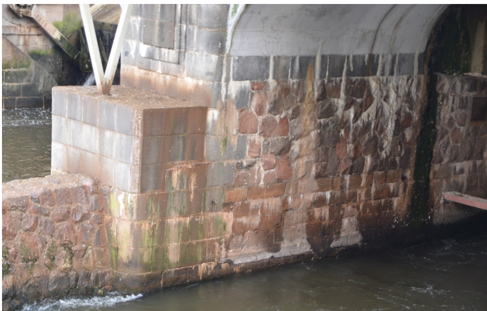
Obr.G86-07 Druhá (mezilehlá) podpěra. Pohled na její přední líc a levé čelo. Pohled ve směru staničení a zleva doprava (proti vodě),
