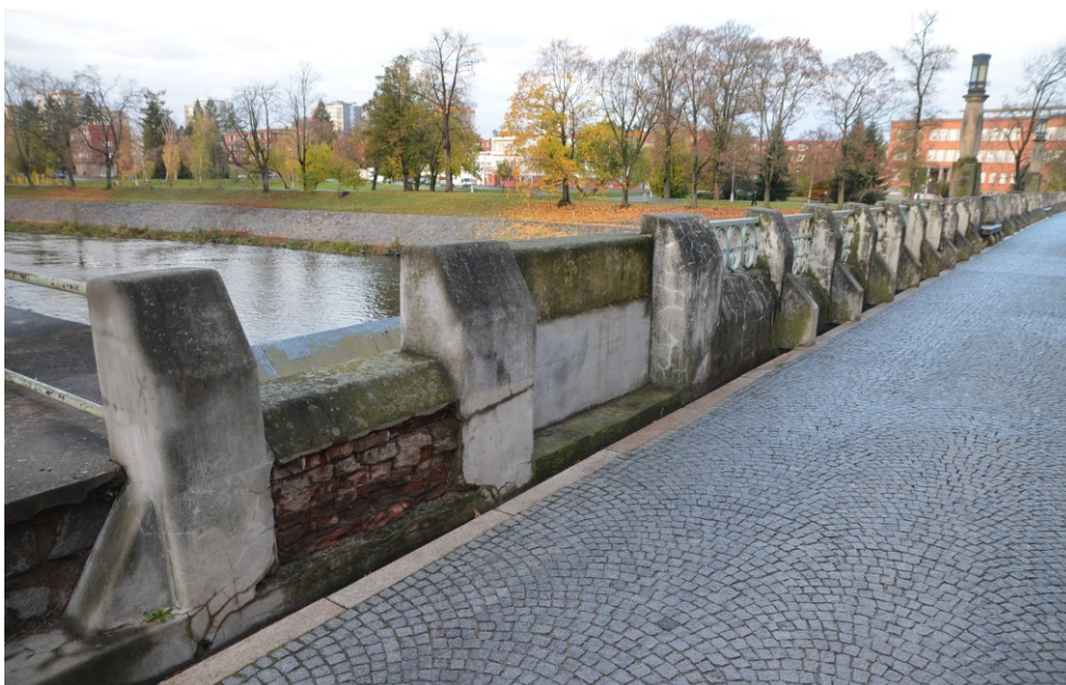
Obr.G86-25 Levostranné mostní zábradlí prvního pole. Pohled zprava doleva (po vodě) a ve směru staničení,
