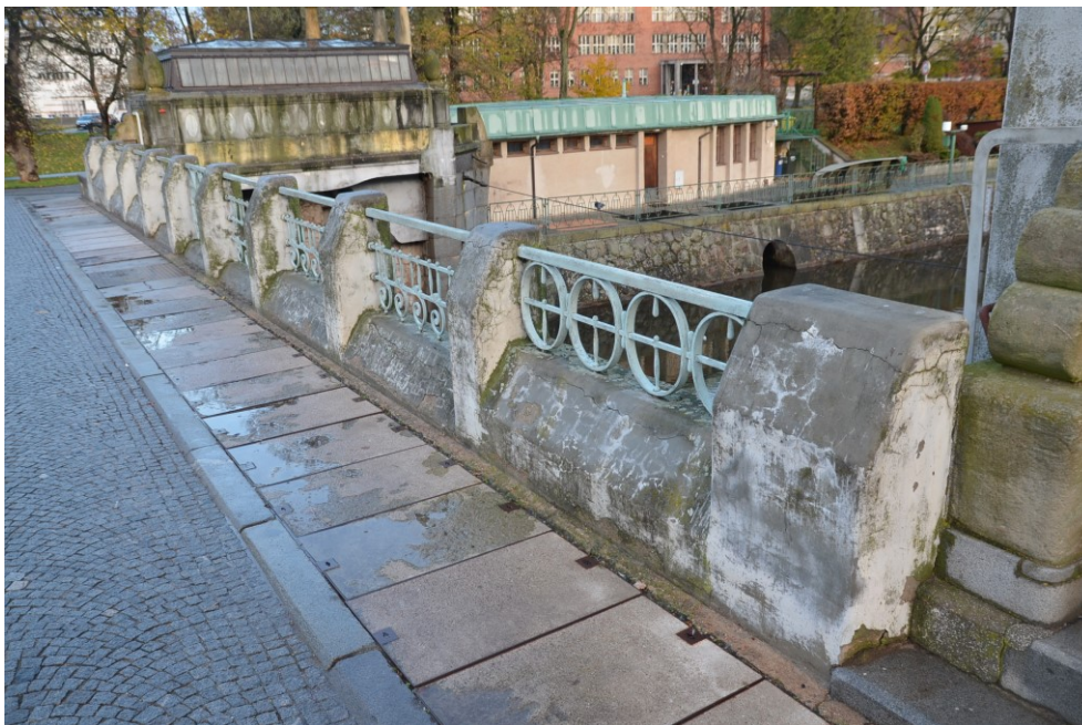
Obr.G86-37 Pravostranné mostní zábradlí třetího pole. Pohled ve směru staničení a zleva doprava (proti vodě),
