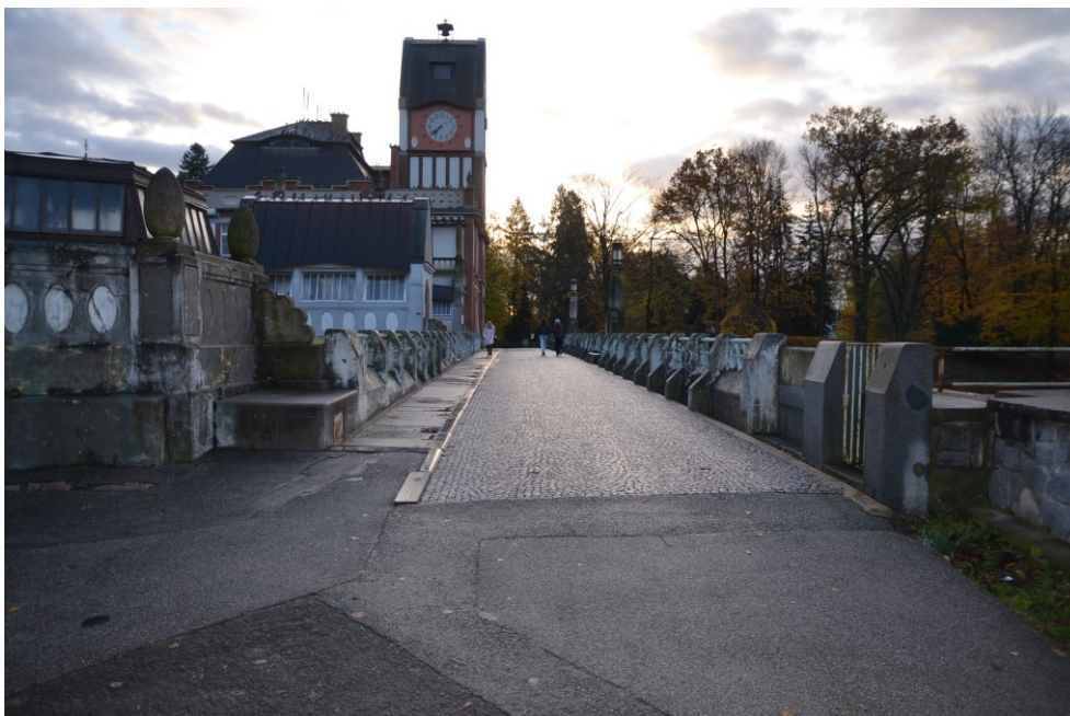
Obr.G86-02 Průhled osou mostu proti směru staničení. Pohled z pravého břehu řeky (od ulice Tylovo nábřeží) k levému břehu řeky (k ulice Křižíkova),
