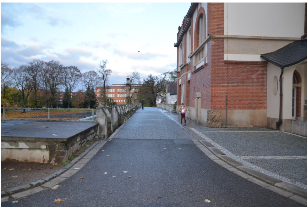
Obr.G86-01 Průhled osou mostu ve směru staničení. Pohled z levého břehu řeky (od ulice Křižíkovy) k pravému břehu řeky (ulici Tylovo nábřeží),
