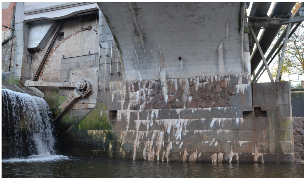
Obr.G86-08 Druhá (mezilehlá) podpěra. Pohled na její zadní líc. Pohled zleva doprava (proti vodě) a proti směru staničení,
