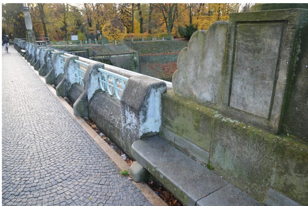
Obr.G86-28 Levostranné mostní zábradlí druhého pole. Pohled proti směru staničení a zprava doleva (po vodě),
