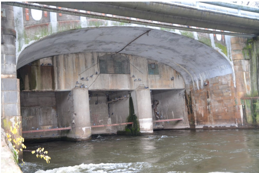
Obr.G86-12 Podhled nosné konstrukce prvního pole mostu. Pohled zleva doprava (proti vodě) a proti směru staničení,
