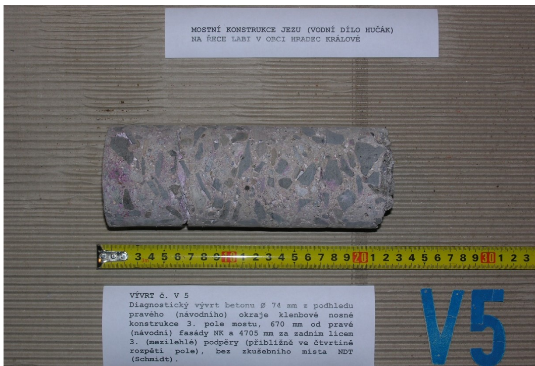
Obr. G86-105 VÝVRT č. V5. Diagnostický vývrt betonu Ø 74 mm z podhledu pravého (návodního) okraje klenbové nosné konstrukce 3. pole mostu, 670 mm od pravé (návodní) fasády NK a 4705 mm za zadním lícem 3. (mezilehlé) podpěry (přibližně ve čtvrtině rozpětí pole), bez zkušebního místa NDT (Schmidt).
