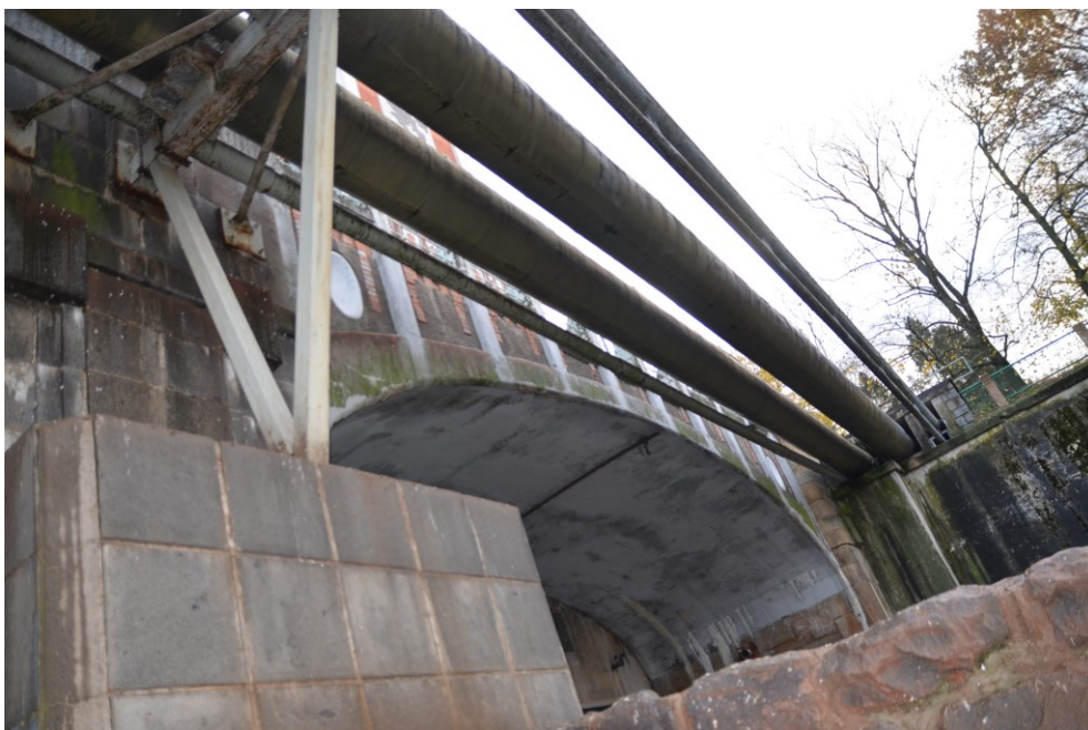
Obr.G86-11 Levá fasáda a část podhledu nosné konstrukce prvního pole. Pohled zleva doprava (proti vodě), proti směru staničení a vzhůru,
