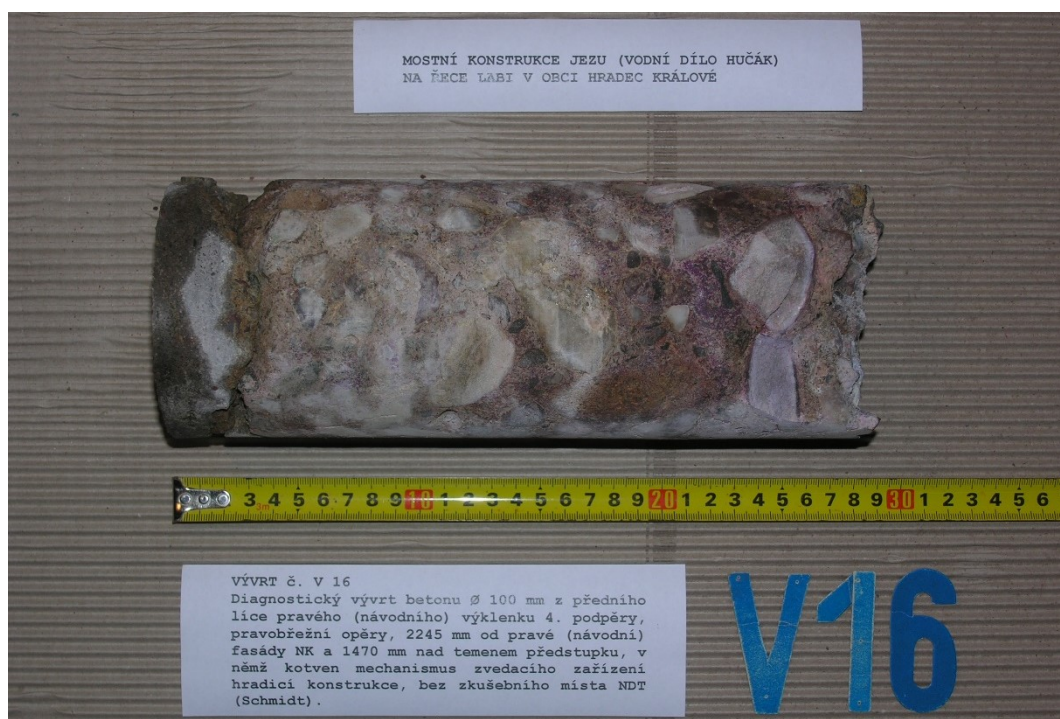
Obr. G86-116 VÝVRT č. V16. Diagnostický vývrt betonu Ø 100 mm z předního líce pravého (návodního) výklenku 4. podpěry, pravobřežní opěry, 2245 mm od pravé (návodní) fasády NK a 1470 mm nad temenem předstupku, v němž kotven mechanismus ovládacího zařízení hradicí konstrukce, bez zkušební místa NDT (Schmidt).
