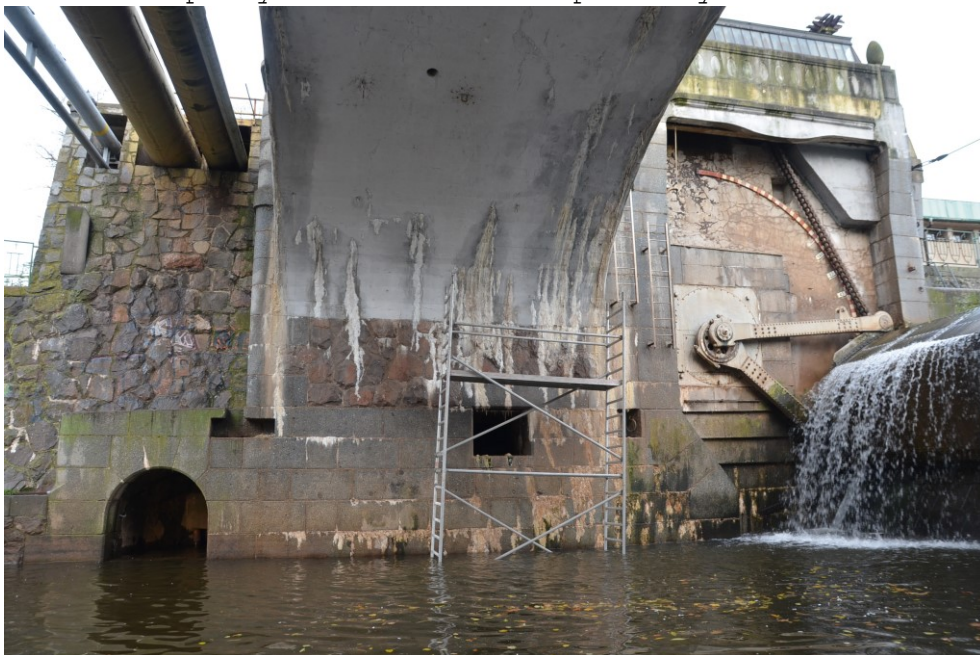
Obr.G86-06 Čtvrtá (koncová) podpěra, pravobřežní opěra. Pohled na její líc, přibližně ve směru staničení,
