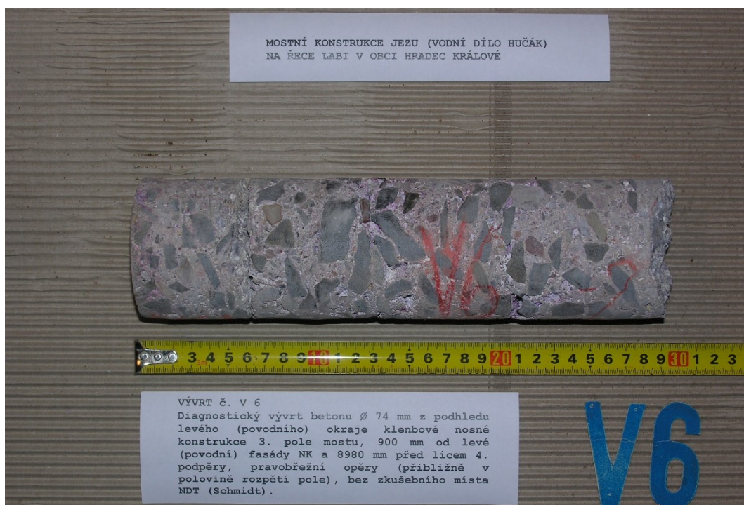
Obr. G86-106 VÝVRT č. V6. Diagnostický vývrt betonu Ø 74 mm z podhledu levého (povodního) okraje klenbové nosné konstrukce 3. pole mostu, 900 mm od levé (povodní) fasády NK a 8980 mm před lícem 4. podpěry, pravobřežní opěry (přibližně v polovině rozpětí pole), bez zkušebního místa NDT (Schmidt).
