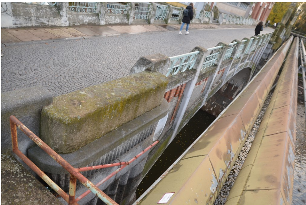
Obr.G86-20 Levá fasáda nosné konstrukce a ZBZ třetího pole. Pohled zleva doprava (proti vodě), proti směru staničení a dolů,
