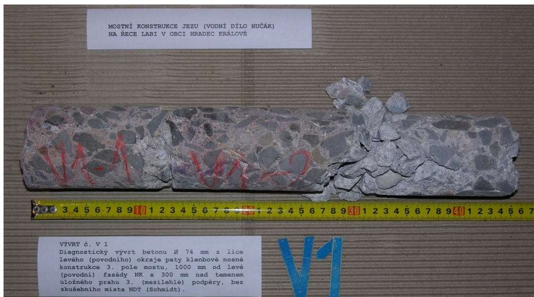
Obr. G86-101 VÝVRT č. V1. Diagnostický vývrt betonu Ø 74 mm z líce levého (povodního) okraje paty klenbové nosné konstrukce 3. pole mostu, 1000 mm od levé (povodní) fasády NK a 300 mm nad temenem úložného prahu 3. (mezilehlé) podpěry, bez zkušebního místa NDT (Schmidt).
