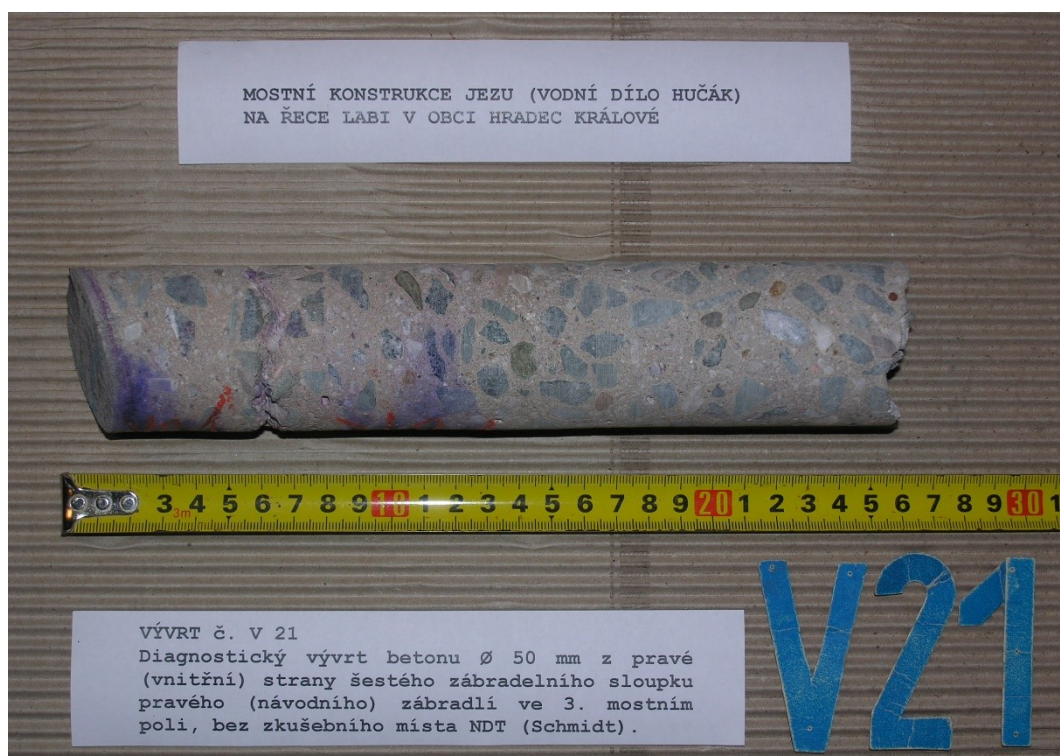
Obr. G86-121 VÝVRT č. V21. Diagnostický vývrt betonu Ø 50 mm z pravé (vnitřní) strany šestého zábradelního sloupku levého (návodního) zábradlí ve 3. mostním poli, bez zkušebního místa NDT (Schmidt).
