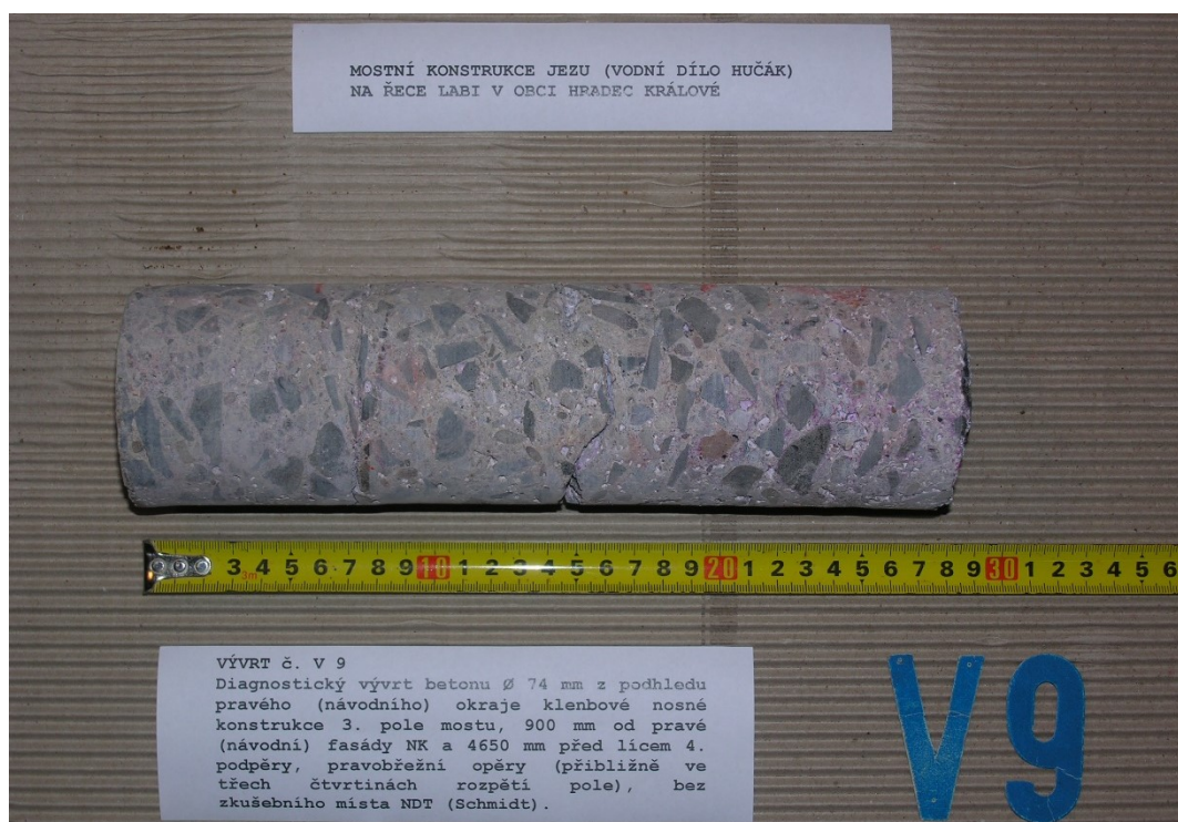
Obr. G86-109 VÝVRT č. V9. Diagnostický vývrt betonu Ø 74 mm z podhledu pravého (návodního) okraje klenbové nosné konstrukce 3. pole mostu, 900 mm od pravé (návodní) fasády NK a 4650 mm před lícem 4. podpěry, pravobřežní opěry (přibližně ve třech čtvrtinách rozpětí pole), bez zkušebního místa NDT (Schmidt).
