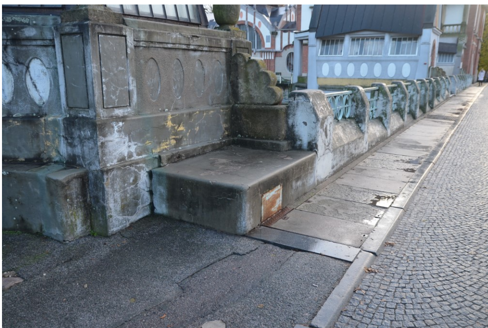
Obr.G86-38 Pravostranné mostní zábradlí třetího pole. Pohled zleva doprava (proti vodě) a proti směru staničení,
