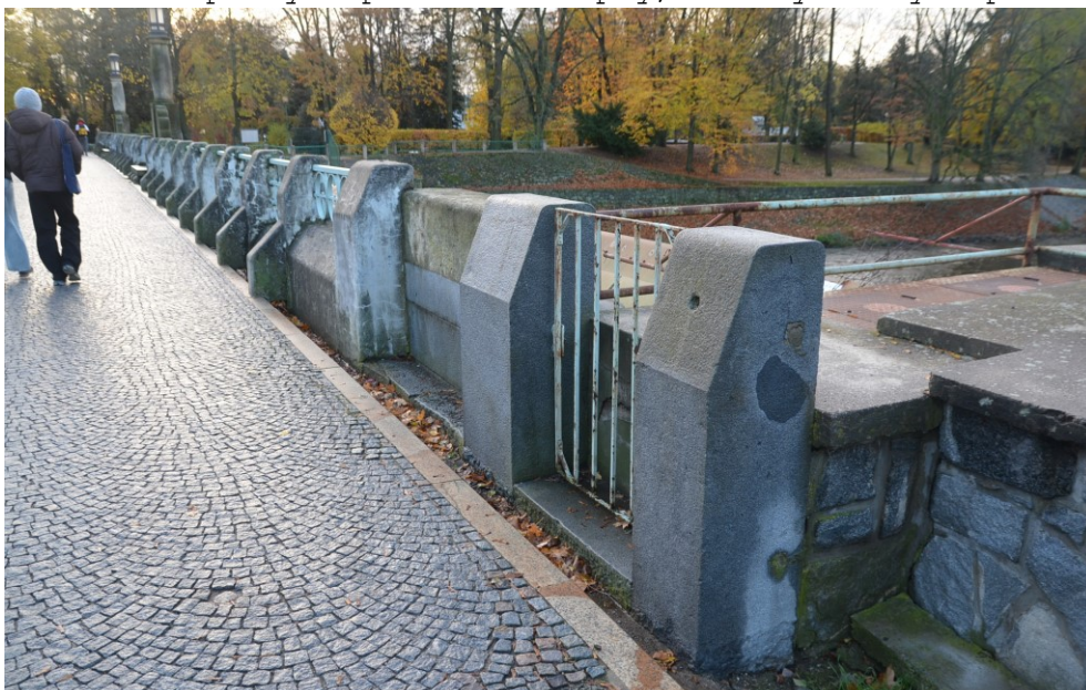
Obr.G86-30 Levostranné mostní zábradlí třetího pole. Pohled proti směru staničení a zprava doleva (po vodě),
