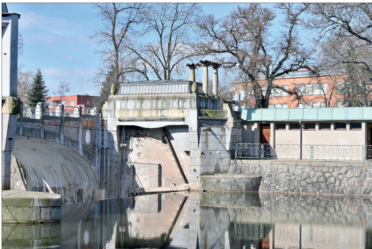
90. Celkový pohled na SZ průčelí od SZ
