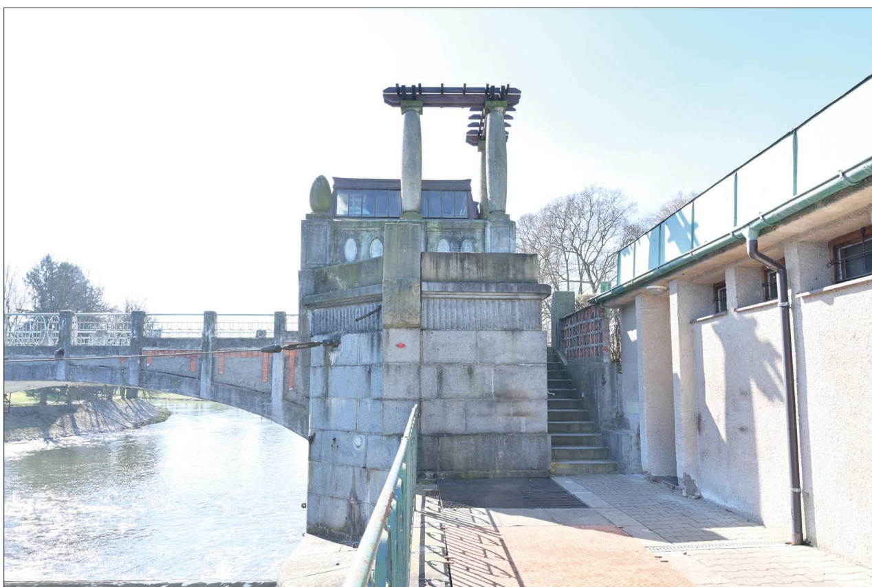
91. Pohled na navazující úsek hradby s předezděným lícem
