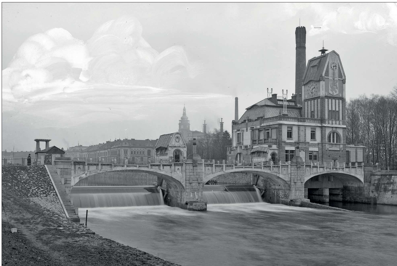
60. Fotografie mostu, jezu a hydroelektrárny z jihozápadní strany; 1914, Hradec Králové, Povodí Labe Hradec Králové, spisovna.
