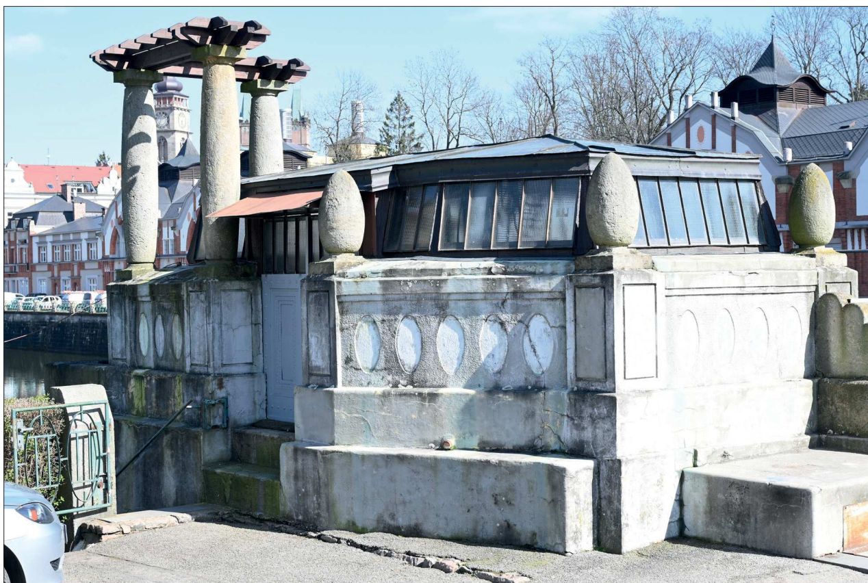
95. Detail paty záklenku a zadržkou zakrytou omítkou hlubšího výklenku při západním nároží SZ průčelí
