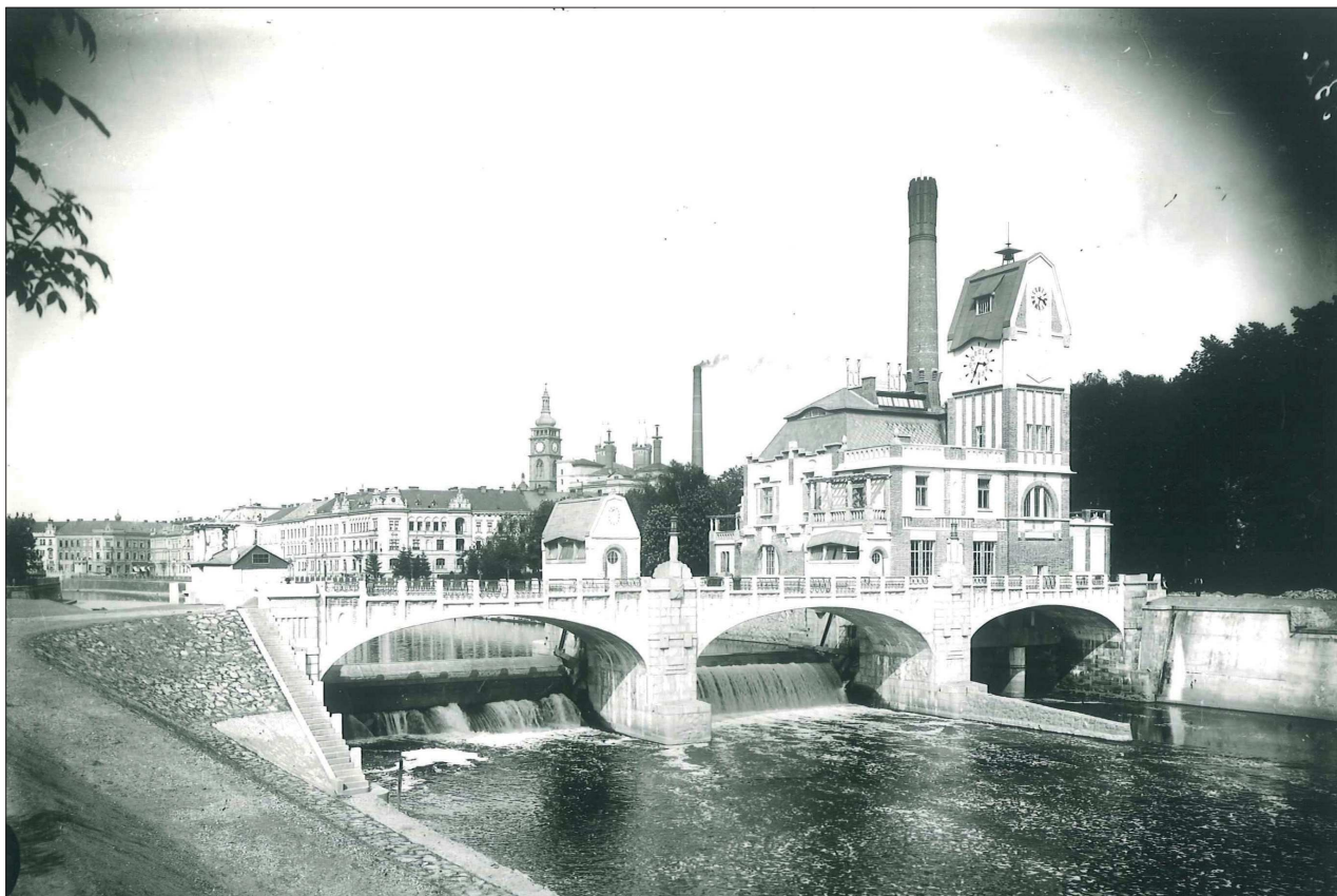
47. Fotografie dokončeného mostu, jezu a hydroelektrárny na Labi, cca 1913; SOKA Hradec Králové, sbírka fotografií, sign. I-79/v.
