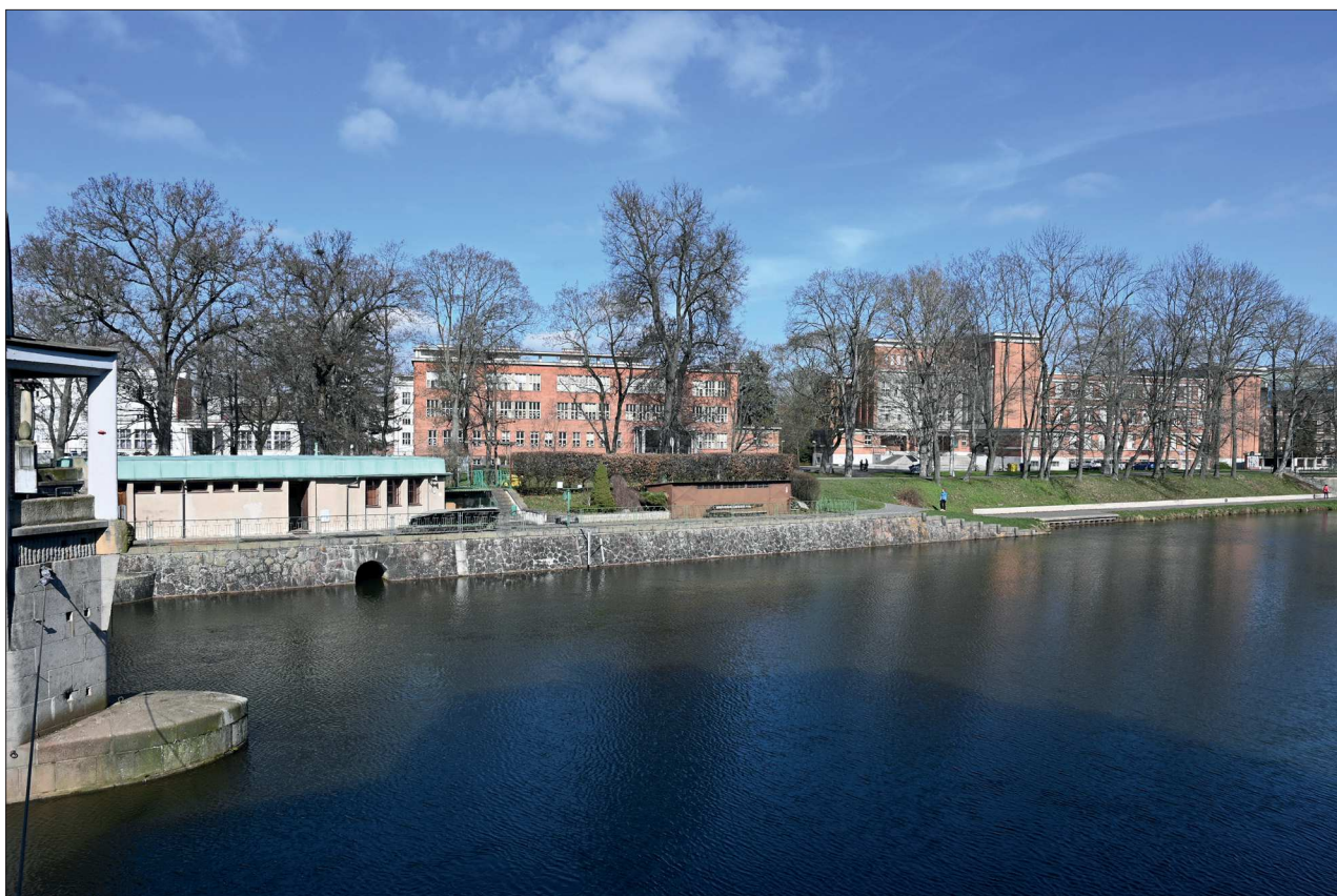
87. Celkový pohled na JV pilíř ostění průjezdu od západu
