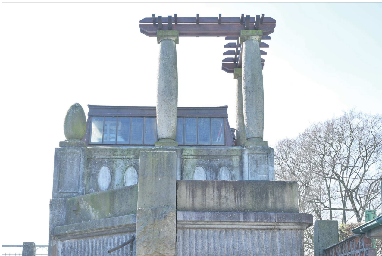
92. Pohled na JZ část SZ průčelí
