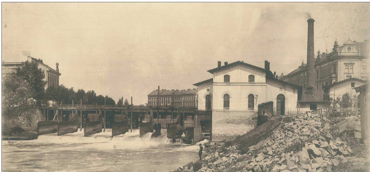
11. Fotografie staré městské parní vodárny na břehu neregulovaného Labe; cca 1904, SOkA Hradec Králové, sbírka fotografií, sign. I-69.
