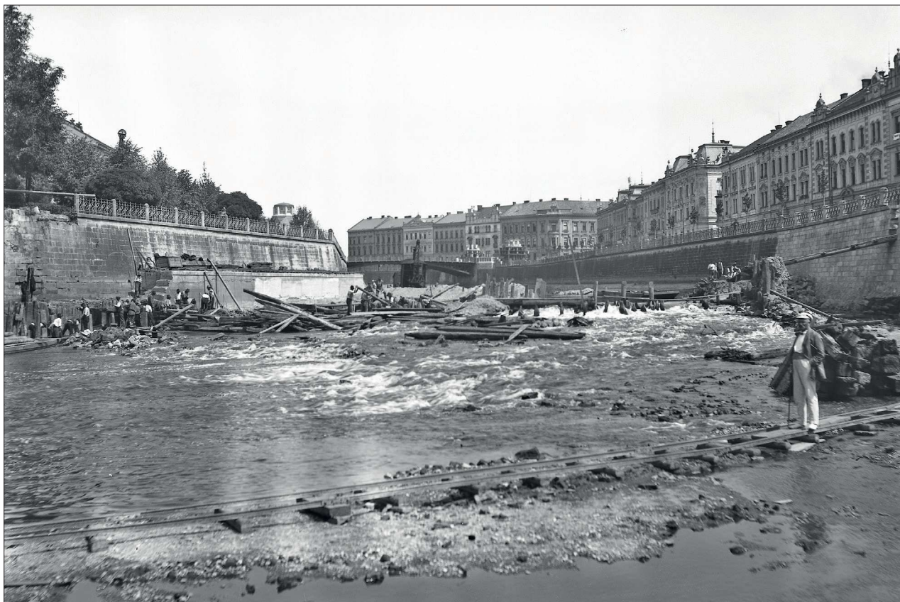
39. Bourání starého pevného jezu na Labi; 1911, Hradec Králové, Povodí Labe Hradec Králové, spisovna.
