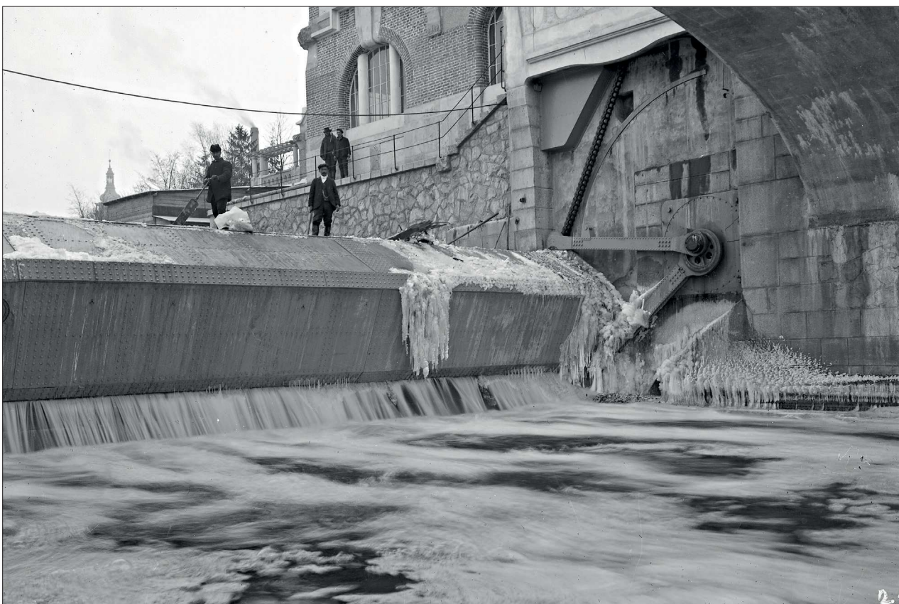
57. Fotografie zachycující odstraňování ledu u segmentů jezu; 1914, Hradec Králové; Povodí Labe Hradec Králové, spisovna.
