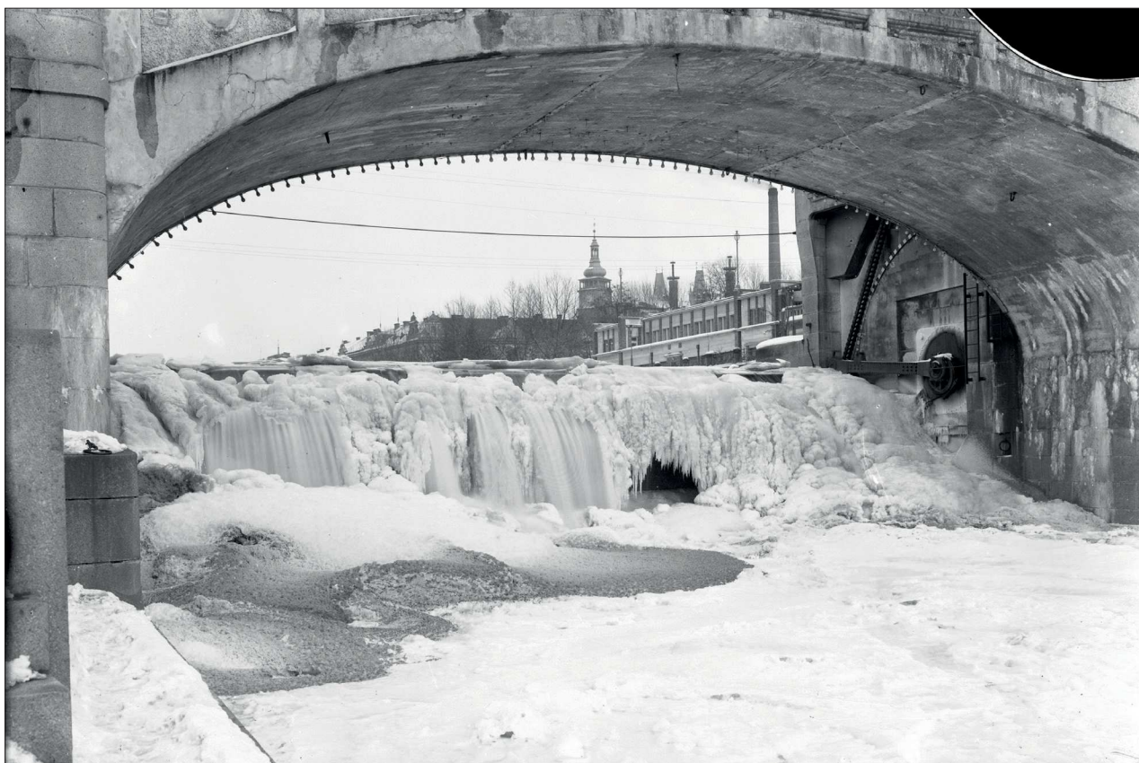
69. Detail zamrzlého jezového segmentu; cca 1929, Povodí Labe Hradec Králové, spisovna.
