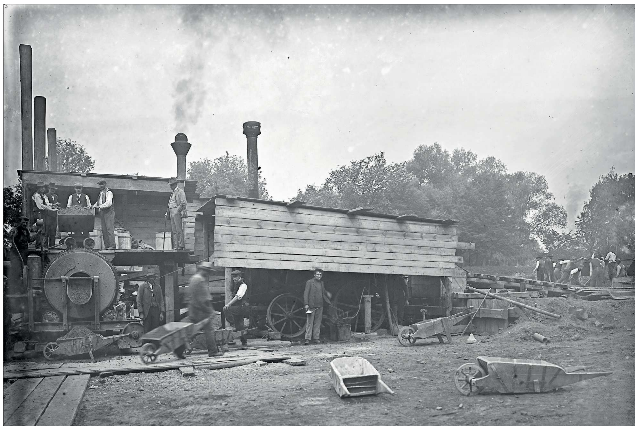
25. Fotografie míchačky a parních strojů používaných při výstavbě jezu; 1909, Hradec Králové, Povodí Labe Hradec Králové,
