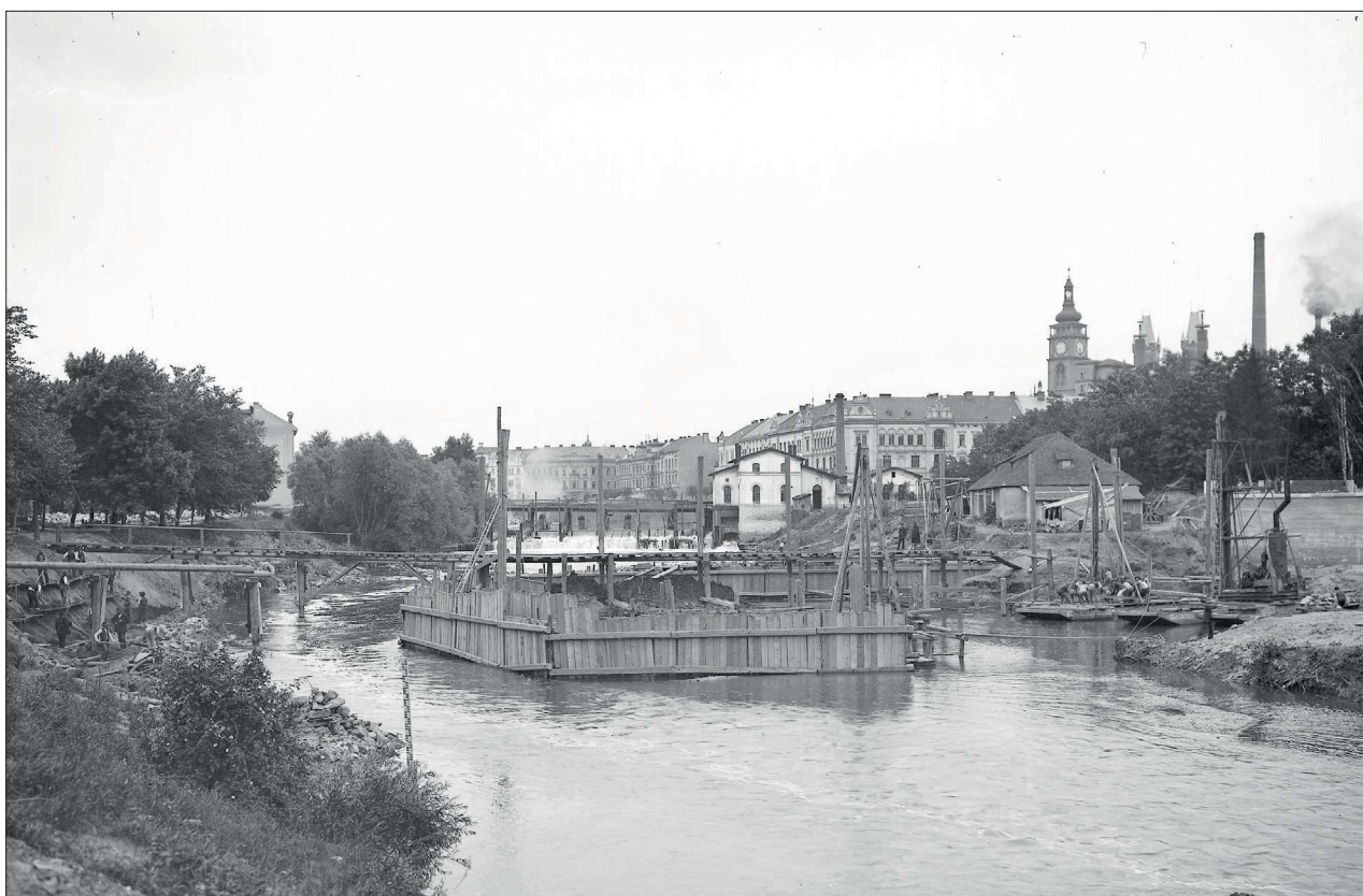
20. Fotografie dokumentující výstavbu jezu na Labi u důstojnického parku; 1909, Hradec Králové, Povodí Labe Hradec Králové, spisovna.
