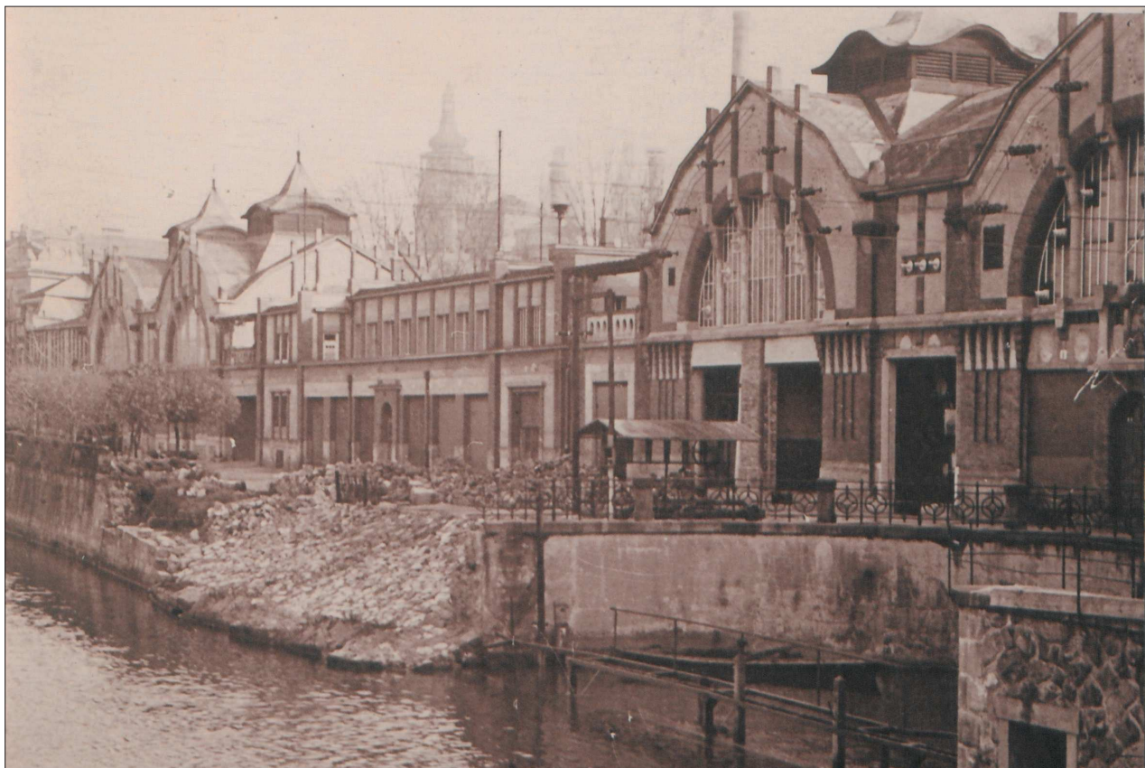
79. Fotografie poškozené nábřežní zdi, v pozadí celý komplex budov z jihozápadní strany, 1946, Archiv ČEZ v Hradci Králové.
