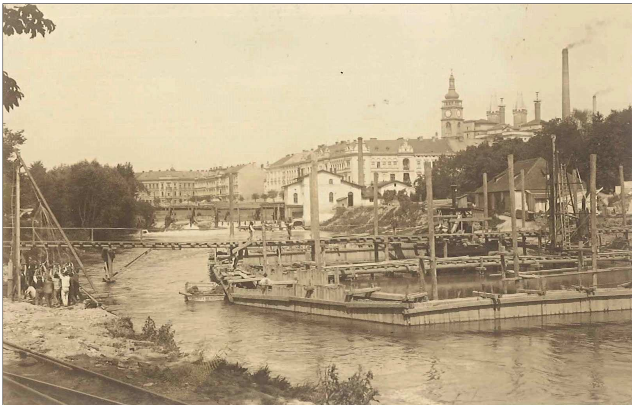
19. Fotografie dokumentující přípravu stavby nového jezu a mostu na Labi, v pozadí starý jez s vodárnou; cca 1909, SOKA Hradec Králové, sbírka fotografií, sign. I-178.
