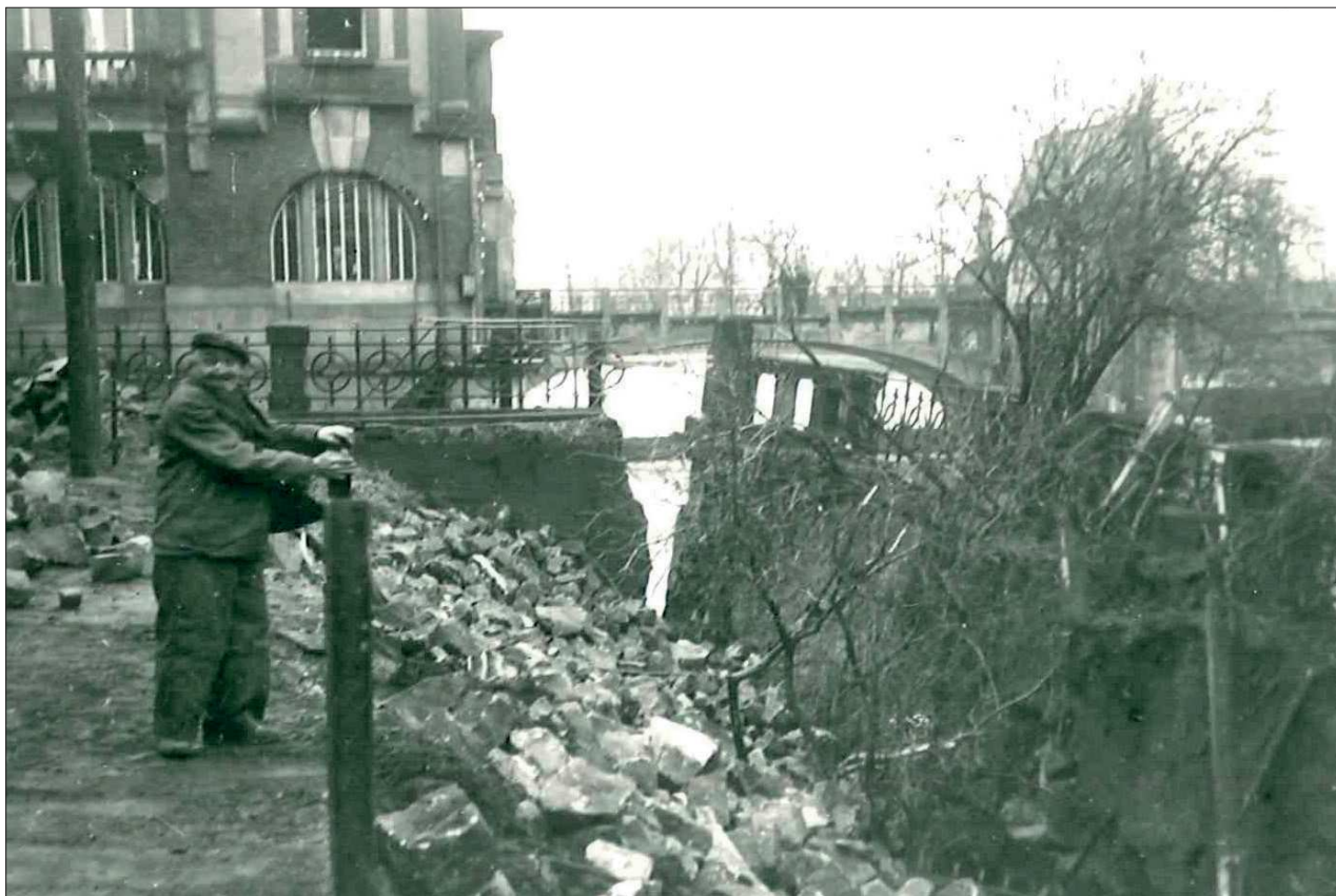
78. Fotografie velkou vodou poškozené nábřežní zdi; 1946, SOKA Hradec Králové, sbírka fotografií, sign. I-178.
