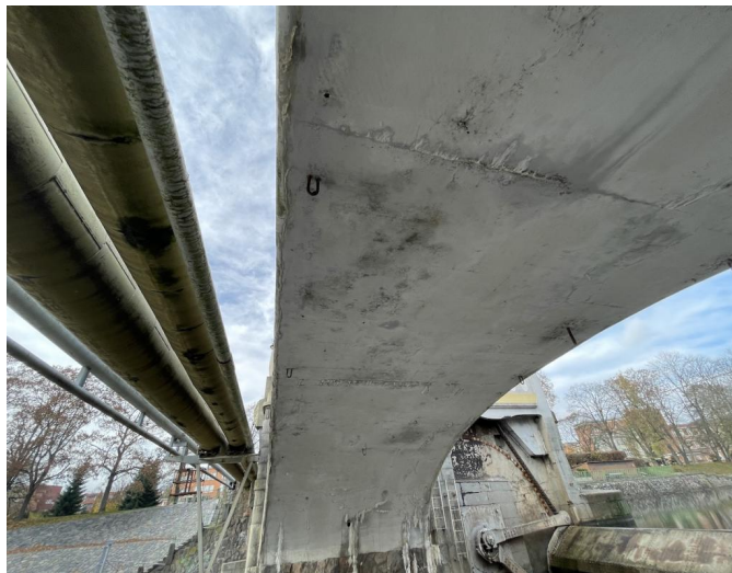
_Podhled pole 2 vlevo
