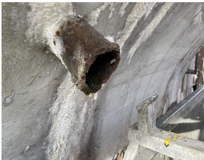
IMG_3939 - silná koruze svodů i vyústění odvodňovačů
