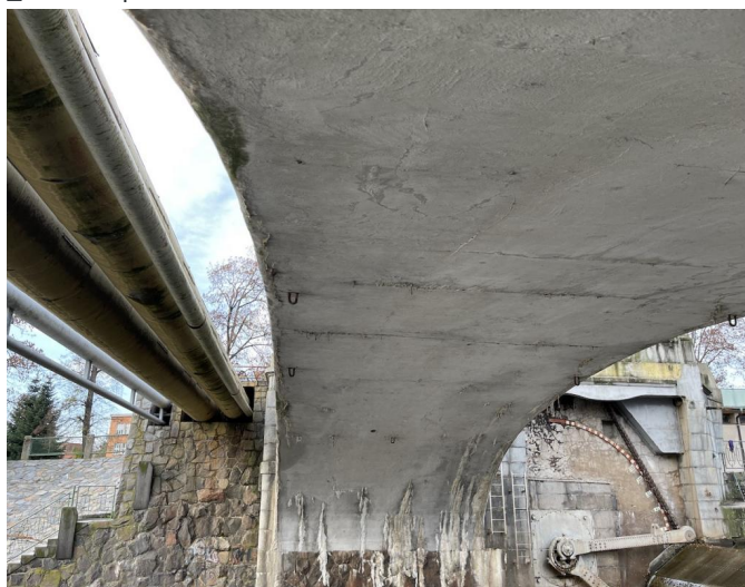
_Podhled pole 3 vlevo
