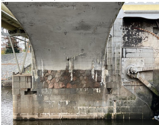
_Pohled na pilíř P3 z pole 2
