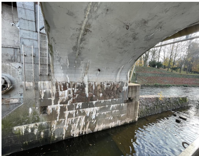
_Pohled na pilíř P2 z pole 2
