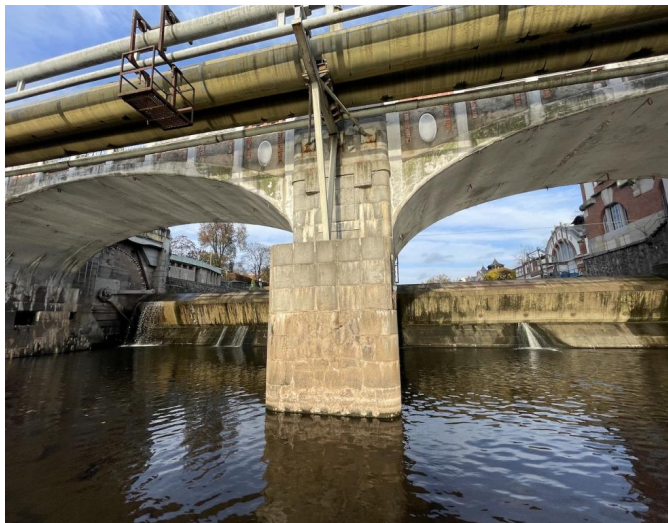
_ Pohled na pilíř P3 zleva
