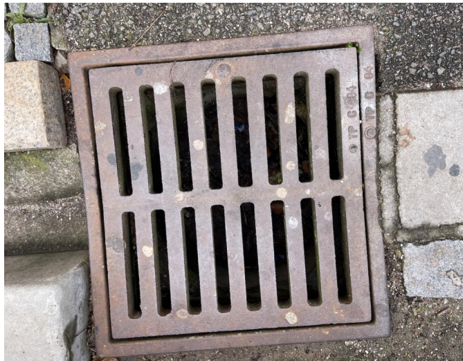
IMG_3969 - ve vpustích jsou nečistoty
