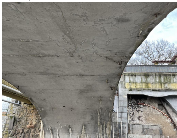
_Podhled pole 3 vpravo
