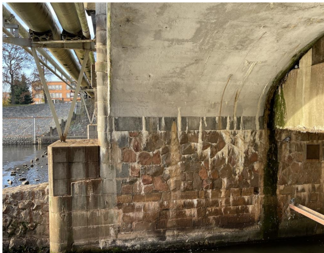
_Pohled na pilíř P2 z pole 1
