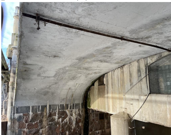
_ Podhled pole 1 vlevo
