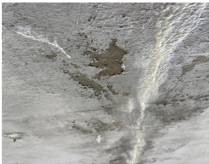
IMG_3894 - místy nesoudržný ochranný nátěr na podhledu NK
