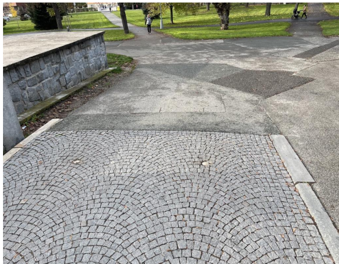
d_Přechod vozovky na most na konci mostu
