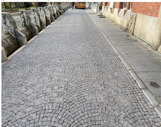
c_vozovka na objektu, pole 1
