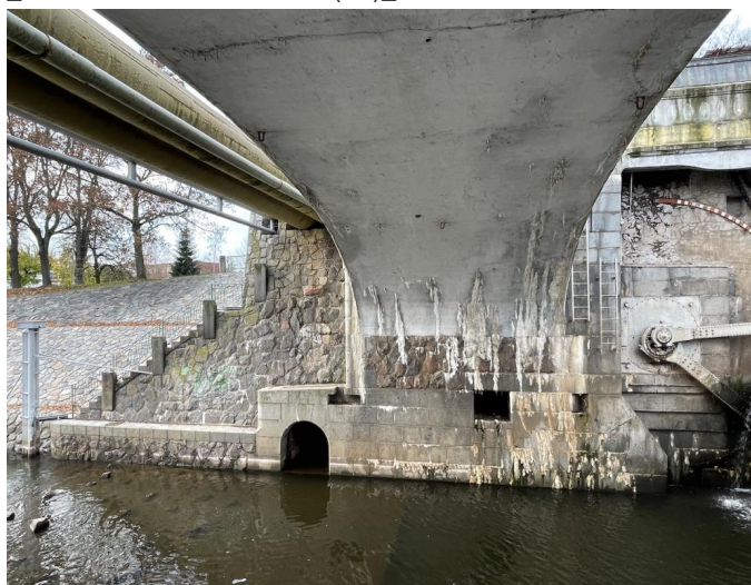
_ Pohled na opěru O4
