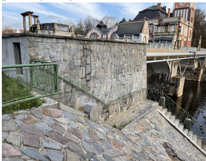
_ Levé křídlo na konci mostu (K3)_
