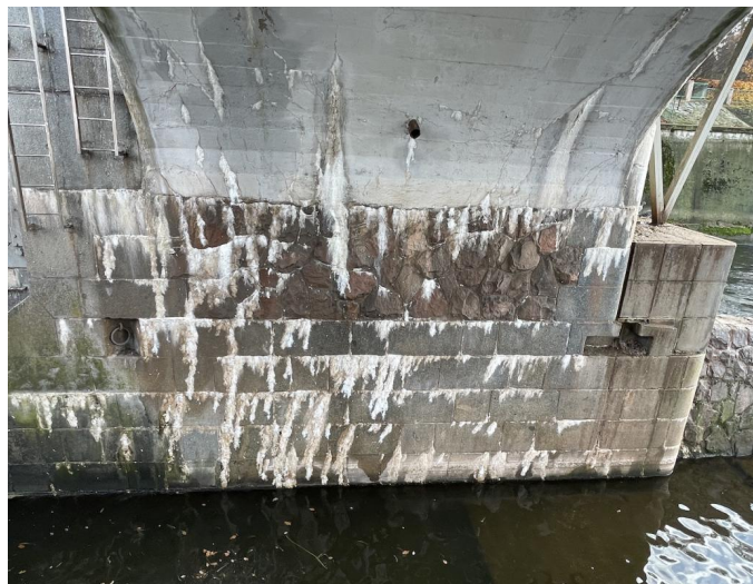
_Pohled na pilíř P2 z pole 2_
