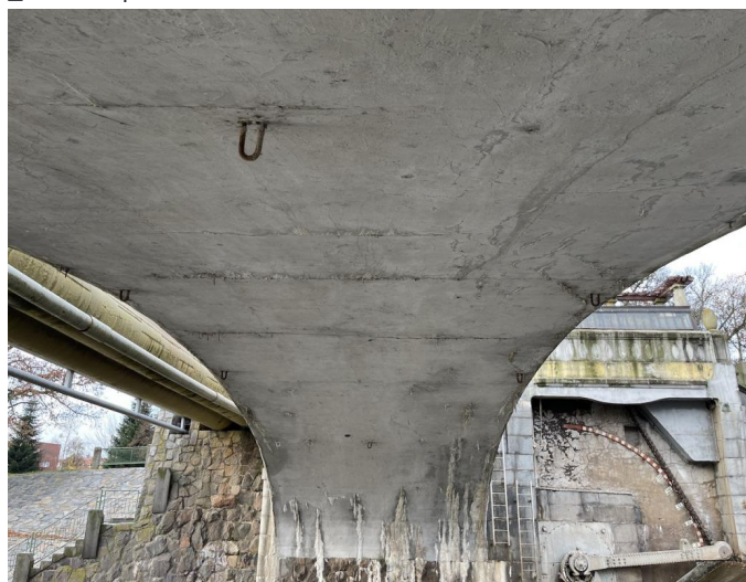
_Podhled pole 3 v ose
