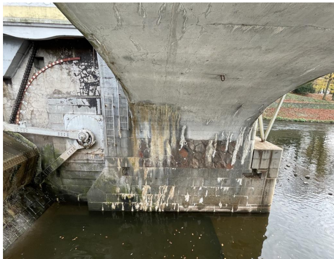
_ Pohled na pilíř P3 z pole 3
