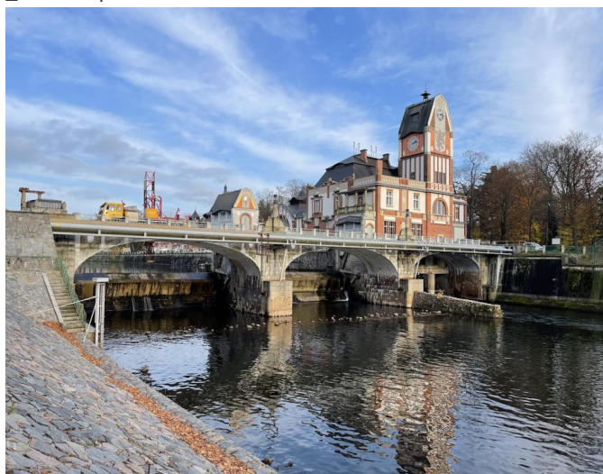
_Pohled na objekt zleva
