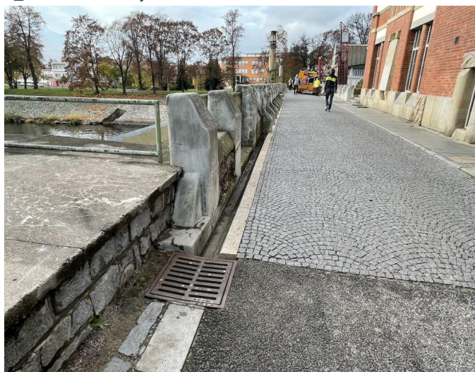
_Pohled na levé zábradlí po směru popisu
