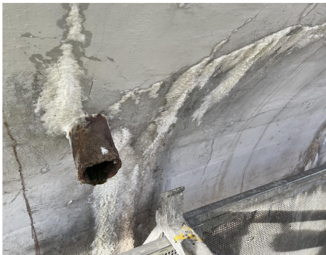
IMG_3941 - silná koruze svodů i vyústění odvodňovačů
