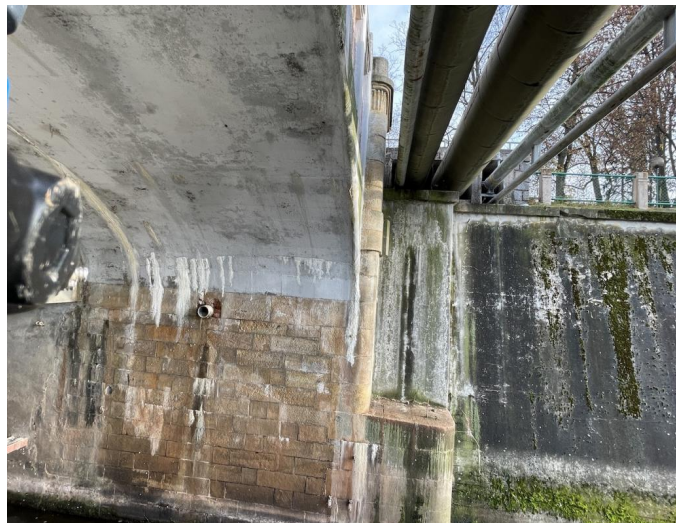
_Pohled na opěru O1
