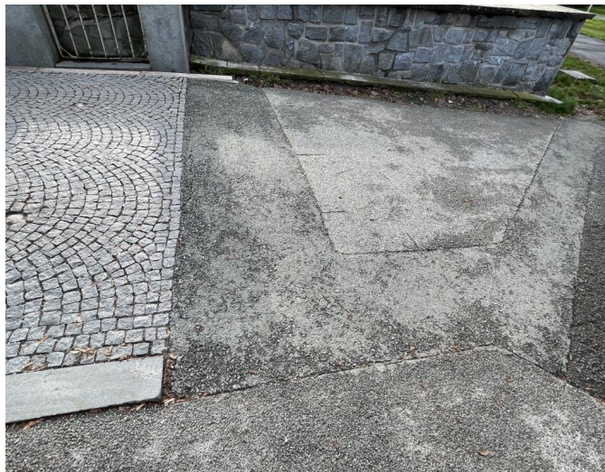
d_vozovka na konci objektu (předpolí)
