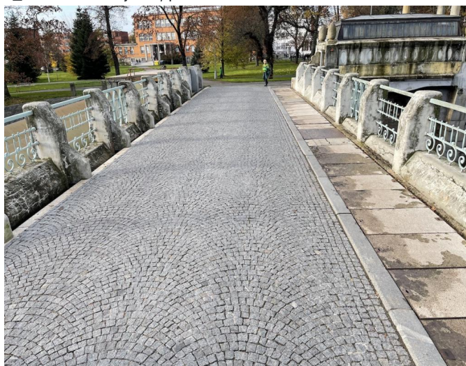
c_vozovka na objektu, pole 3
