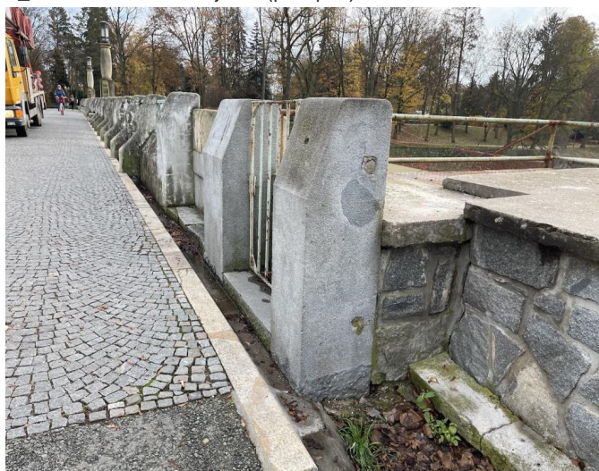
_Pohled na levé zábradlí proti směru popisu
