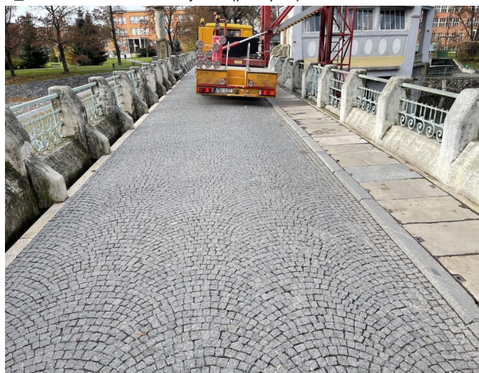
c_vozovka na objektu, pole 2
