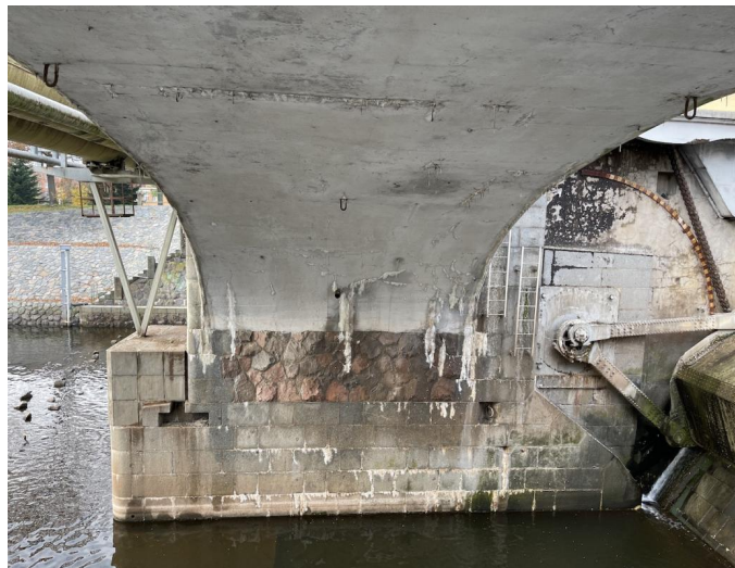
_Podhled pole 2 v ose
