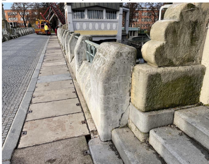
_Pohled na pravé zábradlí po směru popisu
