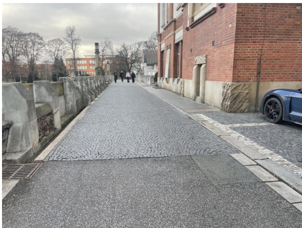
_Pohled na most po směru staničení
