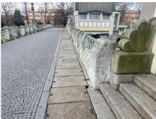
_Pohled na pravé zábradlí po směru staničení
