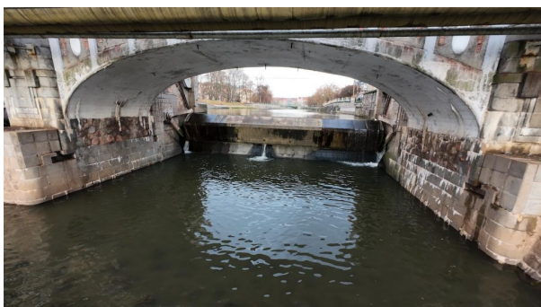
d_Podhled mostu, pole 2
