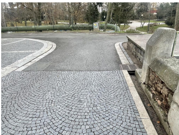
a_Vozovka na začátku mostu (předpolí)_
