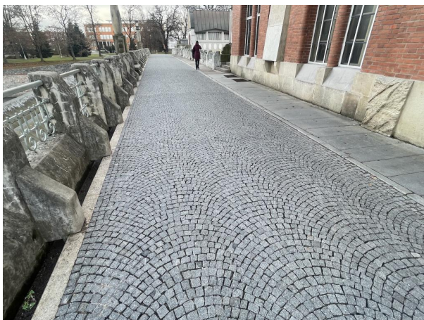
c_vozovka na mostě, pole 1
