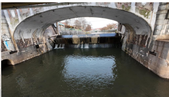
d_Podhled mostu, pole 3
