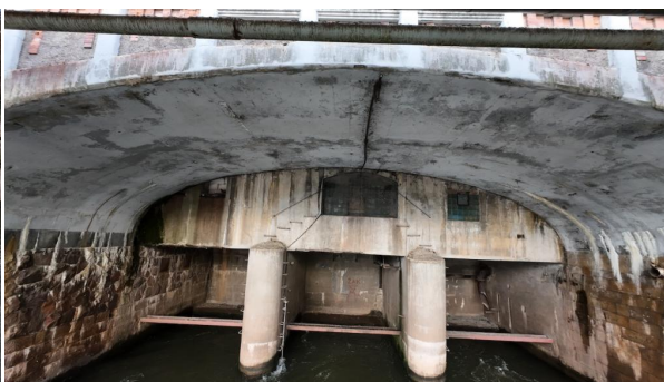
d_Podhled mostu, pole 1
