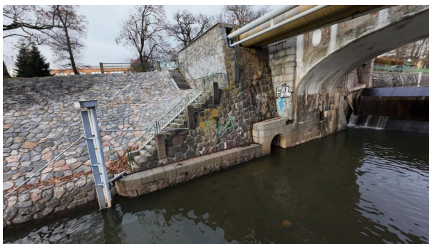
_ Pravé křídlo na konci objektu (K4), (navazující opěrná zed')
