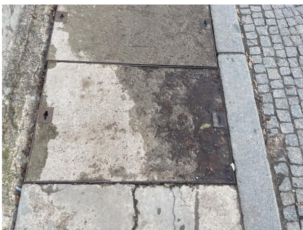
_stav pravého kabelového kanálu v roce 2024.
