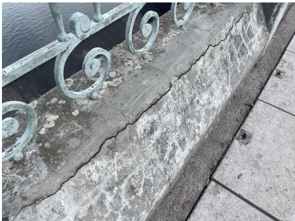
_stav pravého záchytného systému v roce 2024_
