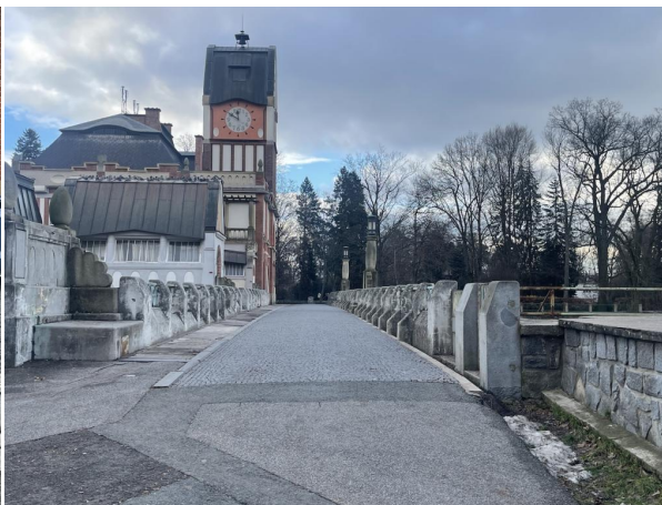
b_Pohled na most proti směru staničení
