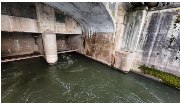
_ Pohled na opěru O1
