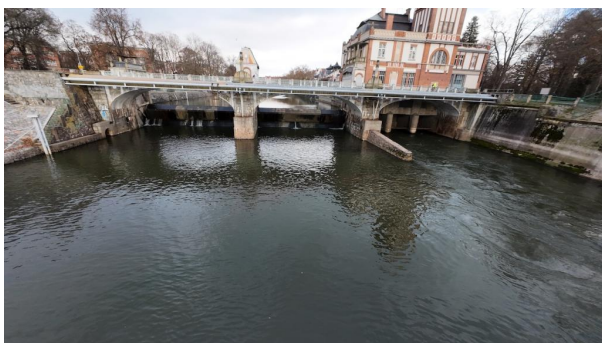
_ Pohled na objekt zleva
