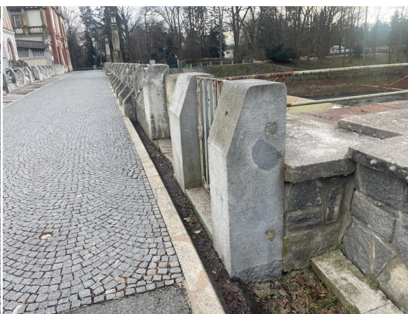
_Pohled na levé zábradlí proti směru staničení
