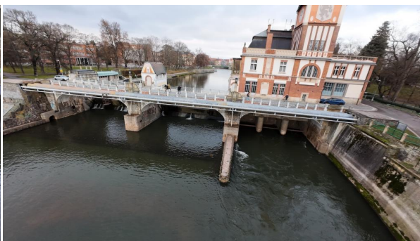
_ Pohled na objekt zleva
