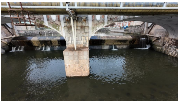
_ Pohled na pilíř P3 zleva
