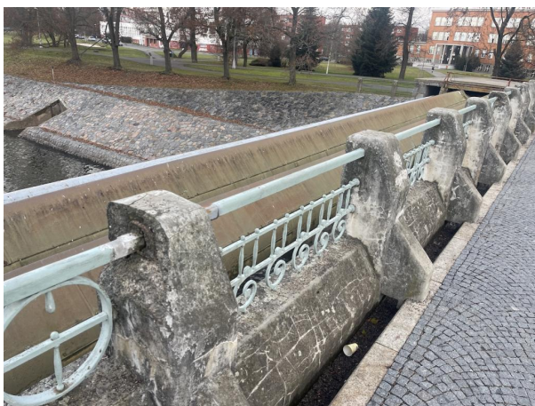
_stav levého záchytného systému v roce 2024._
