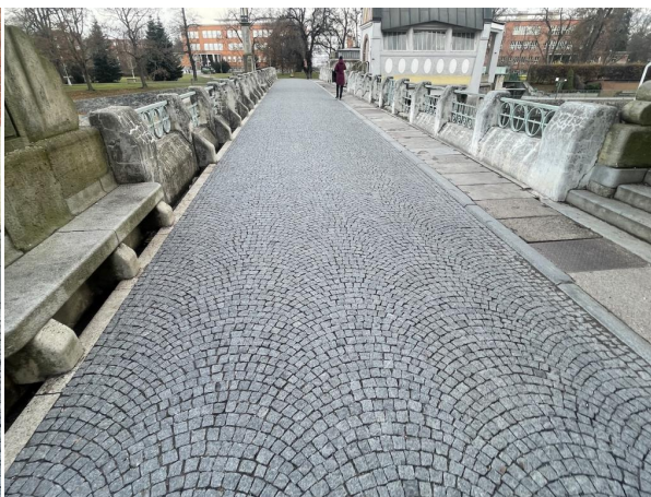
c_vozovka na mostě, pole 2
