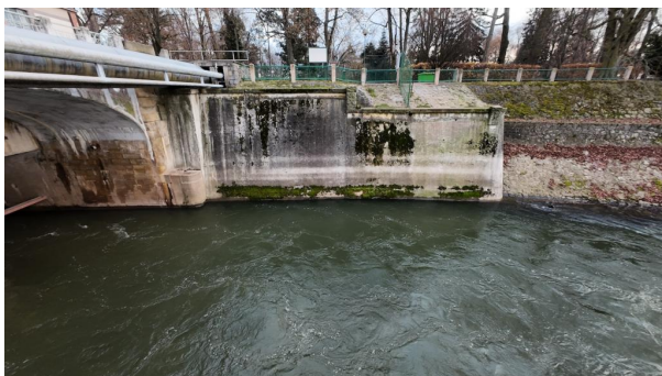
_ Levé křídlo na začátku objektu (K1), (navazující opěrná zeď)
