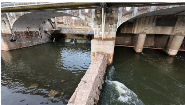
_ Pohled na pilíř P2 zleva
