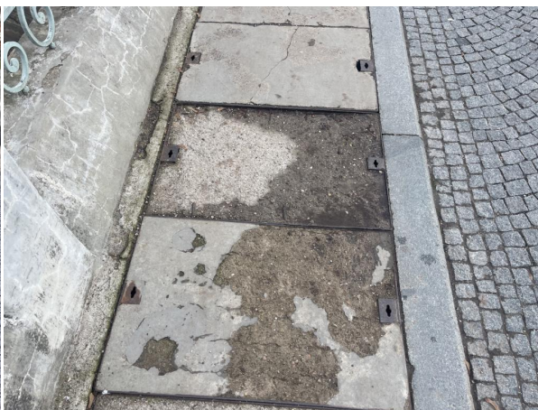
_stav pravého kabelového kanálu v roce 2024__
