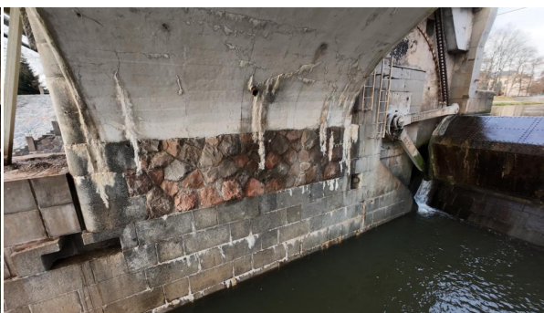
_ Pohled na pilíř P3 z pole 2_
