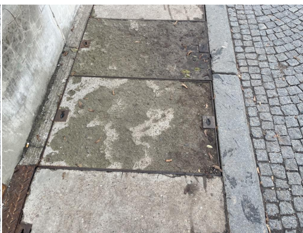
_stav pravého kabelového kanálu v roce 2024
