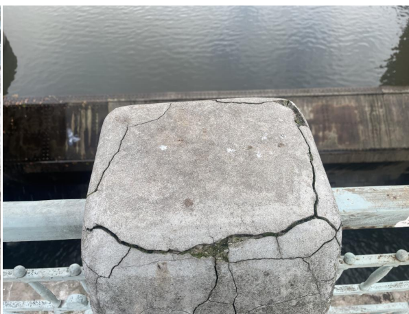
_stav pravého záchytného systému v roce 2024_.
