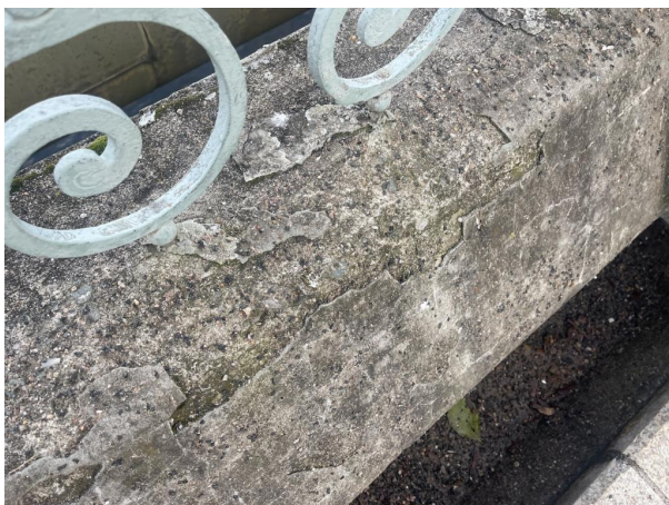
_stav levého záchytného systému v roce 2024,._
