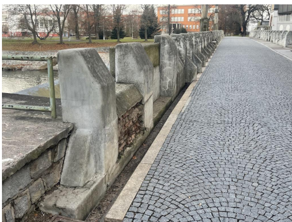
_Pohled na levé zábradlí po směru staničení
