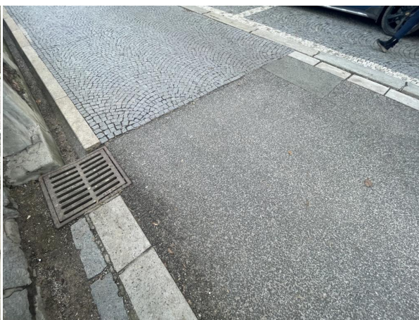
a_Vozovka na začátku mostu (předpolí)
