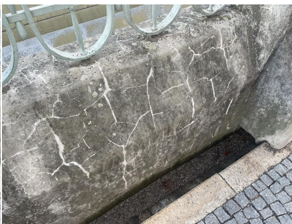
_stav levého záchytného systému v roce 2024_
