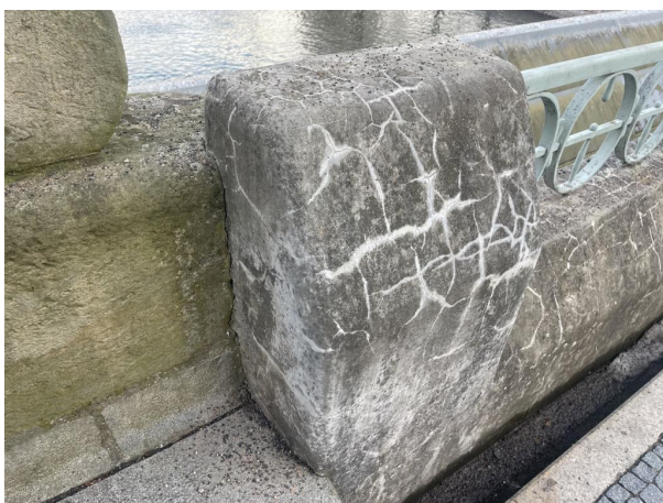
_stav levého záchytného systému v roce 2024_.
