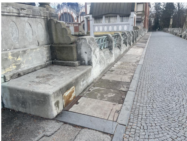
_Pohled na pravé zábradlí proti směru staničení
