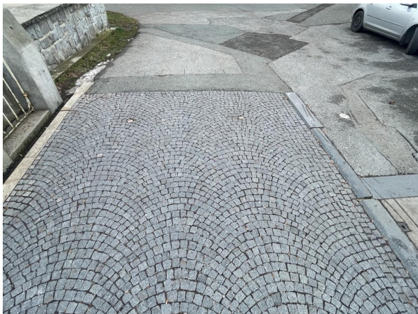
c_vozovka na mostě, pole 3
