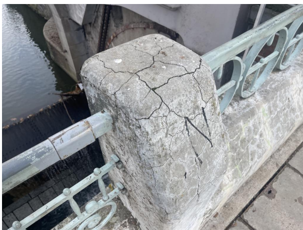
_stav pravého záchytného systému v roce 2024_.
