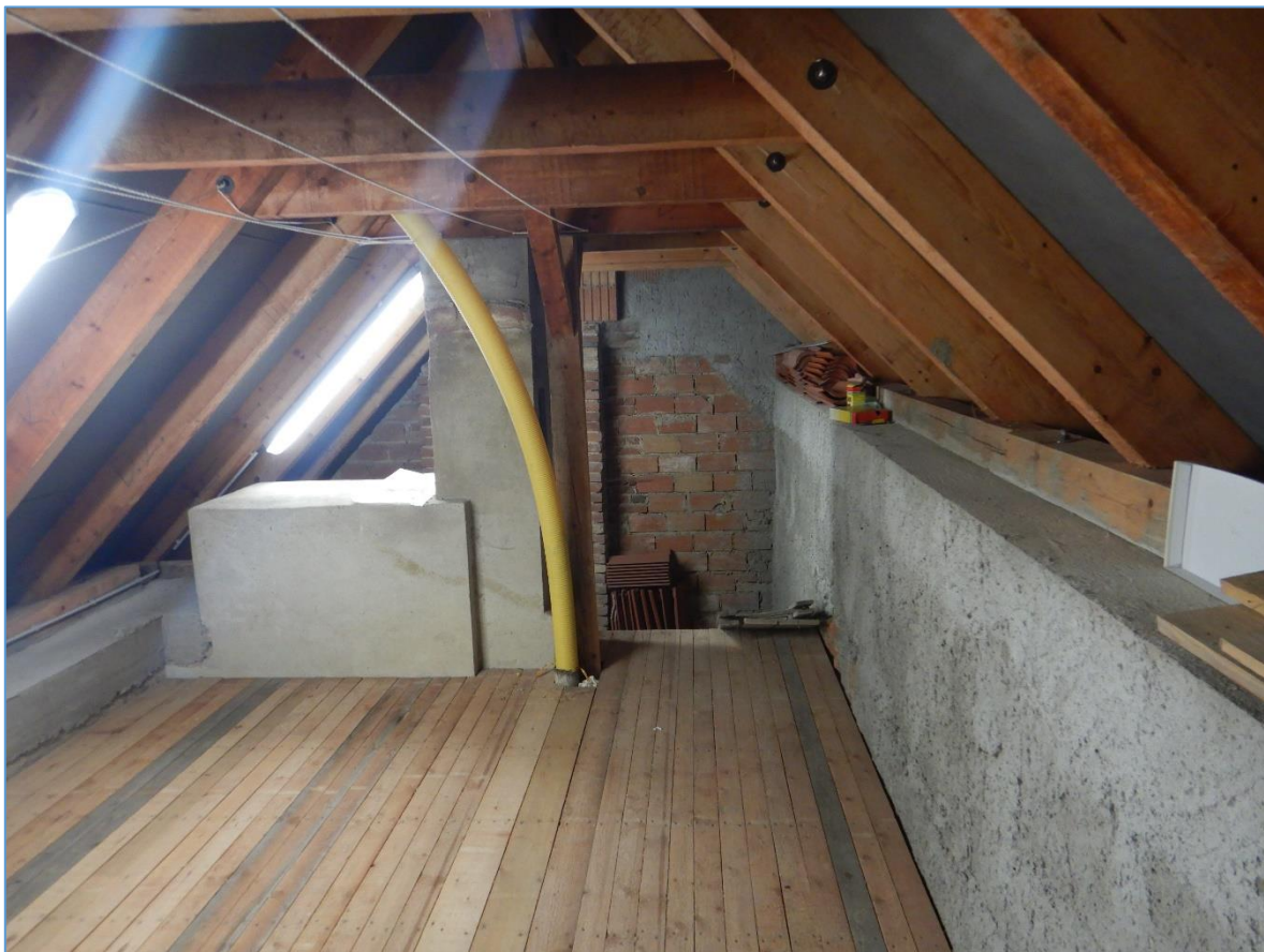
Obr.č. 5 – KROVOVÁ SOUSTAVA – BEZ NÁLEZU - INDEX B
