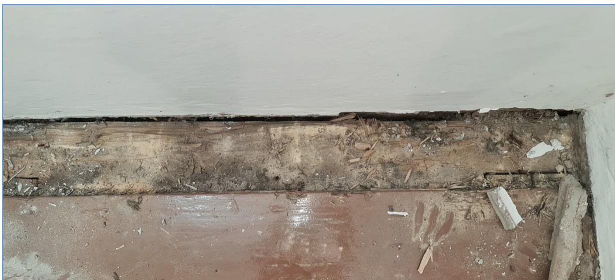
Obr.č. 2 – SONDA DO SCHODIŠTNÍ PODESTY MEZI 1. A 2.NP – LOKÁLNÍ VÝLETOVÉ OTVORY A POŽEREK LAREV DŘ. HMYZU ČELEDI ANOBIDAE - INDEX C
