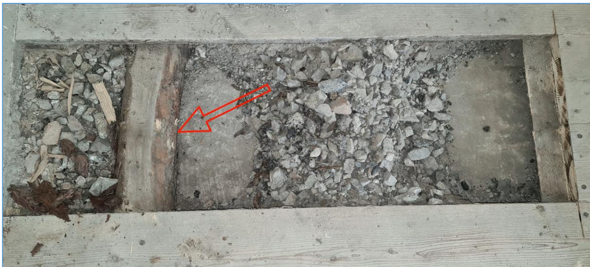
Obr.č. 1 – SONDA DO VODOROVNÉ KCE 1.NP – LOKÁLNÍ VÝLETOVÉ OTVORY A POŽEREK LAREV DŘ. HMYZU ČELEDI CERAMBYCIDAE - INDEX C
