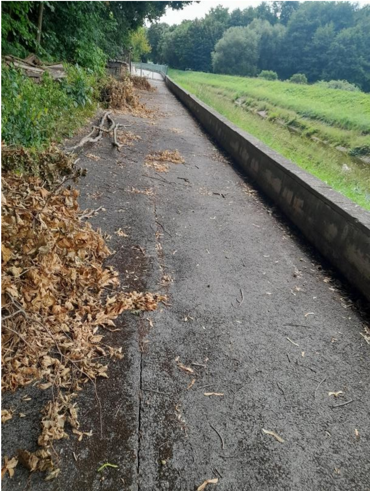
SO 2 - Pohled od jezu k provoznímu objektu
