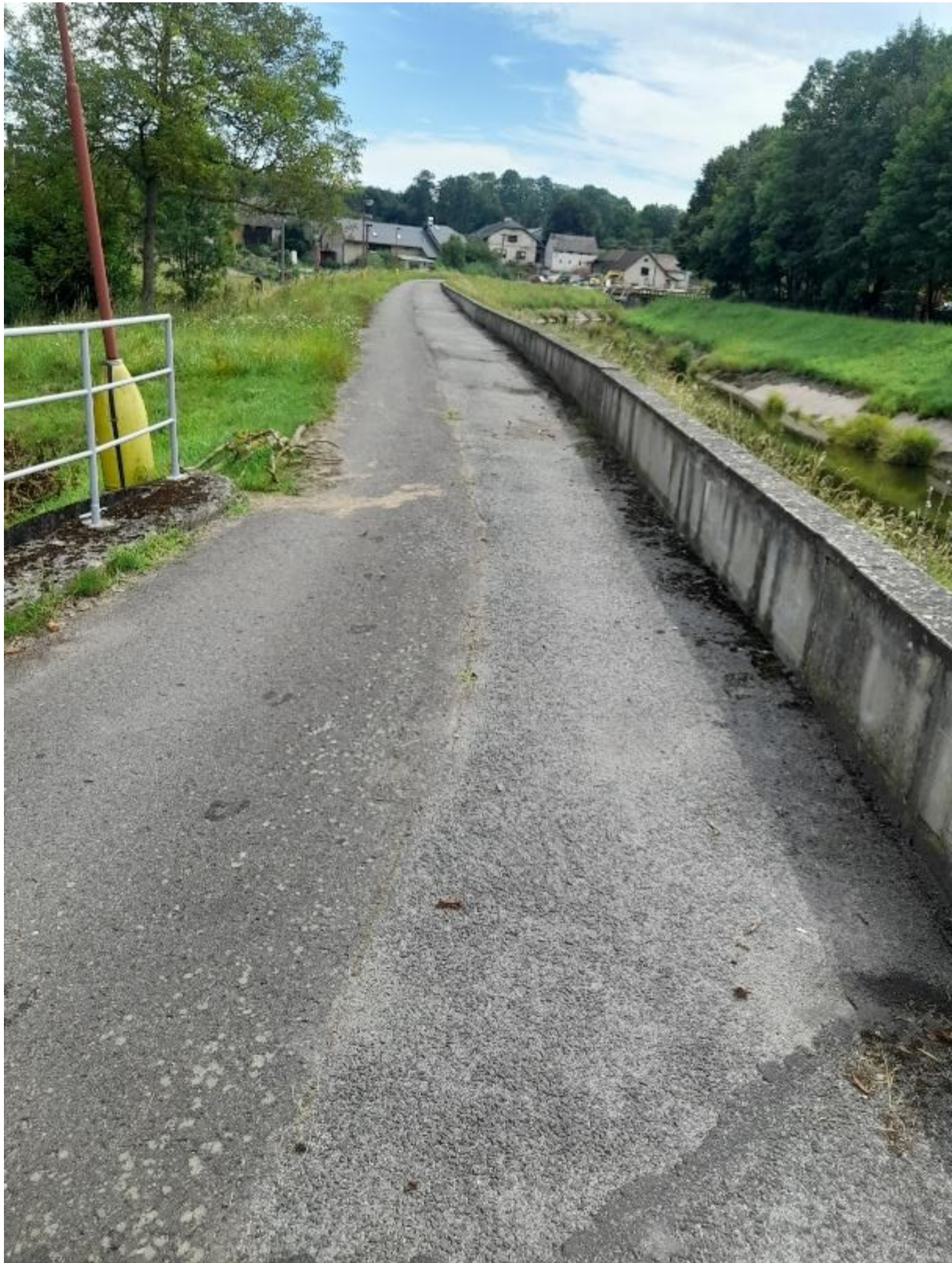
SO 1 - Pohled od provozního objektu k hlavní komunikaci
