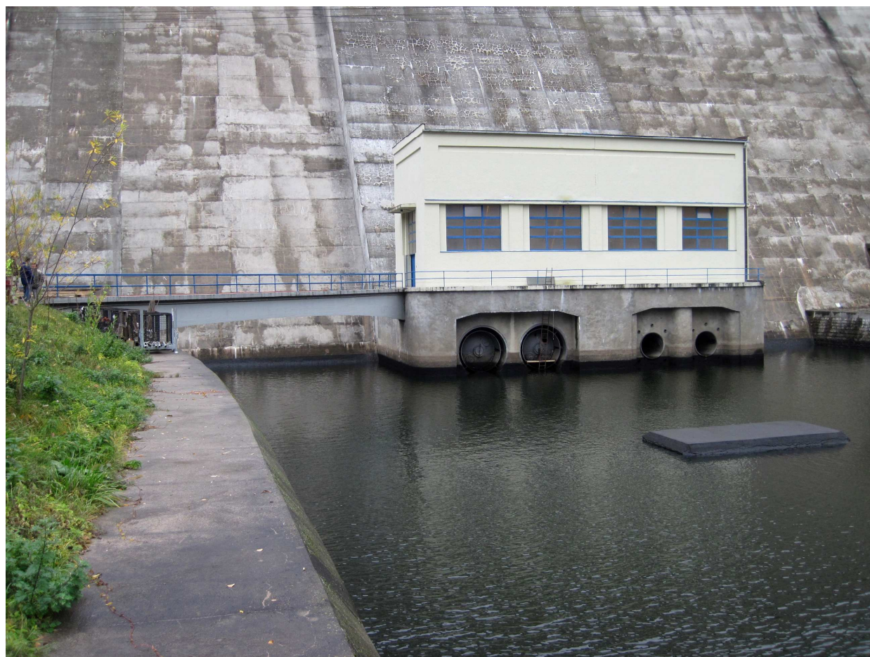
Pohled na povodní provozní regulační uzávěry z podhrází
