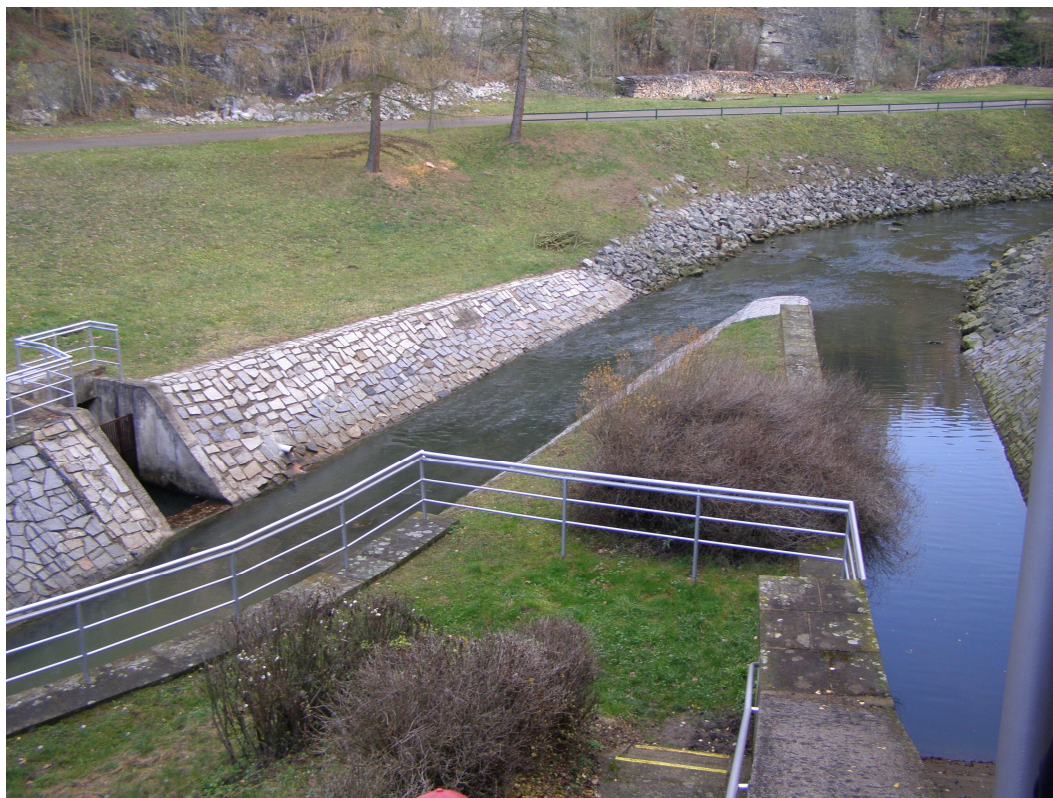
Foto 9: Vývar skluzu, zaústění do odpadního koryta, pohled po vodě
