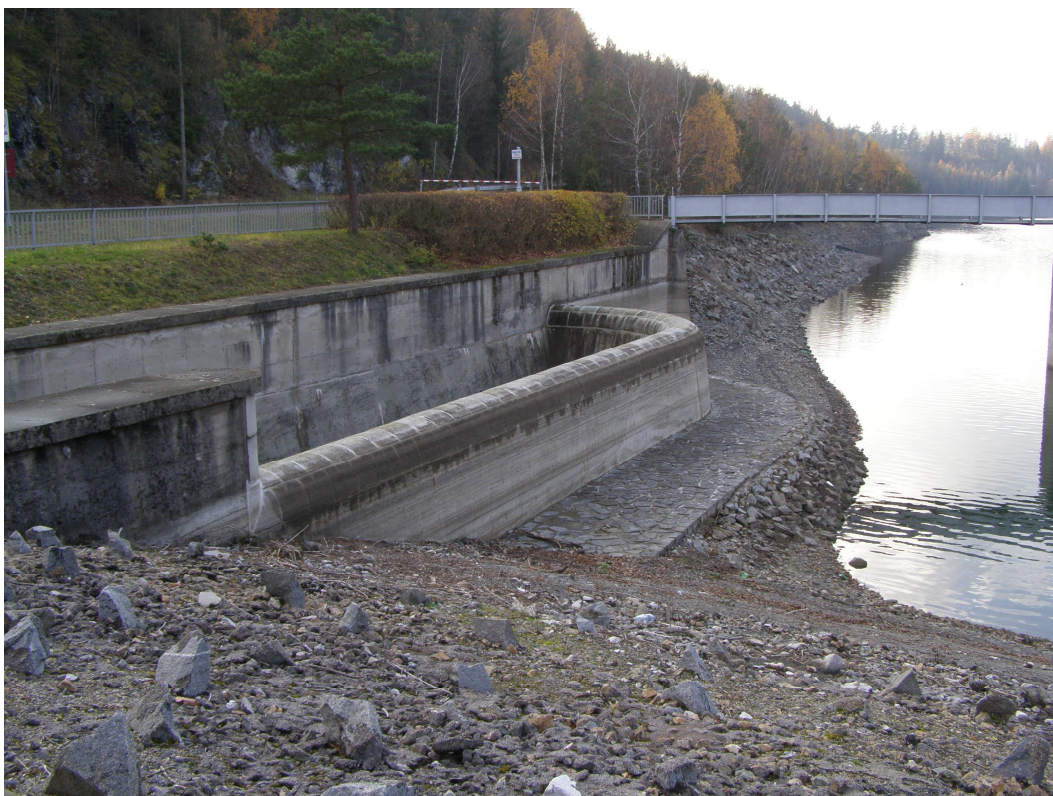
Foto 4: Bezpečnostní přeliv, spadiště - pohled z hráze
