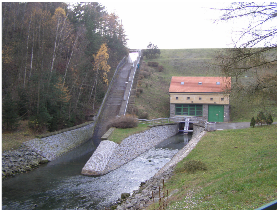
Foto 10: Podhrází, pravobřežní zavázání hráze, skluz, strojovna spodních výpustí
