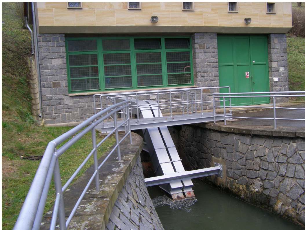
Foto 11: Detail vyústění spodních výpusť a MVE
