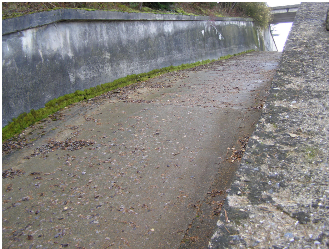
Foto 8: Pohled na skluz – detail nevhodného zalomení podélného spádu
