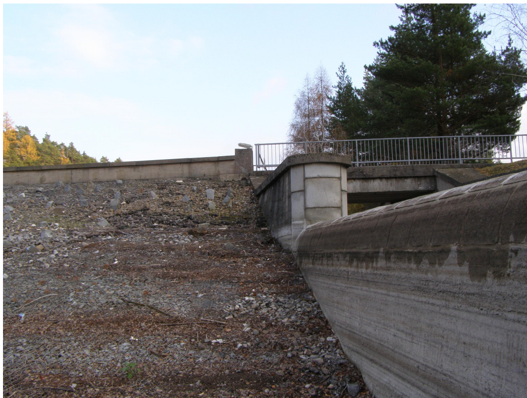
Foto 5: Bezpečnostní přeliv, zavázání do tělesa hráze
