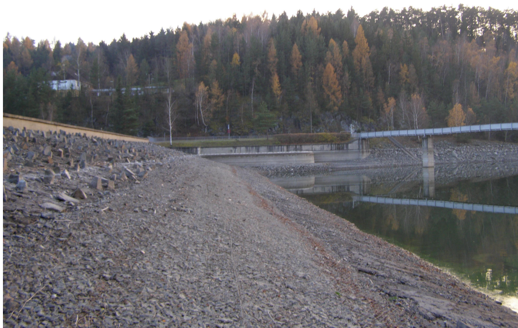
Foto 16: Pohled na sanovaný návodní líc hráze z levobřežního zavázání
