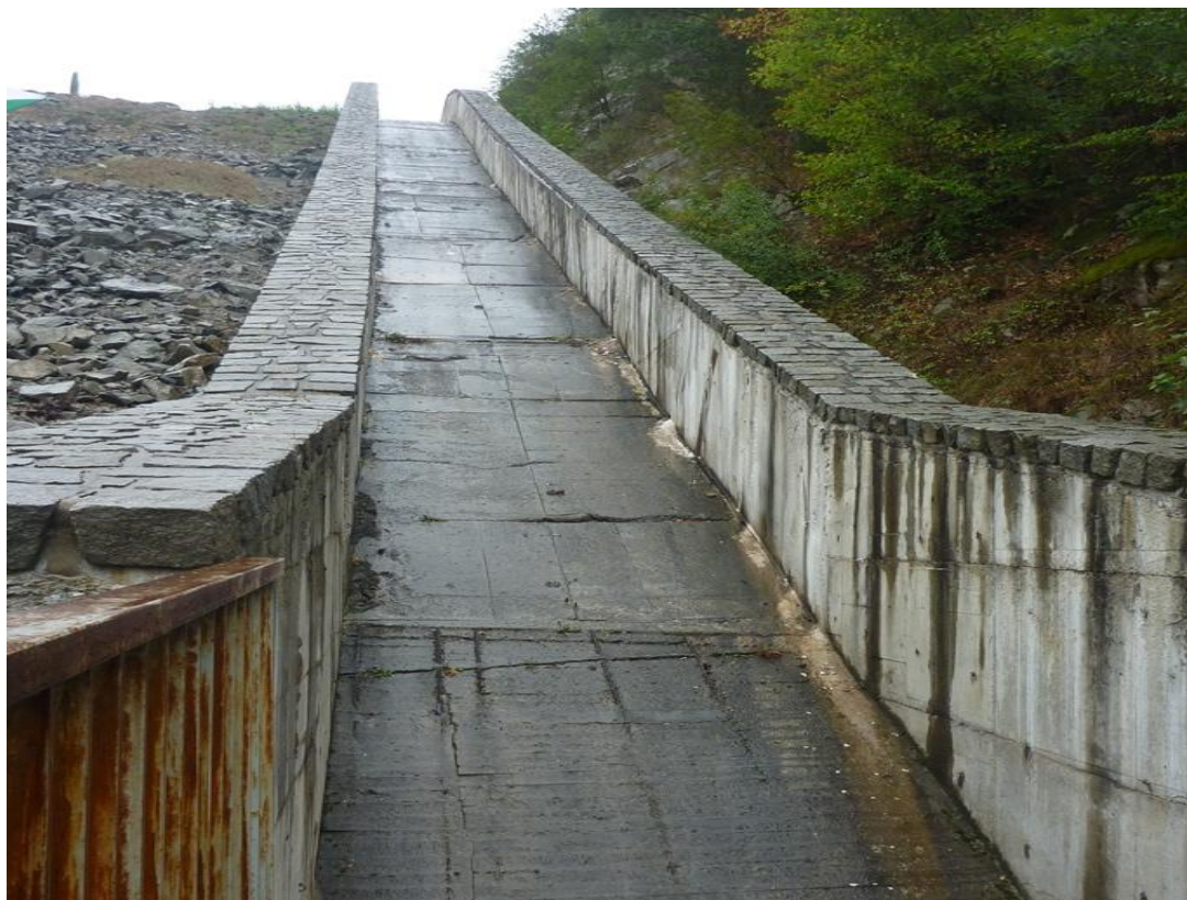
Obr.4 Stávající skluz – pohled proti vodě
