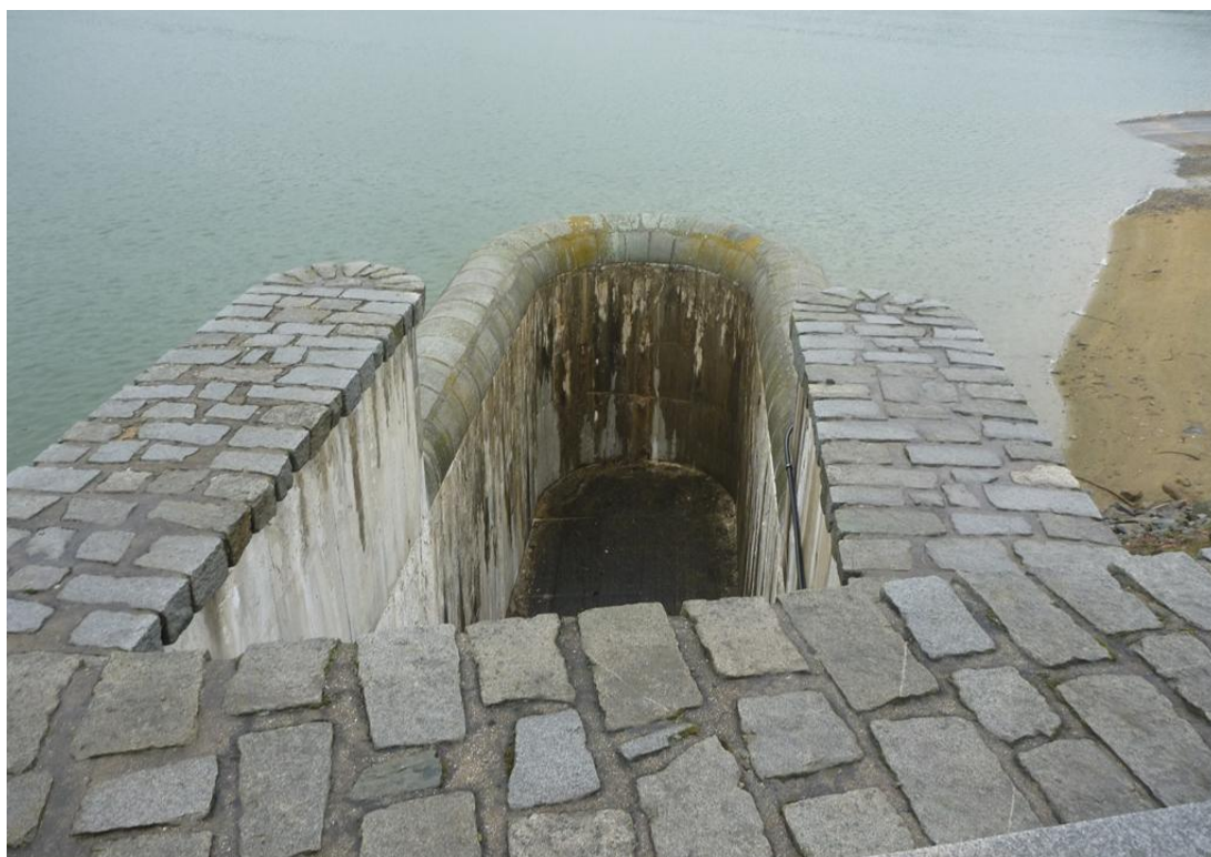
Obr.2 Bezpečnostní přeliv – pohled do přelivu z přemostění
