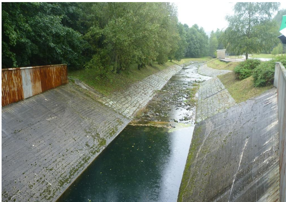
Obr.6 Stávající vývar a navazující odpadní koryto – pohled po vodě
