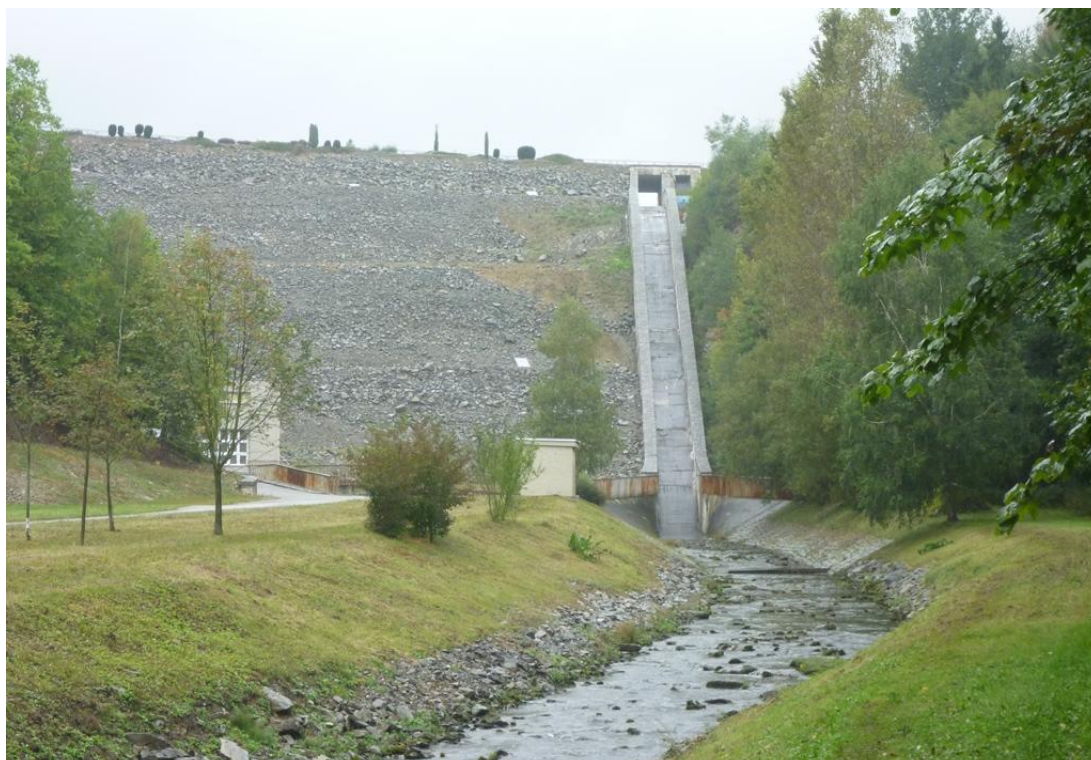
Obr.7 Odpadní koryto, vývar a skluz – pohled proti toku
