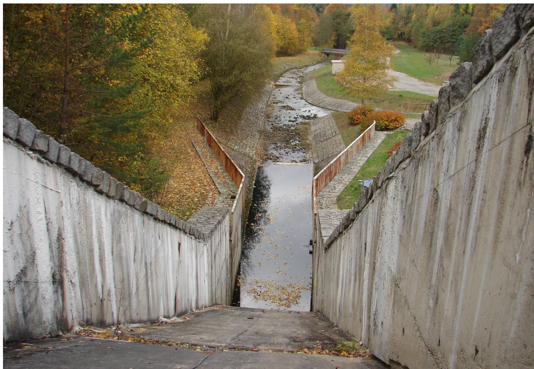
Obr.5 Stávající skluz a vývar – pohled po vodě
