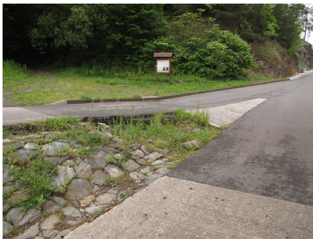
chybějící rovinanina na křižovatce
