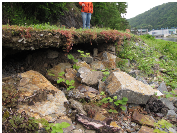
foto č.2 vymletá kaverna pod komunikací
