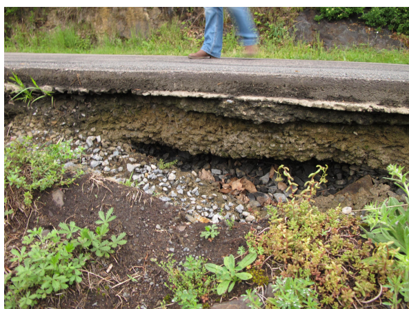
foto č.3 vymletá kaverna pod komunikací, patrná skladba komunikace
