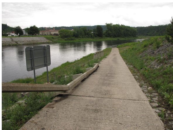
povalené zábradlí podél sjezdové rampy
