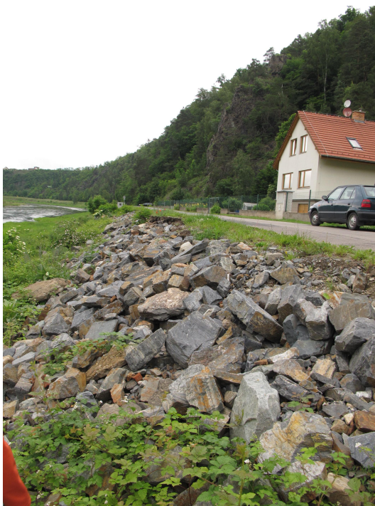
načechráný kamenný zához, odplavená krajnice
