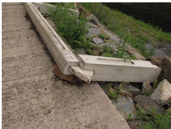
detail poškozeného zábradlí
