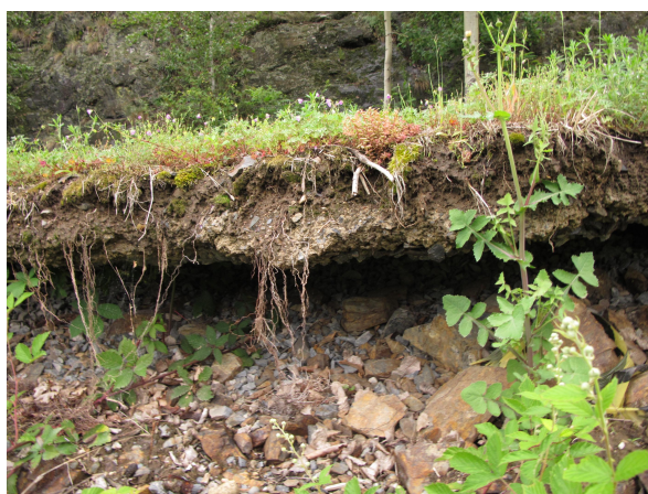
foto č.4 vymletá kaverna pod komunikací
