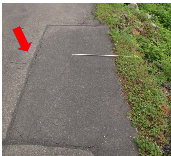
foto č.5 kaverna zasahující až 1 m pod asfaltový kryt patrné trhliny ve vozovce – propadání vozovky do kaverny
