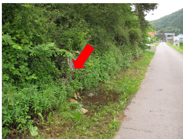
foto č.6 prameniště ve skále – vznik louže a podmáčení vozovky
