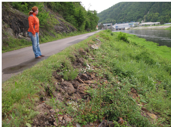
foto č.1 odplavený zához krajnice komunikace
