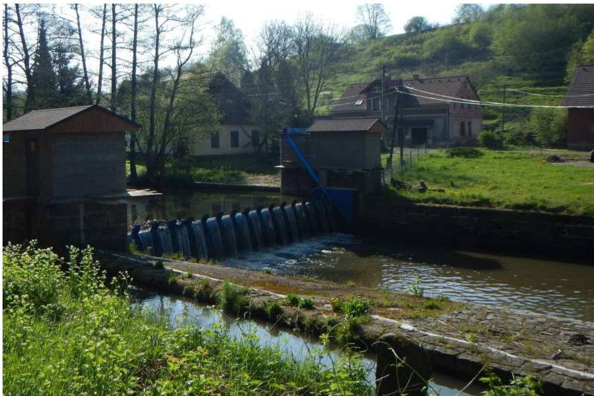
Jez v ř.km 7,321
