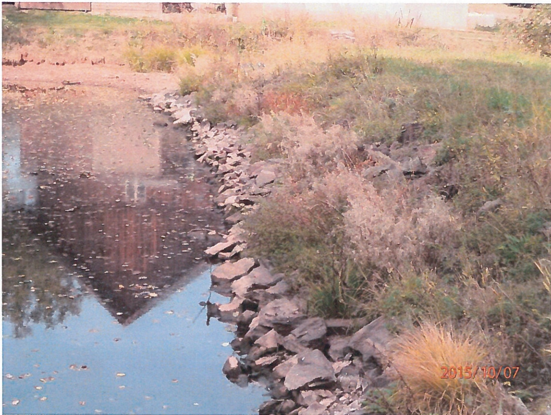
Opevnění vodorysu je současné době neurovnané, s využitím materiálu různých frakcí.
