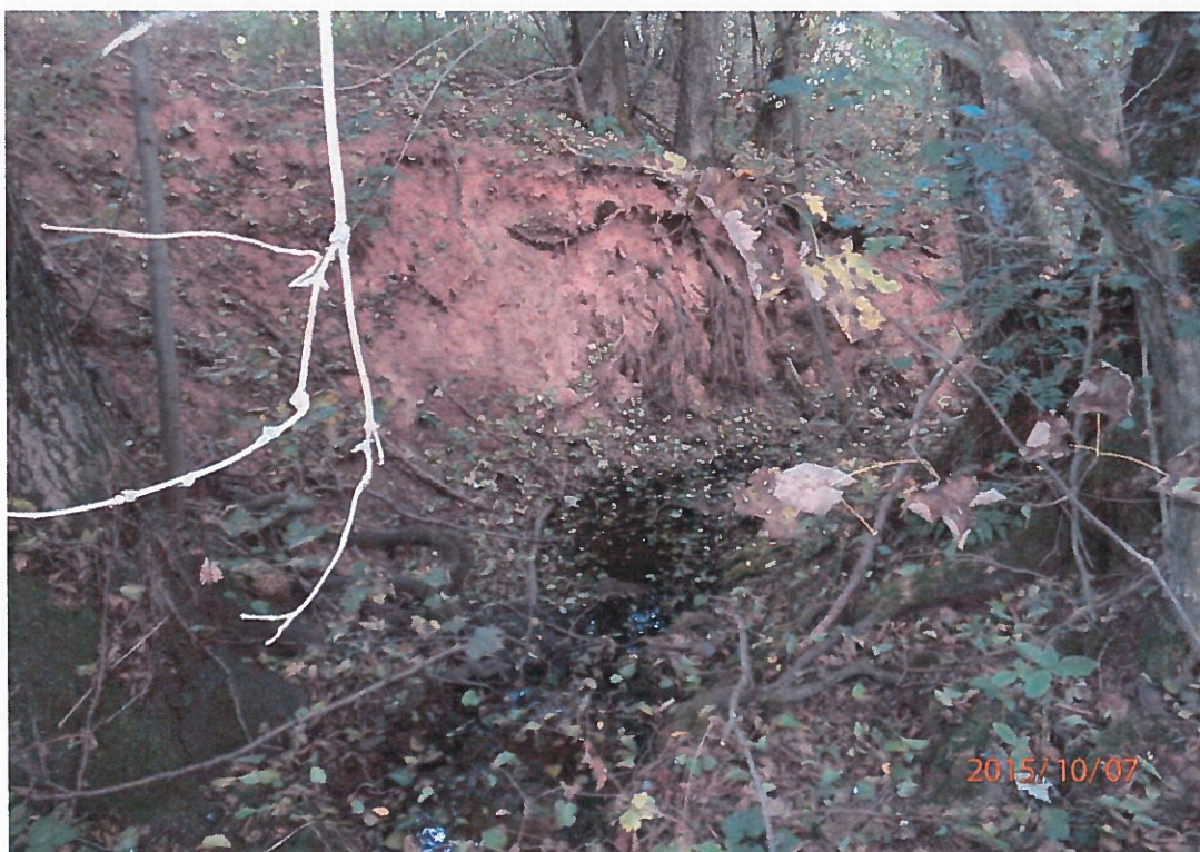
Břehové nátrže vzniklé nevhodným vyústěním odpadu od bezpečnostního přelivu.
