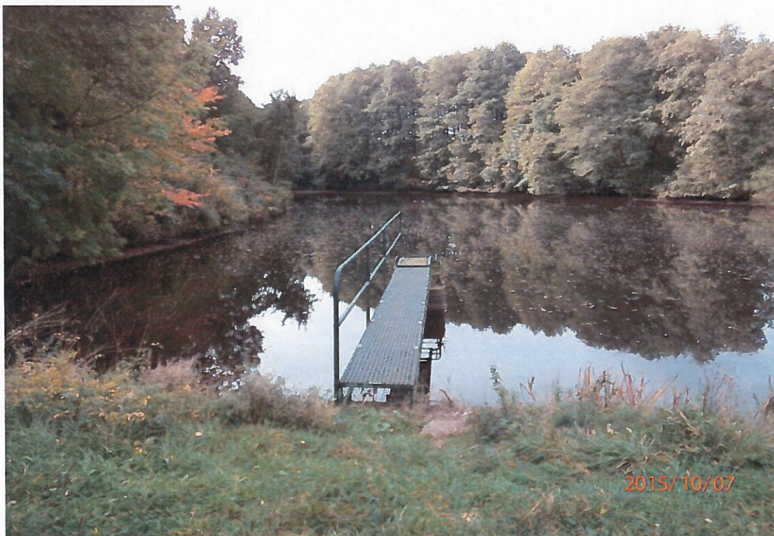
Stávající výpustné zařízení s přístupovou lávkou
