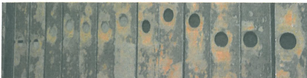
foto č. 5-detail levého dílu česlí
