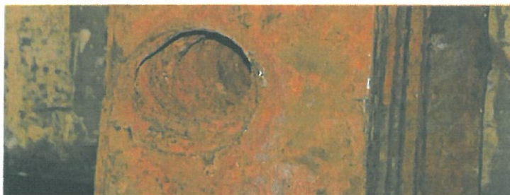
foto č. 6-vrtání česlí nad hladinou
