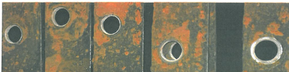
foto č. 6-vrtání česlí nad hladinou
