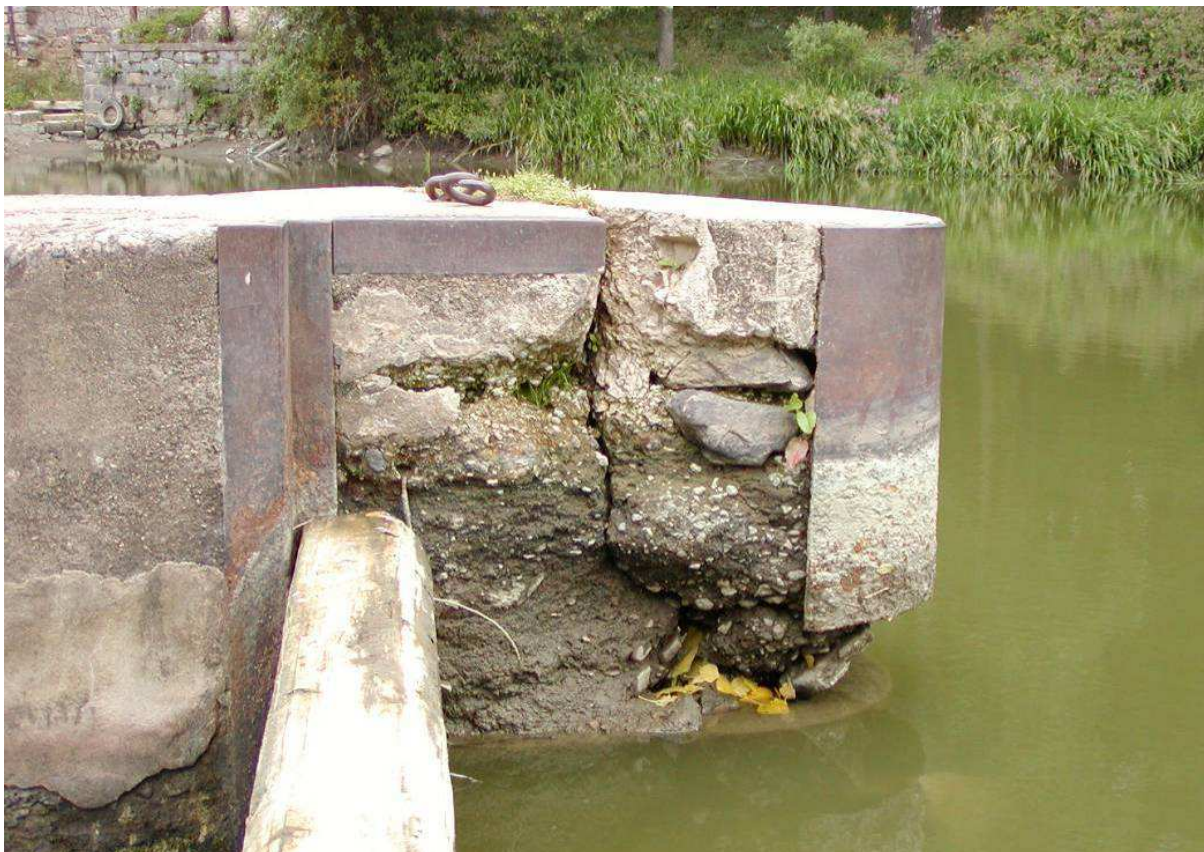
Obr.9. Detail pilíře propusti
