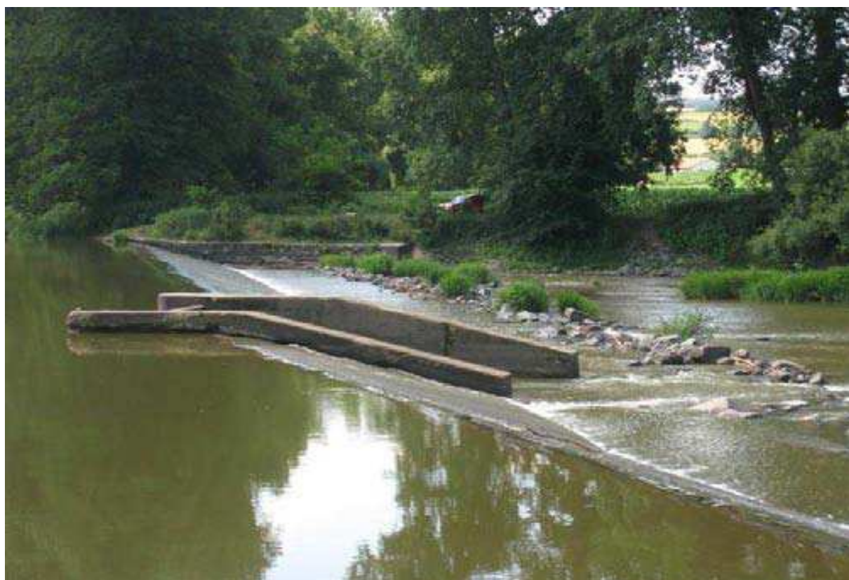
Obr.2. Štěrková propust
