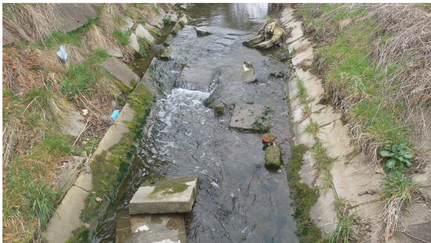
Foto č.13 – Detailní pohled na naplavené bet. desky ve dně nad lávkou v km 9,921
