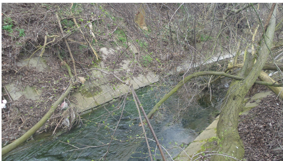
Foto č.30 – Detailní pohled proti vodě na popadané vzrostlé stromy v průtočném profilu koryta nad napouštěcím objektem (km 11,700-11,710)
