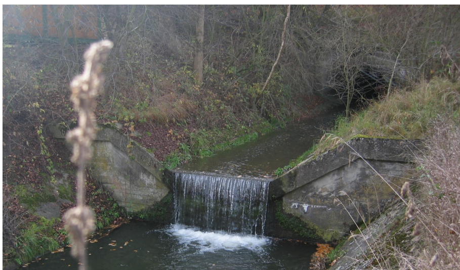
Foto č.48 – Pohled proti vodě na konec řešeného úseku Únětického potoka nad stupněm s vývarem v km 12,384-12,398
