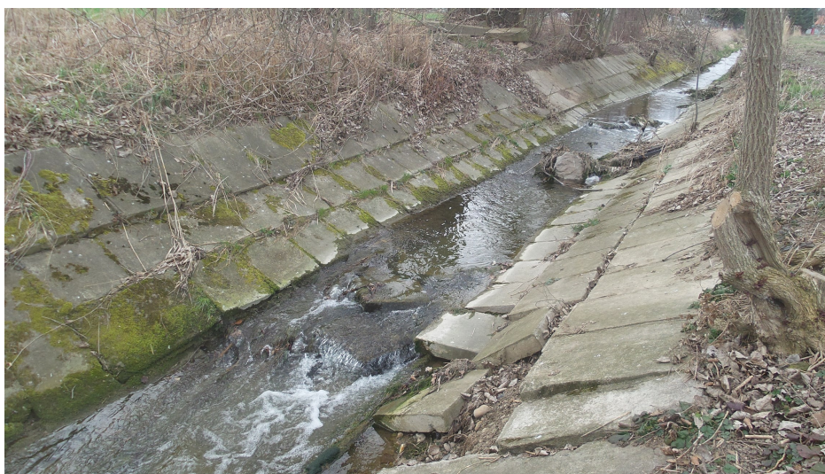
Foto č.23 – Pohled na navazující úsek v km 1,215-10,250 (rozpadlé betonové opevnění, v pozadí nátrž levého břehu v délce 12m), pravostranně hodnotný doprovodný porost nutno zachovat
