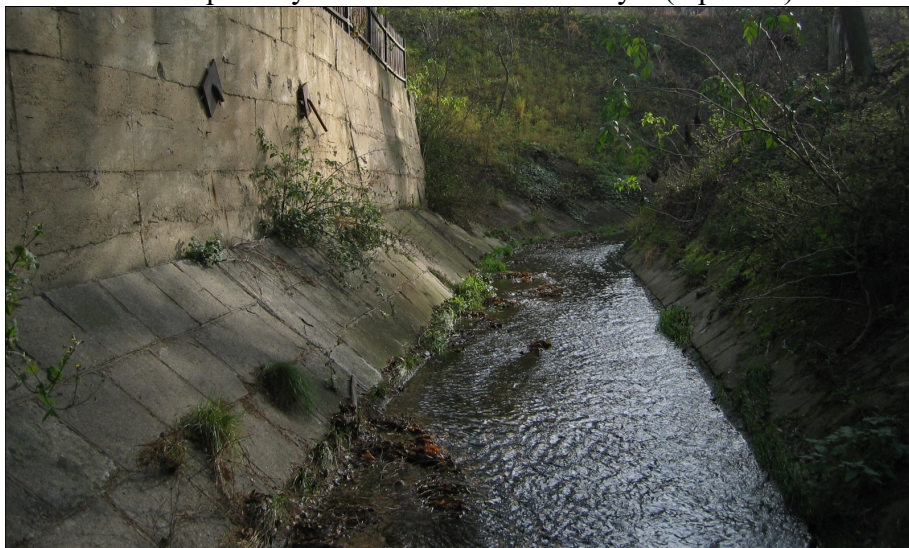
Foto č.38 – Pohled proti vodě na úsek pod betonovou opěrnou zdí v km 11,799-11,838
