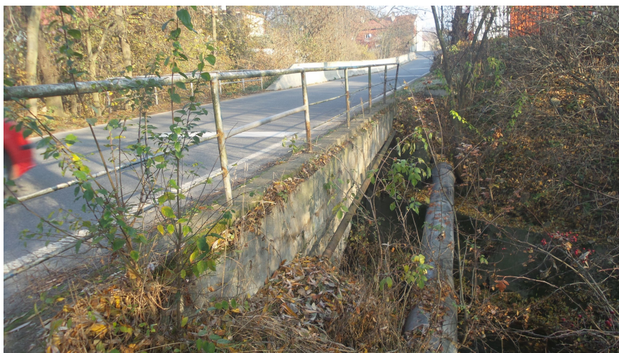
Foto č.45 – Pohled po vodě na vtokovou část mostku v km 12,218 s přechodem IS u vtoku
