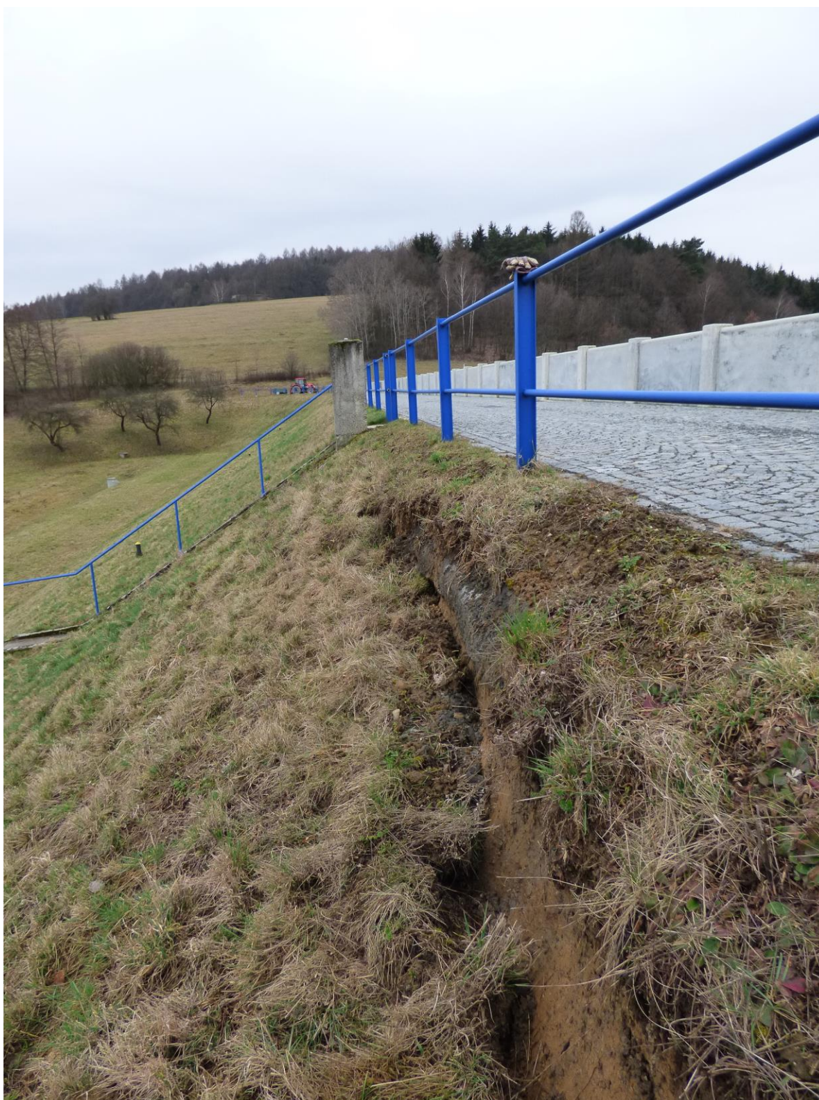
Příloha č. 3 – Zhlaví sesuvu, vytvořeného po deštích v únoru 2016
