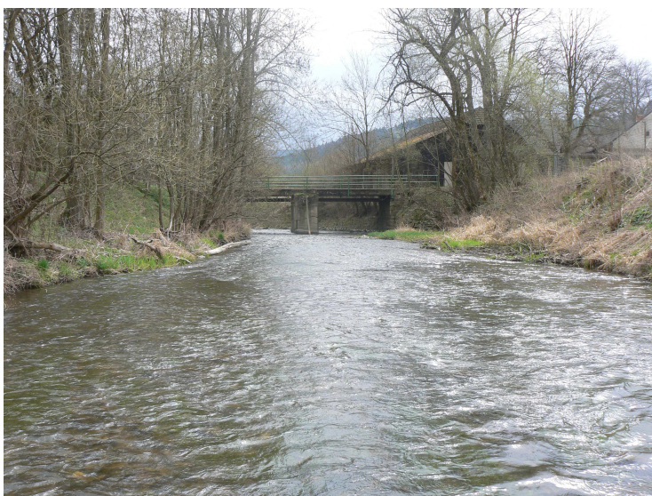
Foto č. 10 Poproudň pohled, v ř. km 6,768
