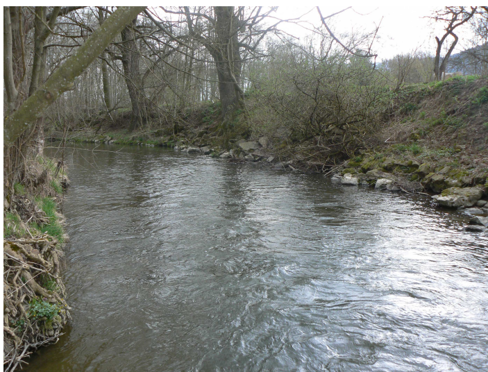
Foto č. 17 Popravní pohled na stávající opevnění určené k přeskládání, v ř. km 6,660
