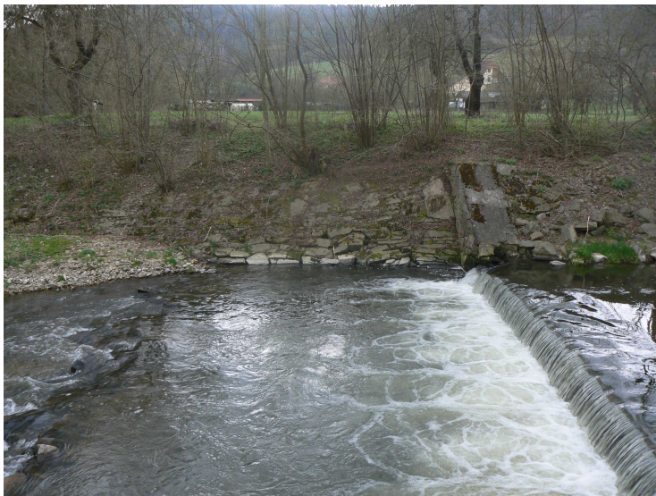
Foto č. 24 Pravý břeh pod stupněm v ř. km 6,590
