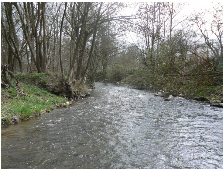
Foto č. 15 Popravní pohled, v ř. km 6,688
