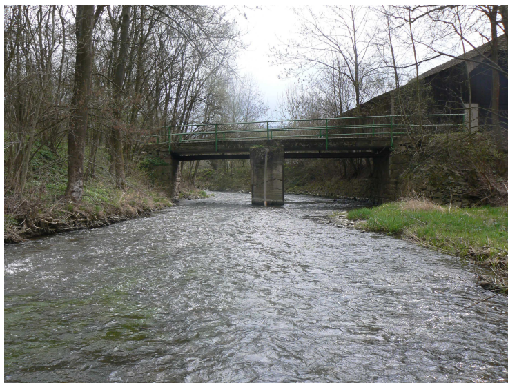
Foto č. 12 Poproudňý pohled na silniční most stojící v ř. km 6,702
