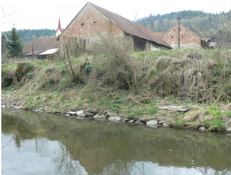
Foto č. 9 Pohled na stávající opevnění určené pro přeskládání, v ř. km 6,768
