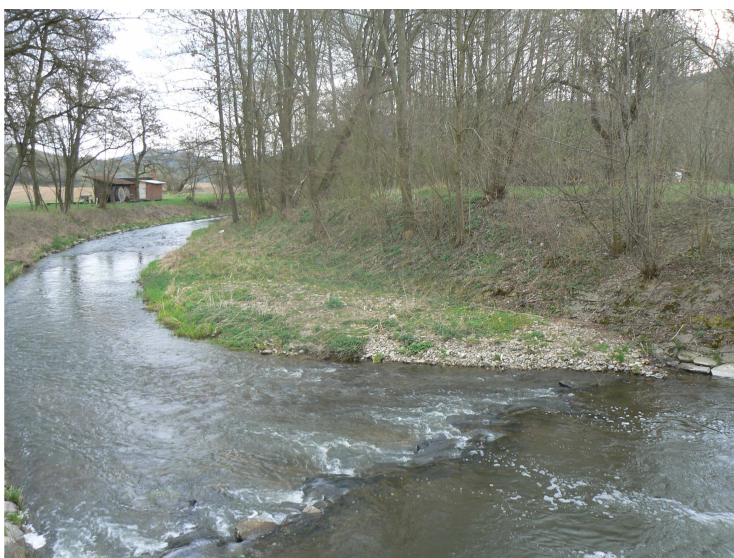
Foto č. 28 Popravní pohled, pod stupněm, štěrková lavice a vývar, v ř. km 6,584
