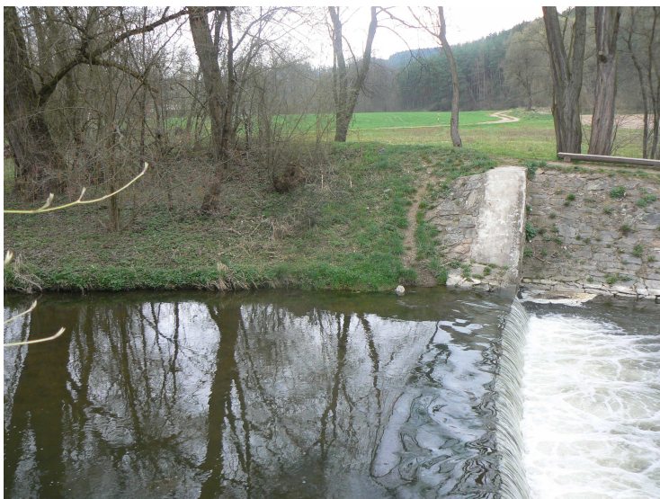
Foto č. 26 Levý břeh nad stupněm v ř. km 6,590
