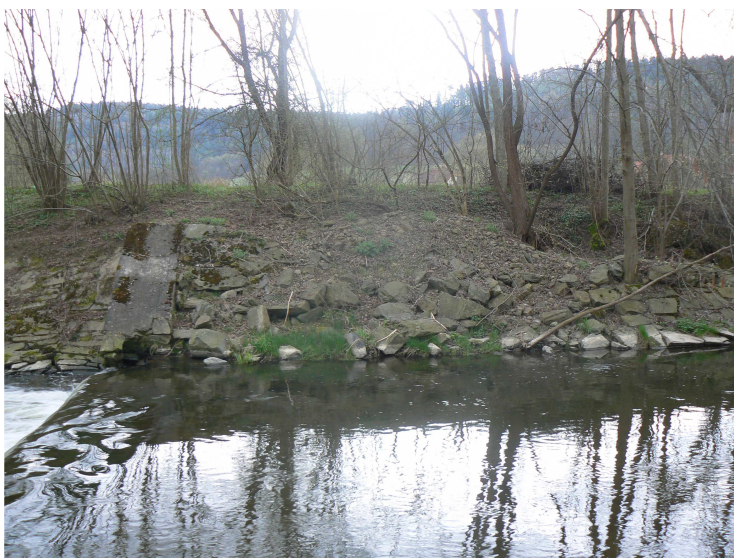
Foto č. 23 Pravý břeh nad stupněm, v ř. km 6,590
