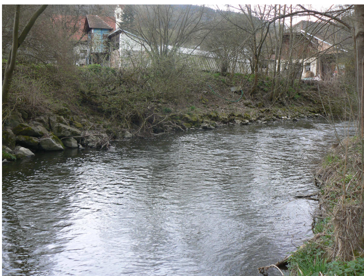
Foto č. 19 Protiproudňý pohled, v ř. km 6,818
