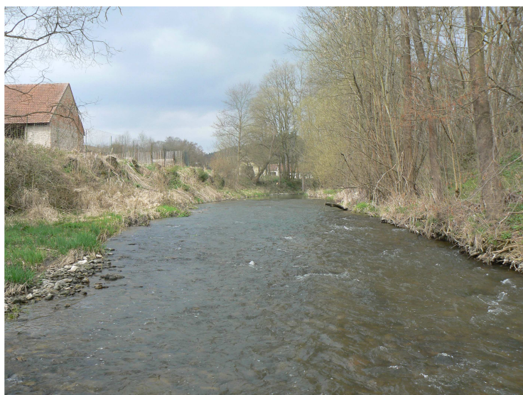
Foto č. 14 Protiproudňý pohled, v ř. km 6,711
