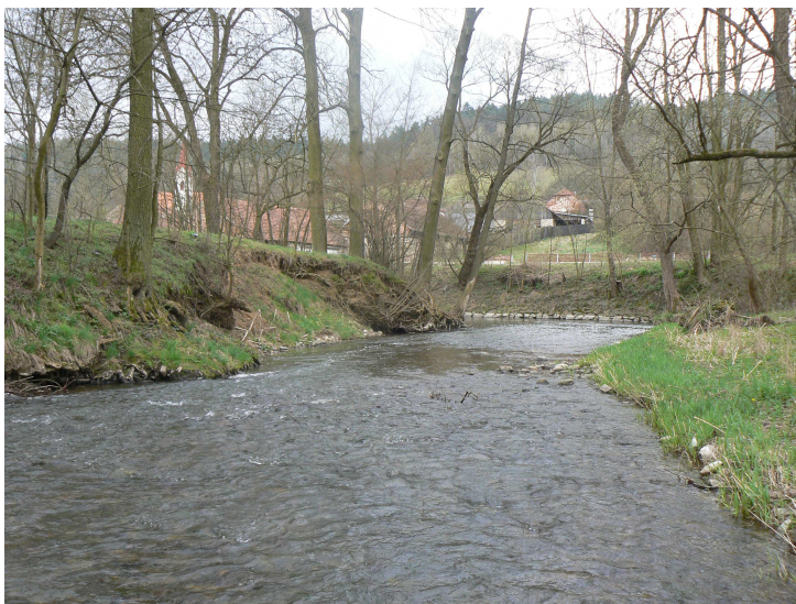
Foto č. 1 Popravní pohled, v ř. km 6,840
