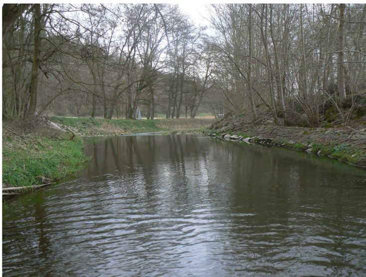
Foto č. 20 Poproudňý pohled (na stupeň), v ř. km 6,600
