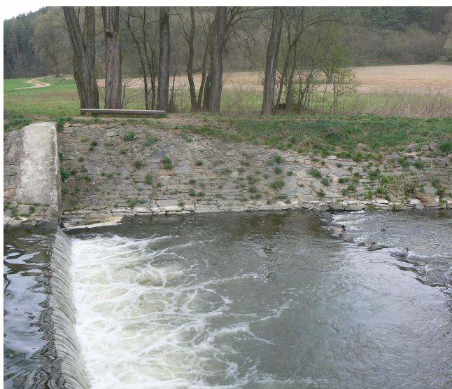
Foto č. 27 Levý břeh pod stupněm v ř. km 6,590
