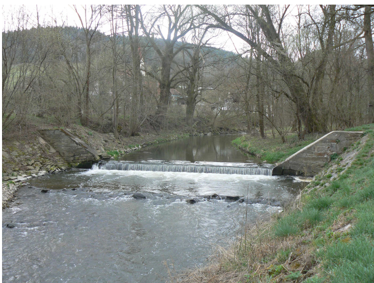
Foto č. 22 Protiproudni pohled na stupeň umístěný v ř. km 6,590
