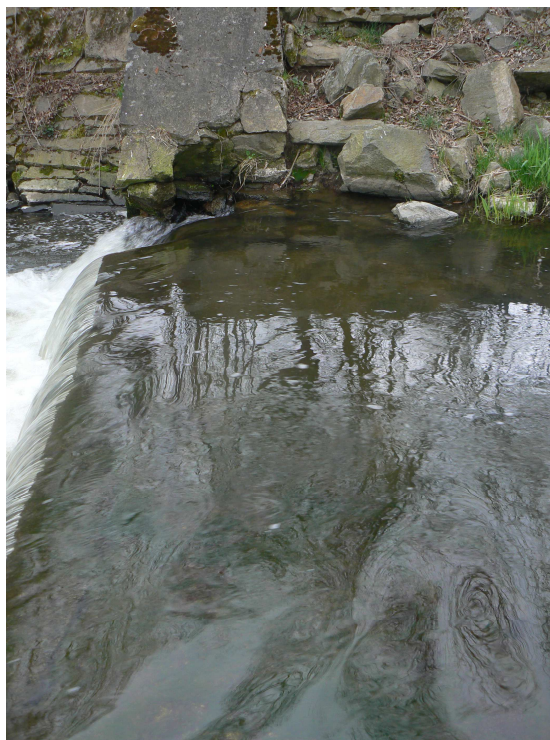
Foto č. 25 Bližší pohled na přeliv a boční parapet stupně na pravém břehu, v ř. km 5,690
