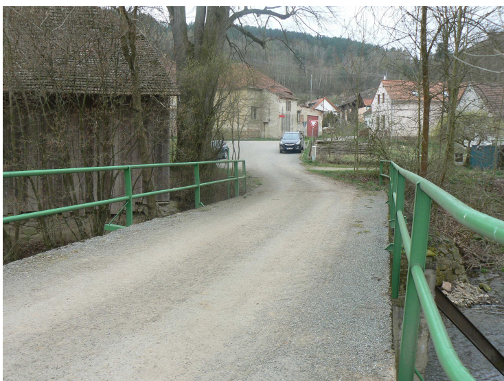
Foto č. 48 Přístupy, na silničním mostě směrem "do obce"
