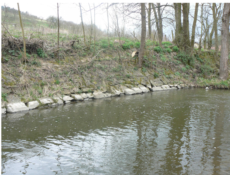
Foto č. 8 Pohled na stávající opevnění určené pro přeskládání, v ř. km 6,808
