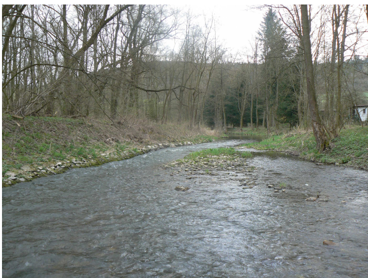
Foto č. 36 Poproudň pohled, v ř. km 6,458
