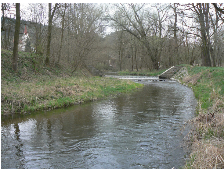
Foto č. 30 Protiproudňý pohled, v ř. km 6,538
