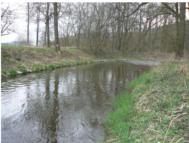
Foto č. 33 Poproudňí pohled, v ř. km 6,478
