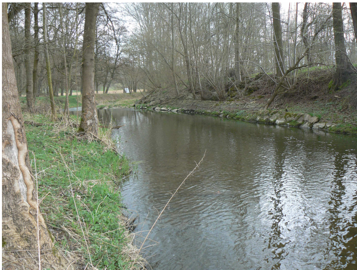
Foto č. 18 Poproudňý pohled (na stupeň), v ř. km 6,618
