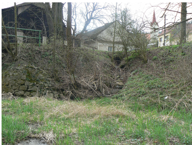
Foto č. 13 Pohled na výust' dešť'ové kanalizace DN 800 na pravém břehu, v ř. km 6,716
