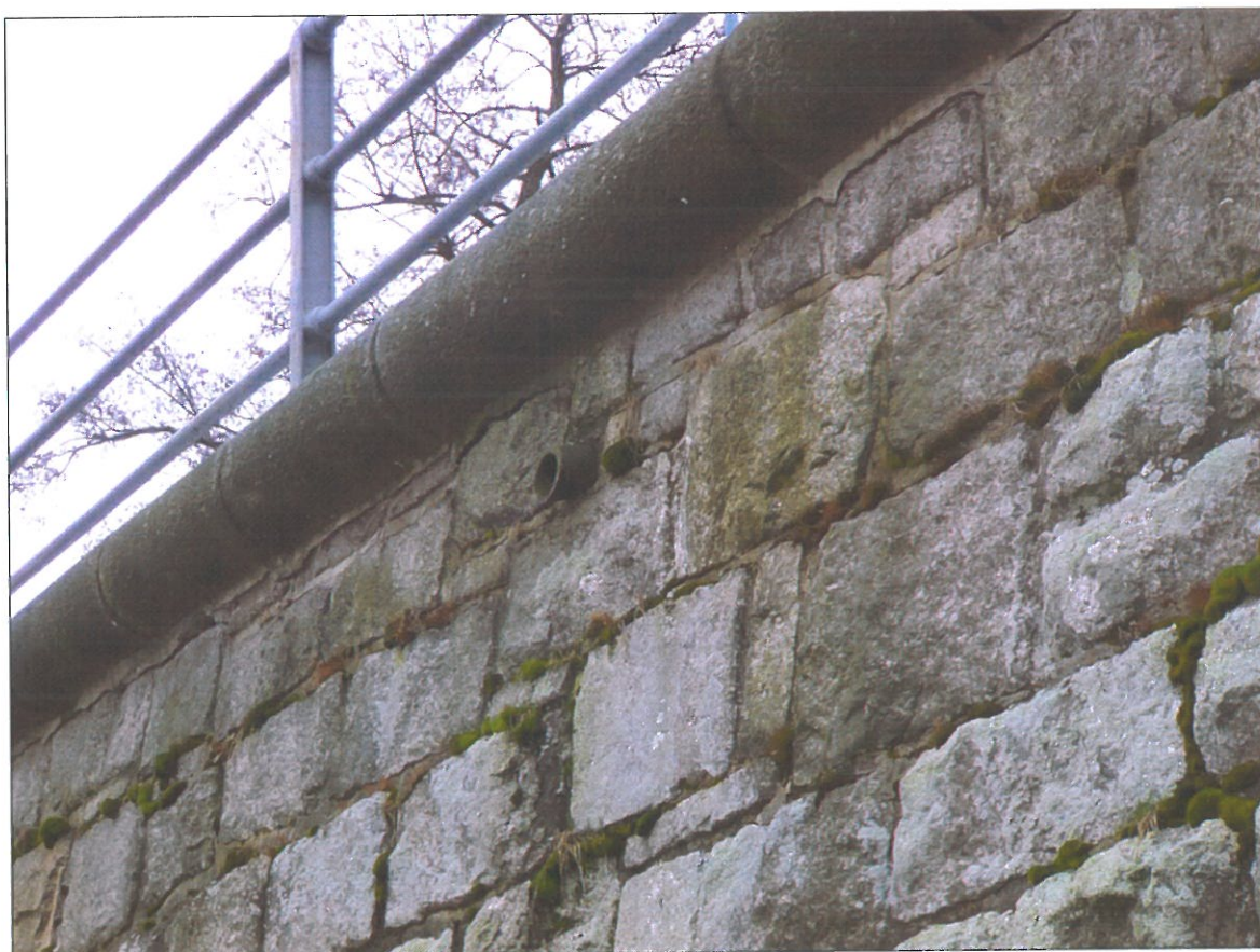
Vyústění odvodnění koruny, poškozené spárování římsových kvádrů
