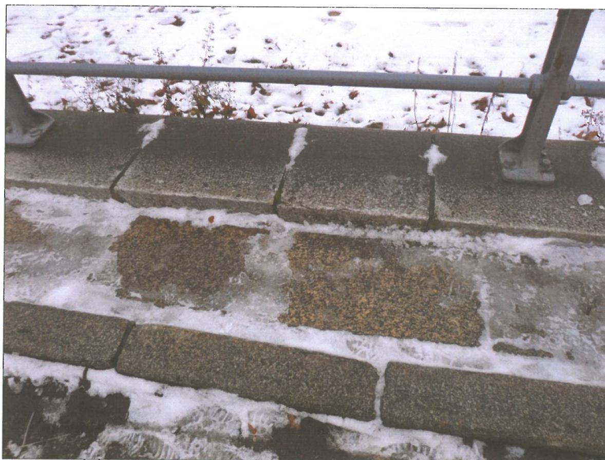
Viditelný odklon římsových kvádrů oproti chodníkové dlažbě, původně zalícováno
