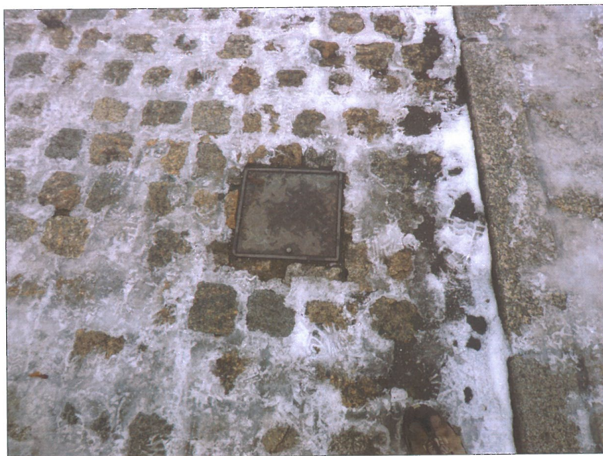
Poklop revizní šachty návodní drenáže
