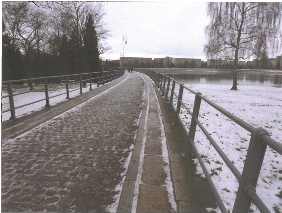
Pohled na korunu z levého zavázání, viditelný odklon sloupků zábradlí od svislé osy
