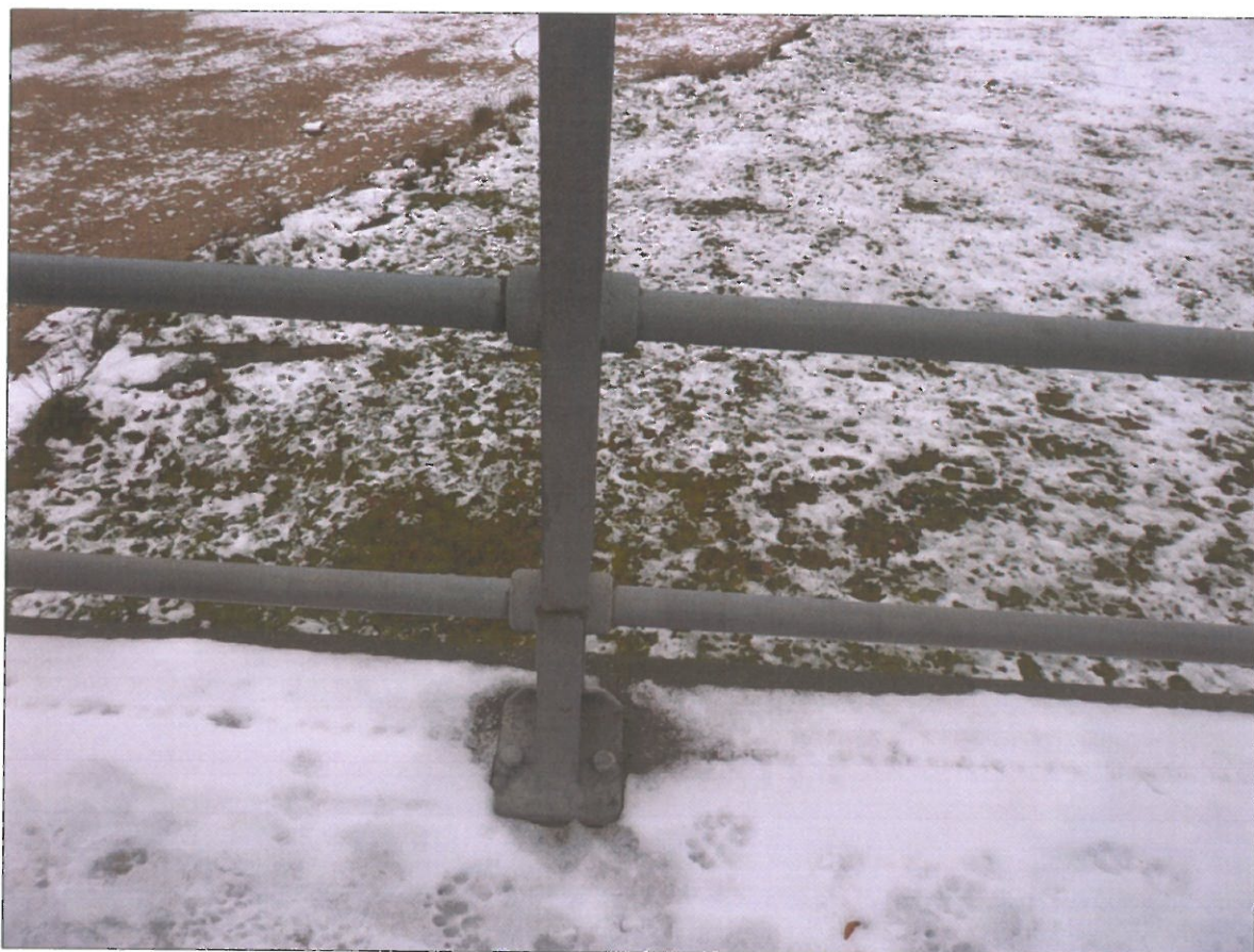
Prasklý litinový sloupek zábradlí na koruňě hráze
