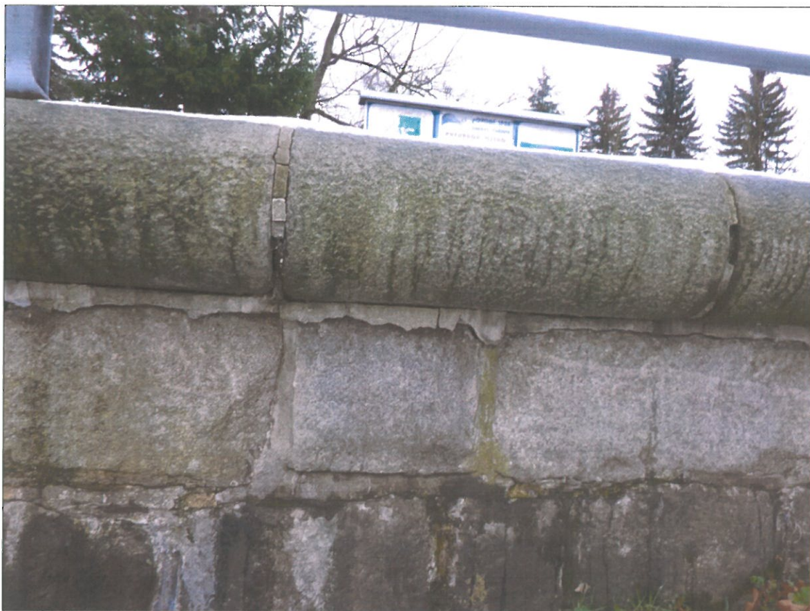
Utržené římsové kvádry, poškozené spárování
