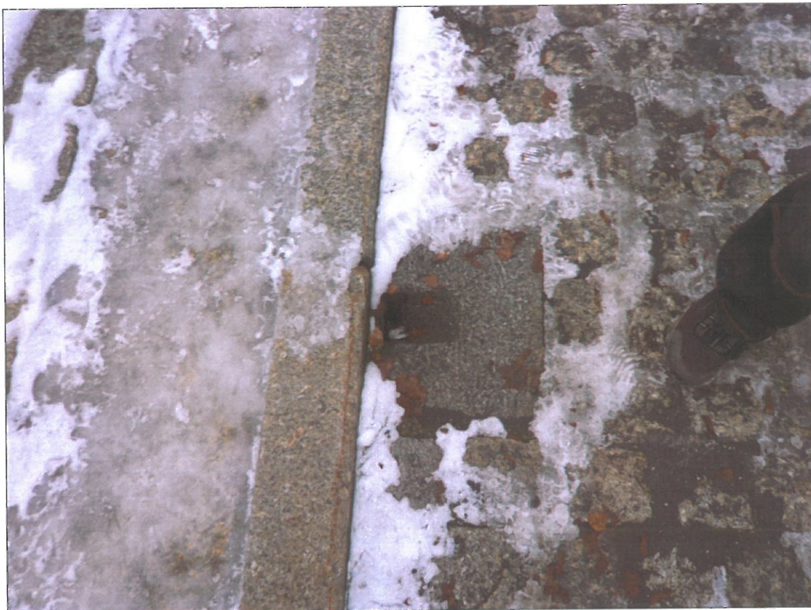
Jedna ze dvou odvodňovacích vpustí na koruně hráze
