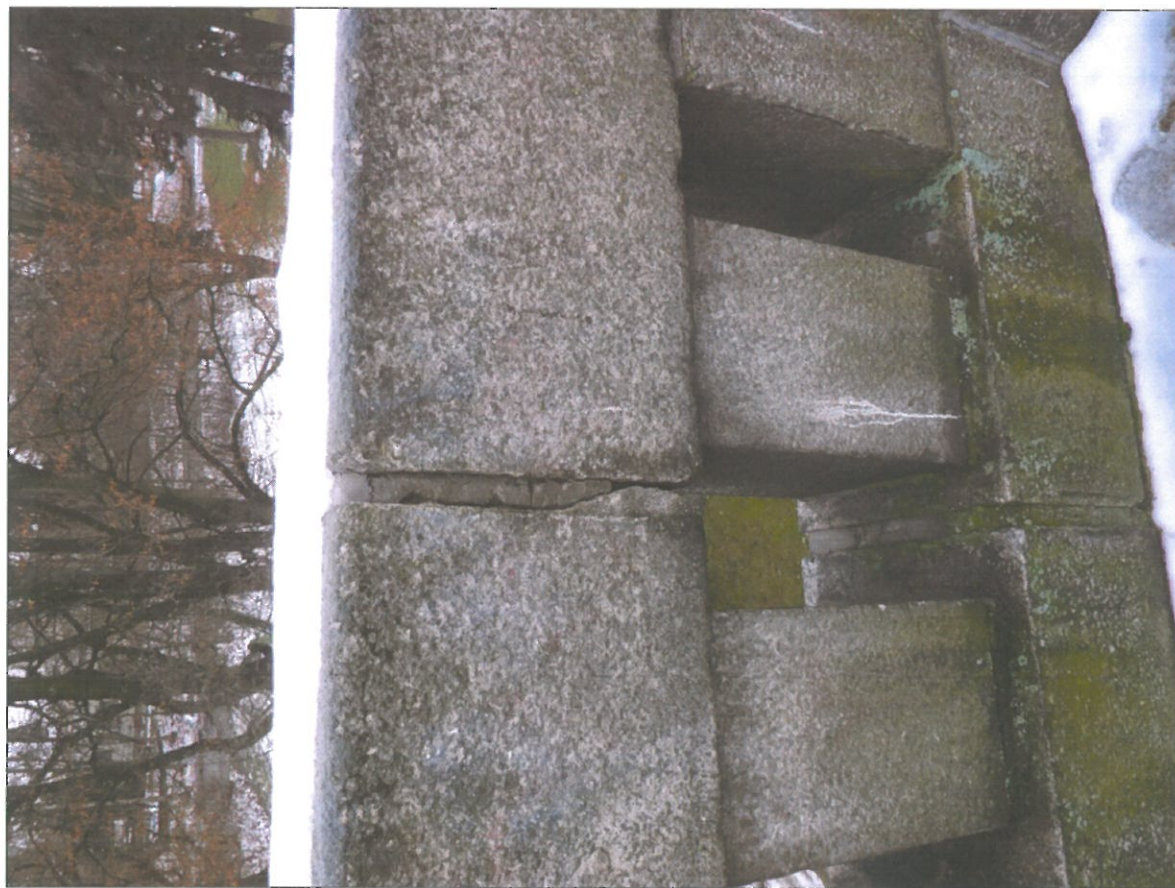
Poškozené spárování kamenného zábradlí balkónu na koruně
