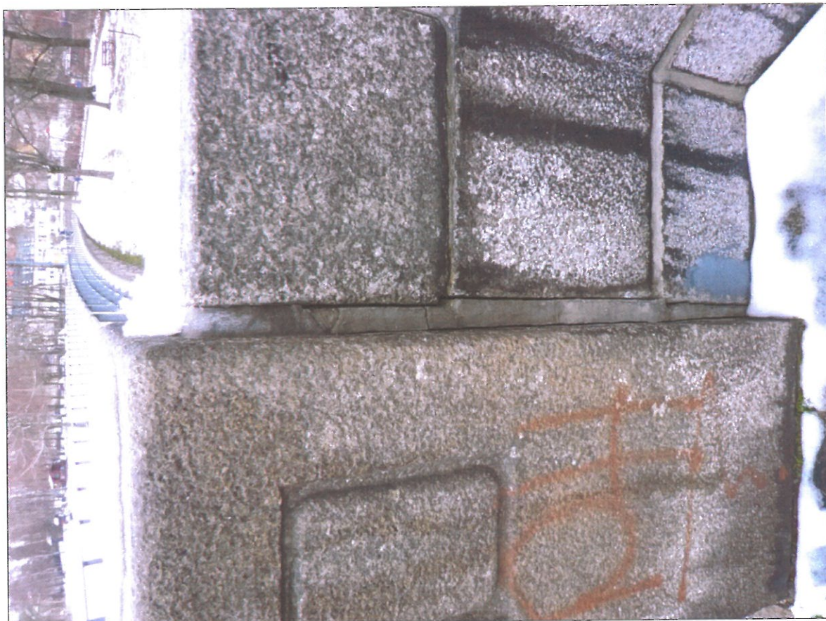
Odpraskané napojení kamenného zábradlí balkónu na pilíř na koruně
