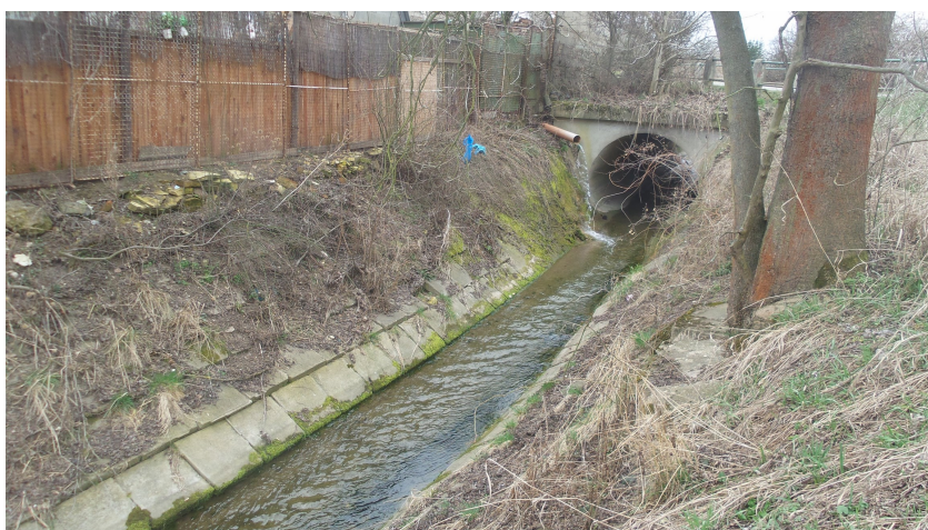
Foto č.9 – Pohled proti vodě na úsek koryta v km 9,800-9,817 pod výtokem ze silničního mostku (zakrytý úsek v km 9,817-9,837 není součástí plánované akce)
