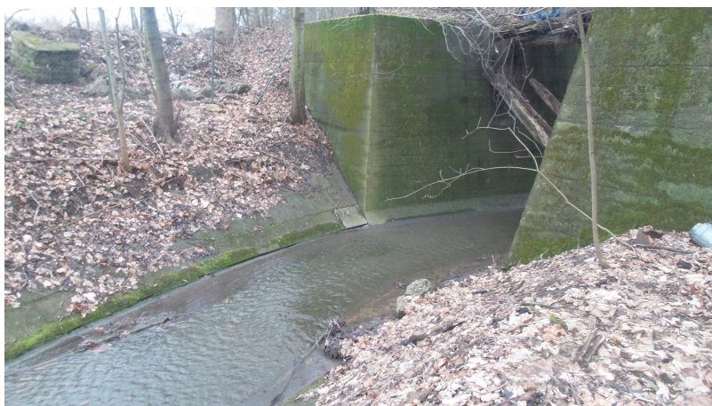
Foto č.1 – Pohled na začátek opravovaného úseku nad vtokem do cestního mostku v km 9,276
