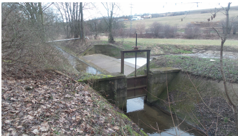
Foto č.7 – Detailní pohled na rozdělovací objekt Tuchoměřického poldru v ř.km 9,712, který byl v nedávné době rekonstruován a pročištěn (úsek podél RO není součástí plánované akce)
