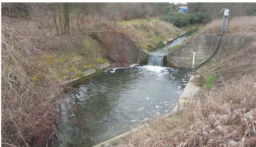
Foto č.11 – Pohled na masivní betonový stupeň s vývarem v km 9,870, na kterém je umístěno měřící zařízení s vodočtem
