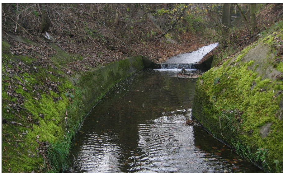
Foto č.39 – Pohled proti vodě na stupeň v km 11,861 a navazující skluzovou trať v konci SO 05
