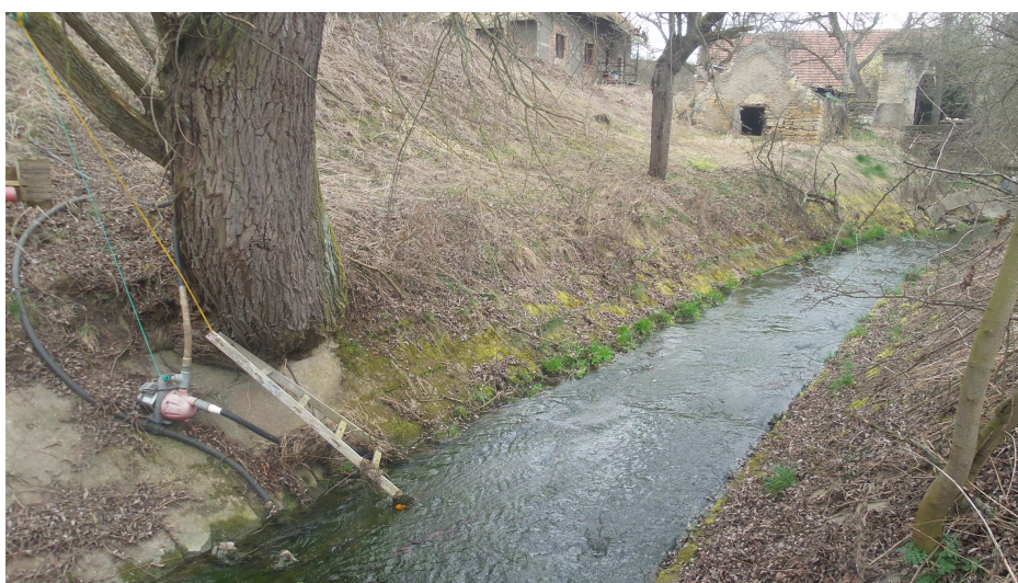
Foto č.36 – Pohled po vodě na narovnaný úsek v zaplacených zahradách v km 11,740-11,770
