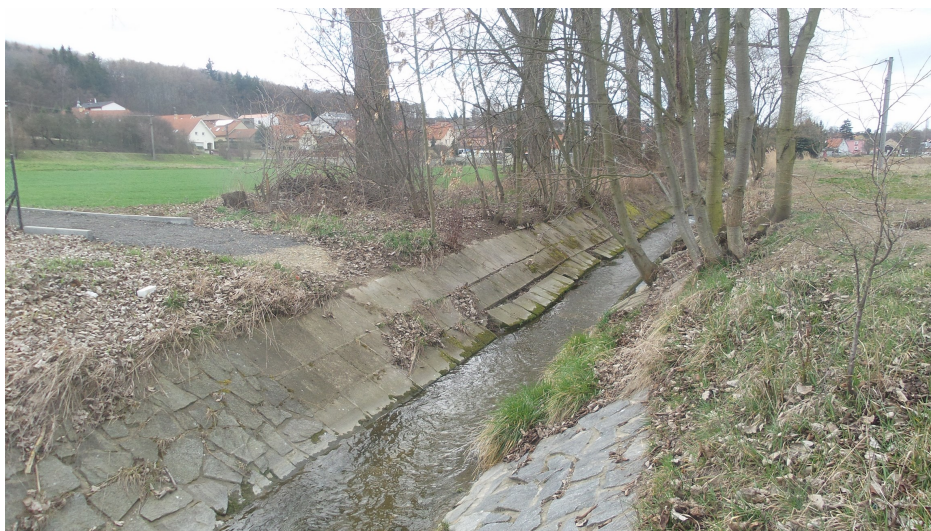
Foto č.22 – Pohled na opravený úsek v km 10,200-10,215 v místě přechodu IS (lichoběžníkové koryto opevněné kamennou dlažbou do betonu – zůstane bez zásahu)
