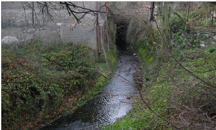
Foto č.40 – Pohled po vodě na začátek úseku SO 06 u vtoku do zakrytého úseku pod areálem Prchalova mlýna v km 11,984 (zakrytý úsek není součástí PD)
