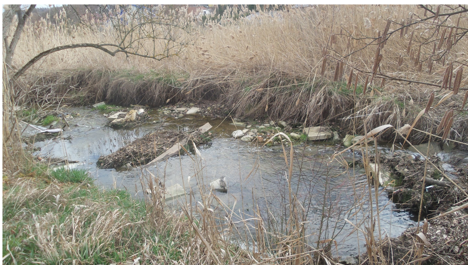
Foto č.20 – Detailní pohled z levého břehu na vzniklou nátrž (v čase neustále dochází k podemílání především pravého břehu, usazování sedimentu a naplavených předmětů v korytě)
