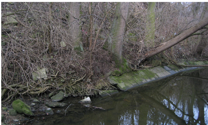
Foto č.42 – Detailní pohled proti vodě na levý břeh v místě obnažených kořenů vzrostlých stromů v místě porušeného betonového opevnění) – km 12,020-12,030
