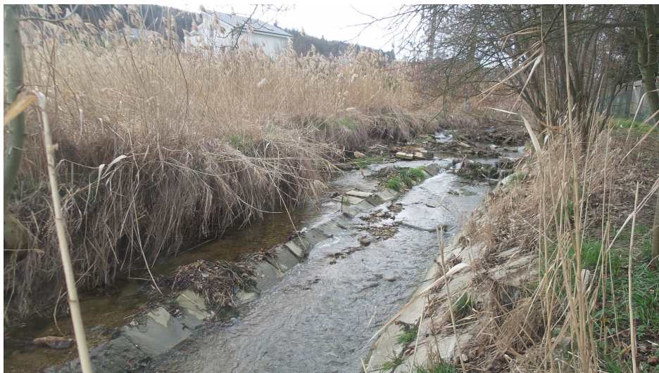
Foto č.19 – Pohled proti vodě na úsek nad stupněm v km 10,100-10,180, kde došlo k úplné destrukci koryta.
