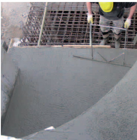
CEMFLOW® – litý cementový potěr
