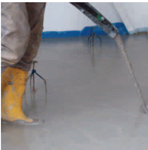
CEMFLOW® – litý cementový potěr
